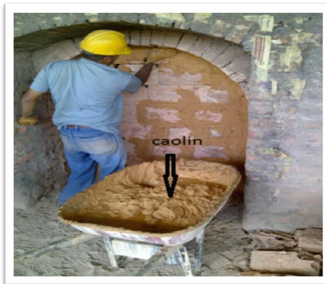
Figura 13. Sellado manual de puertas mediante caolín
