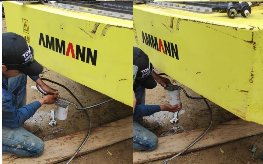
*Nota:* Cambios de aceite del motor y filtros, revisión del sistema eléctrico, cambio del motor de arranque del vibrocompactador.
