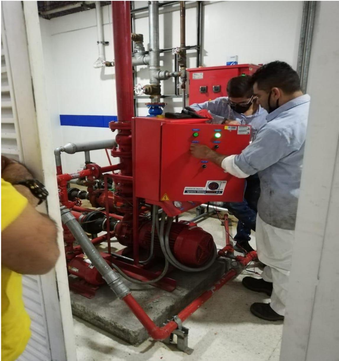
**Figura 41.** *Reparación en el sistema de succión de una de las bombas.*
