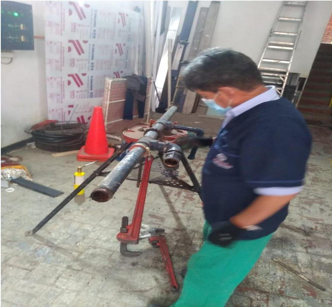
**Figura 40.** *Reparación en el sistema de succión de una de las bombas.*
