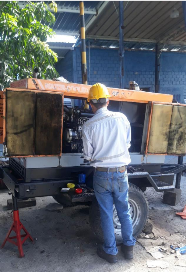
Figura 36. Revisión de generador eléctrico. Fuente. Autor.
