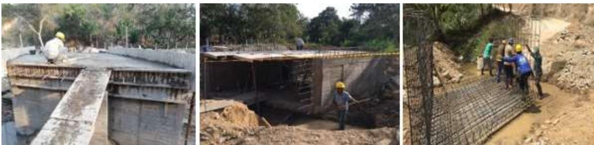
Construcción de Box Culvert para la evacuación de aguas pluviales en el barrio Bolívar del municipio de San Calixto, Norte de Santander, con la finalidad de normalizar el paso vehicular.
