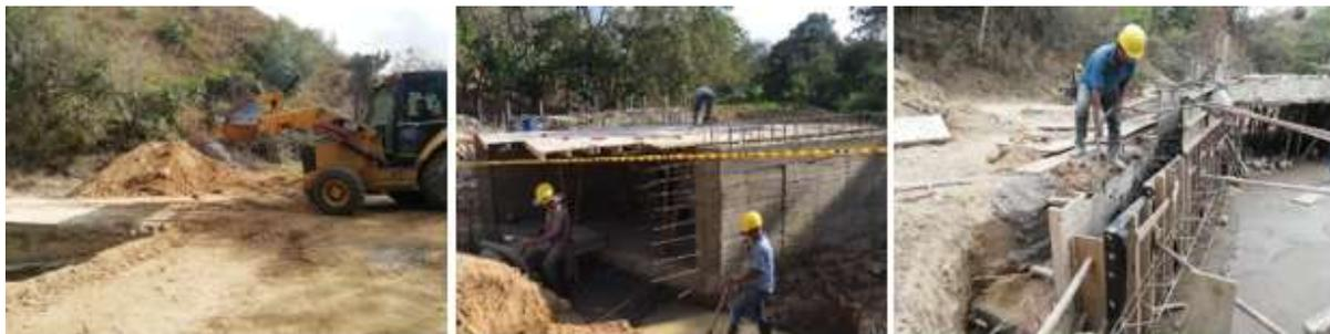
Construcción de Box Culvert en concreto reforzado para el puente vehicular de acceso al sector la unión y mejoramiento del acueducto del sector la unión de la vereda Llano de Los Trigos, corregimiento Llano de Los Trigos del municipio de Ocaña, Norte de Santander.
