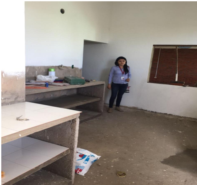
Figura 16. Fundida de mesones en concreto reforzado de 21Mpa con dos entrepaños
