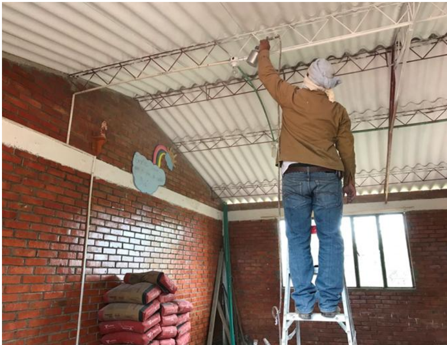
Figura 24. Pintura de la estructura de la cubierta del restaurante
