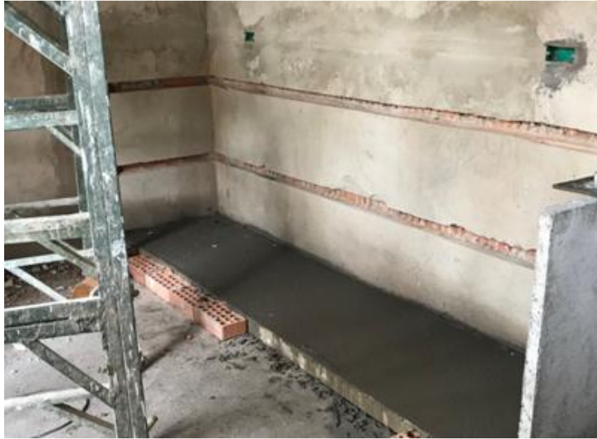
Figura 23. Fundida de mesón en concreto para la cocina
