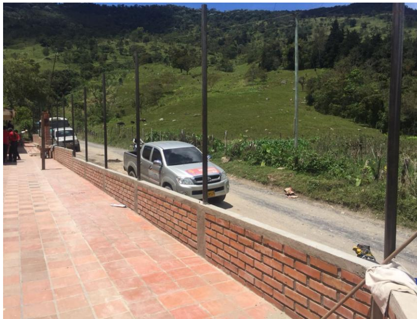
Figura 20. Construcción de la entrada Principal de sede educativa La unión
