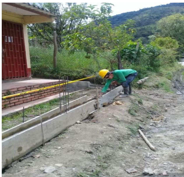
Figura 8. Fundida Viga de cimentación muro de cerramiento
