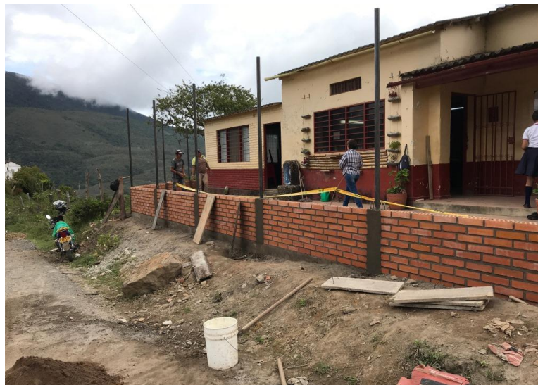
Figura 10. Instalación de muro en ladrillo a la vista para el cerramiento
