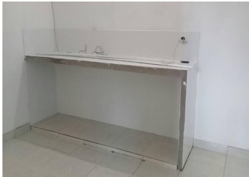
Figura 22. Instalación de cerámica para piso y mesones
