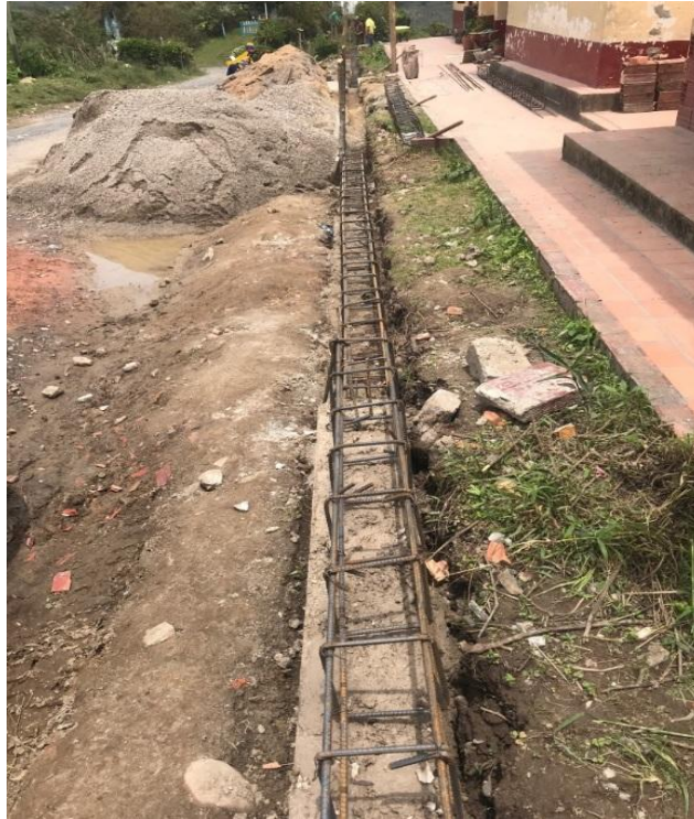
Figura 9. Verificación Acero de Refuerzo Cimentación
