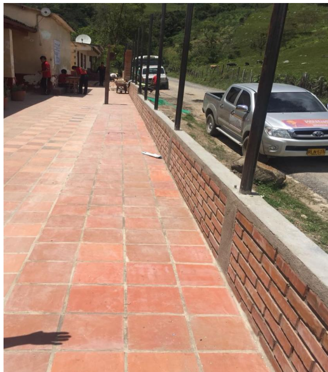
Figura 18. Construcción muro de cerramiento y áreas de circulación
