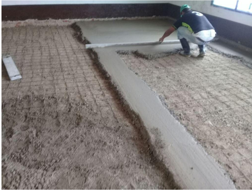
Figura 13. Fundida Antepiso en Concreto con malla eslectrolada
