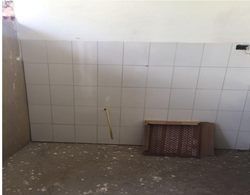
Figura 17. Instalación de cerámica para muros del comedor escolar
