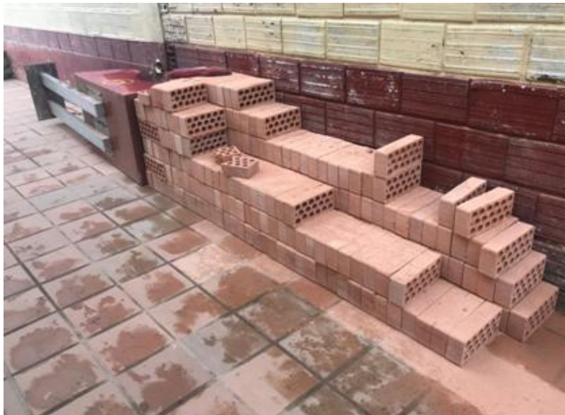
Figura 30. Verificación del ladrillo a la vista utilizado
