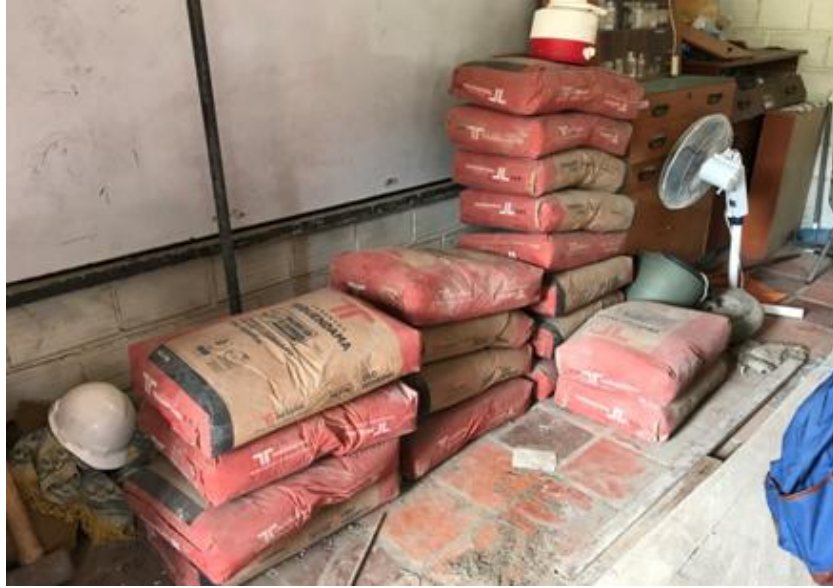
Figura 29. Verificación del estado del cemento a utilizar
