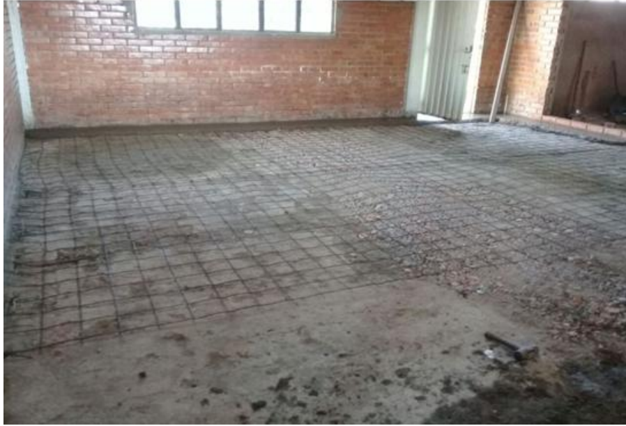
Figura 31. Verificación de la malla electrosoldada utilizada
