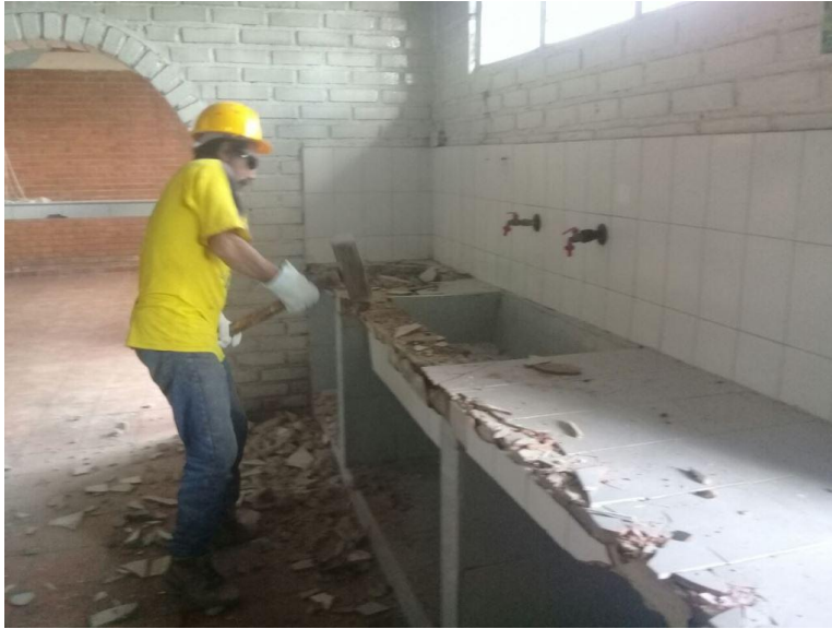
Figura 15. Demolición mesones comendo escolar
