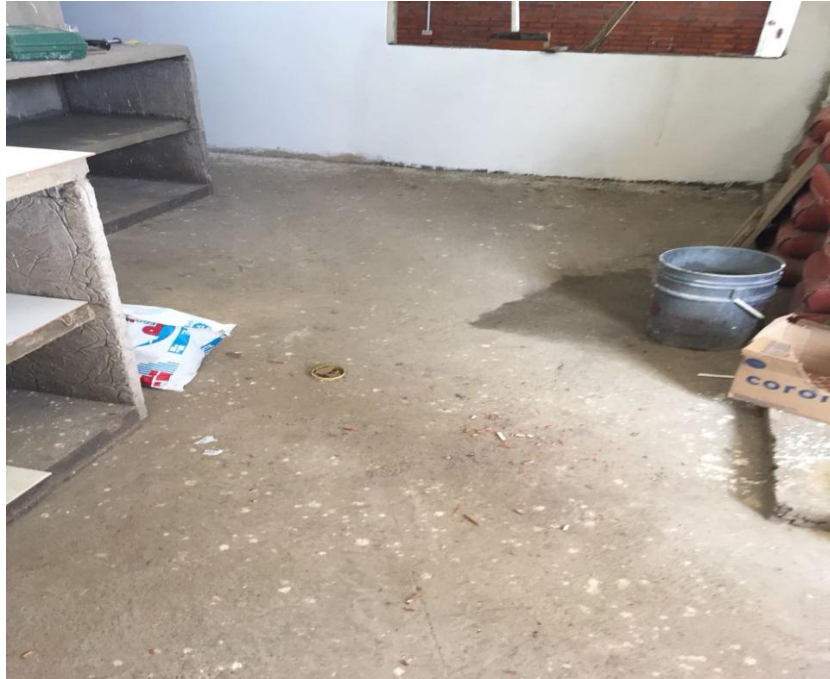
Figura 19. Instalación de antepiso para cocina
