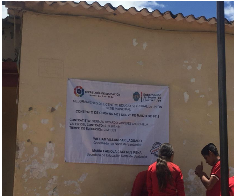
Figura 25. Instalación de valla informativa de la obra
