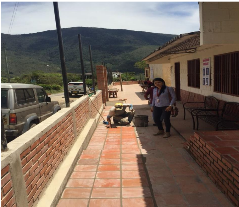
Figura 12. Instalacion piso en tableta de gres area de ciruclación
