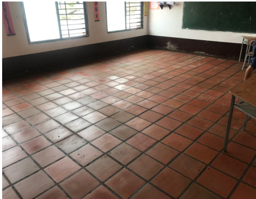
Figura 14. Instalación piso en tableta de gres Aula de clase
