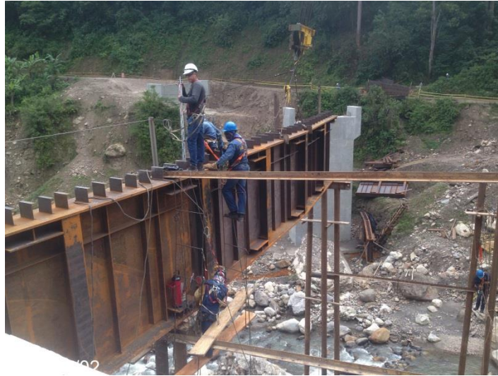
Figura 36. Instalación de soldadura en los tramos de la estructura metálica Fuente: Pasante
