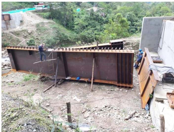
Figura 73. Tramos a instalar en el eje “C”
