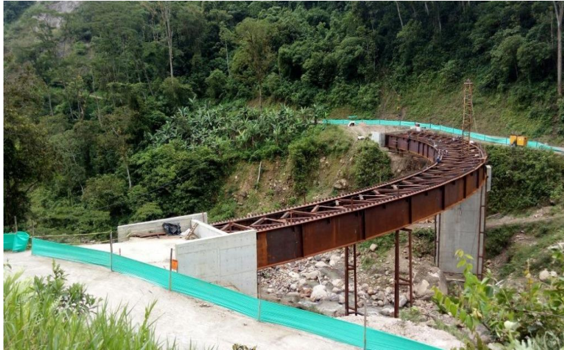
Figura 80. Vista panorámica desde el eje “A” del puente quebrada el oro Fuente: Pasante
