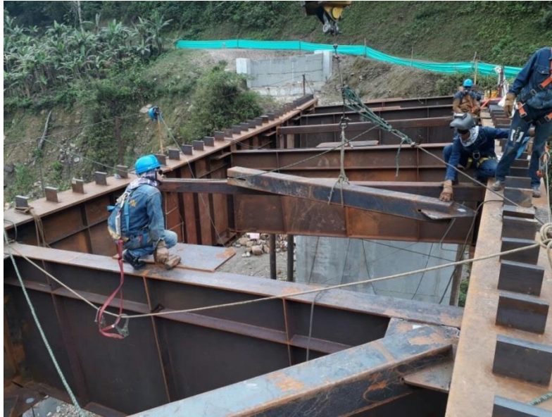
Figura 64. Instalación de vigas transversales de la estructura metálica Fuente: Pasante
