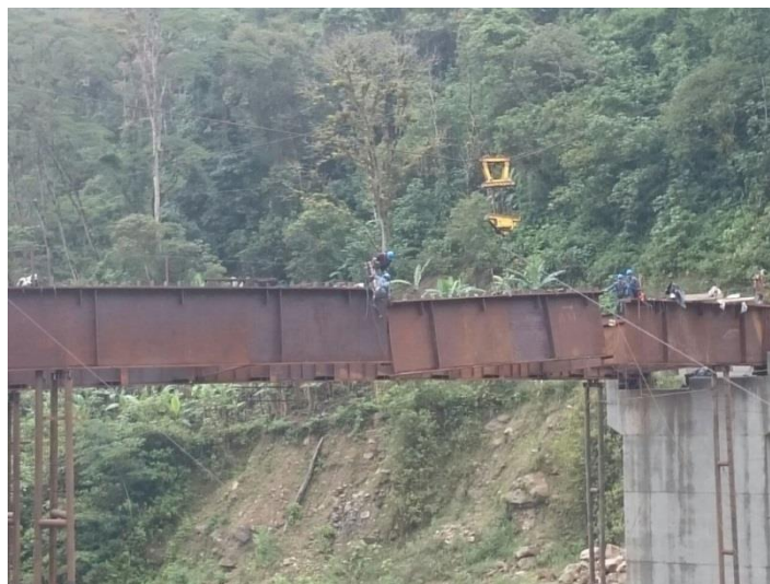
Figura 53. Vista frontal, aguas arriba
