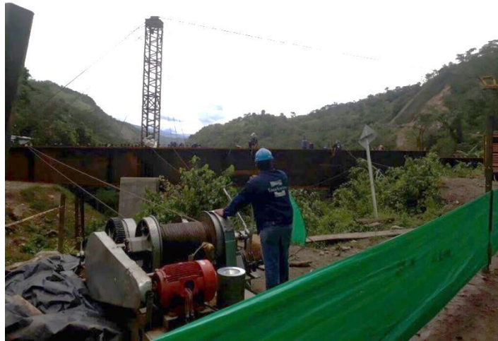
Figura 76. Prueba de carga de teleférico y verificación de winches. Eje “C”
