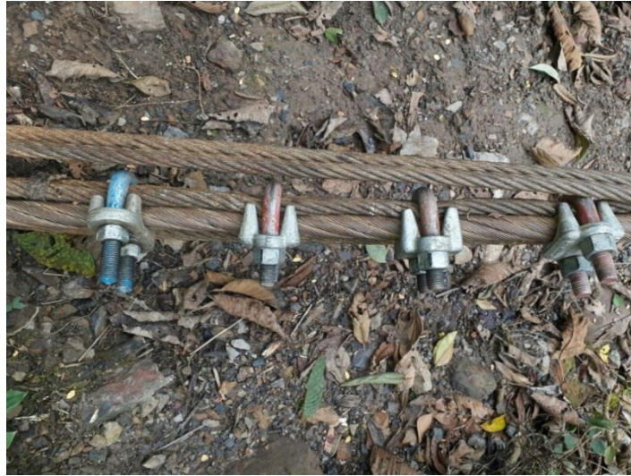
Figura 60 Verificación de los pernos de seguridad de los anclajes del teleférico Fuente: Pasante
