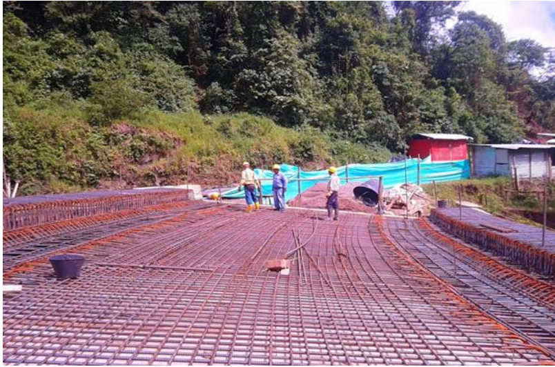
Figura 88. Instalación de acero de refuerzo
