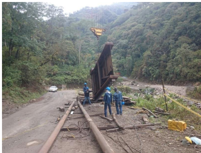
Figura 41. Instalación de los tramos en el eje “B” del puente Quebrada el Oro Fuente: Pasante
