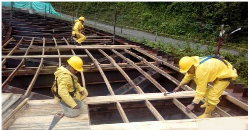
Figura 84. Instalación de tablero sobre a estructura metálica Fuente: Pasante
