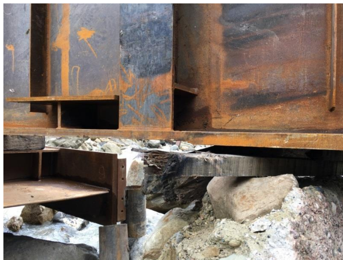
Figura 51. Verificación de calibres y espesores del acero estructural
