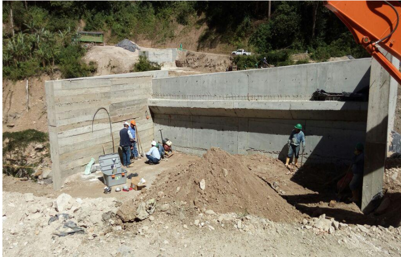
Figura 24. Compactación y ensayo de densidades en el eje “A”
