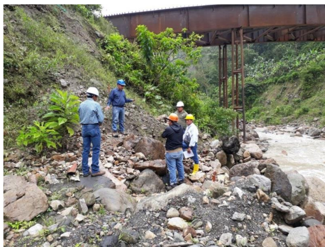
Figura 83. Visita técnica al puente quebrada el oro Fuente: Pasante
