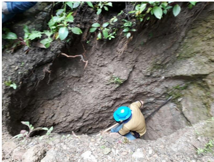
Figura 66. Excavación para anclaje de muertos del teleférico
