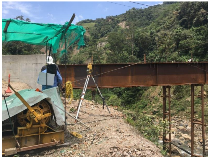
Figura 54. Supervisión y control por parte de interventoría
