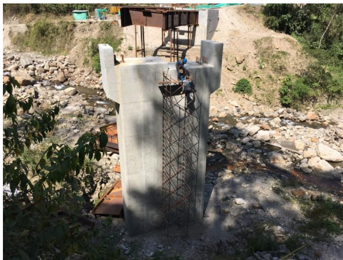
Figura 39. Vista panorámica de la estructura metálica del puente Quebrada el Oro Fuente: Pasante
