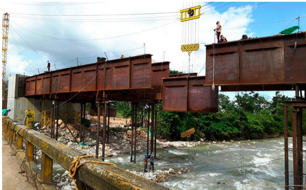
Figura 1. Teleférico para la instalación de estructura metálica
