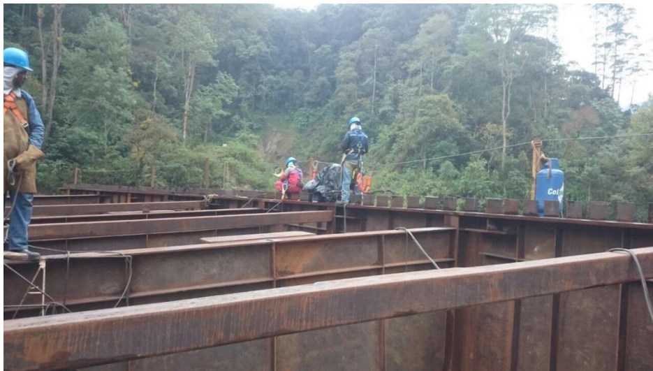
Figura 42. Ensayo de ultrasonido en los diferentes tramos del puente Quebrada el Oro
