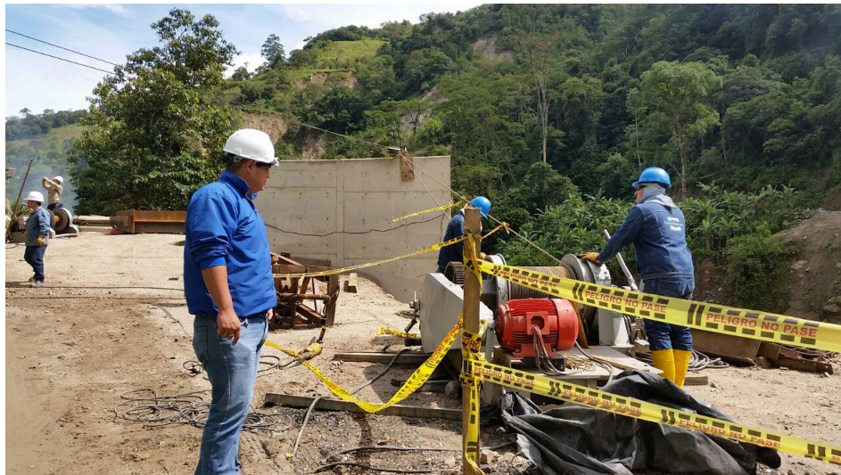
Figura 31. Prueba de carga de teleférico y verificación de winches
