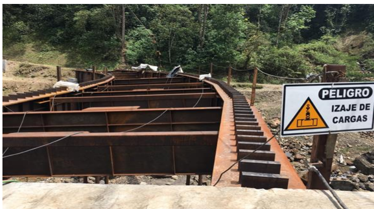
Figura 55. Supervisión y control por parte de interventoría Fuente: Pasante
