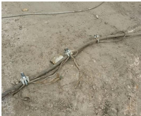
Figura 32. Verificación de los pernos de seguridad de los anclajes del teleférico
