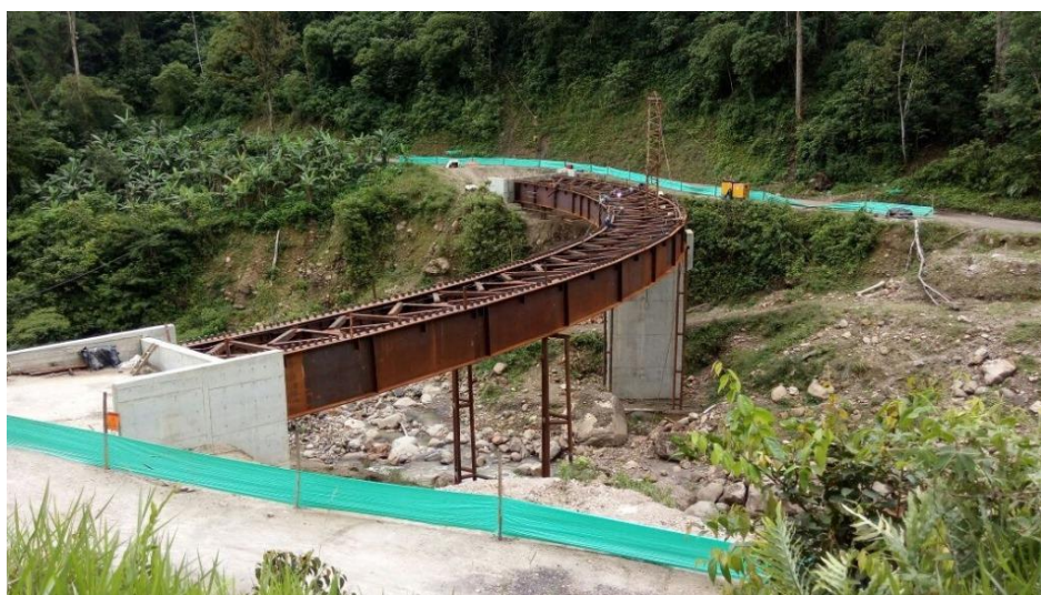
Figura 79. Vista panorámica desde el eje "A" del puente quebrada el oro
