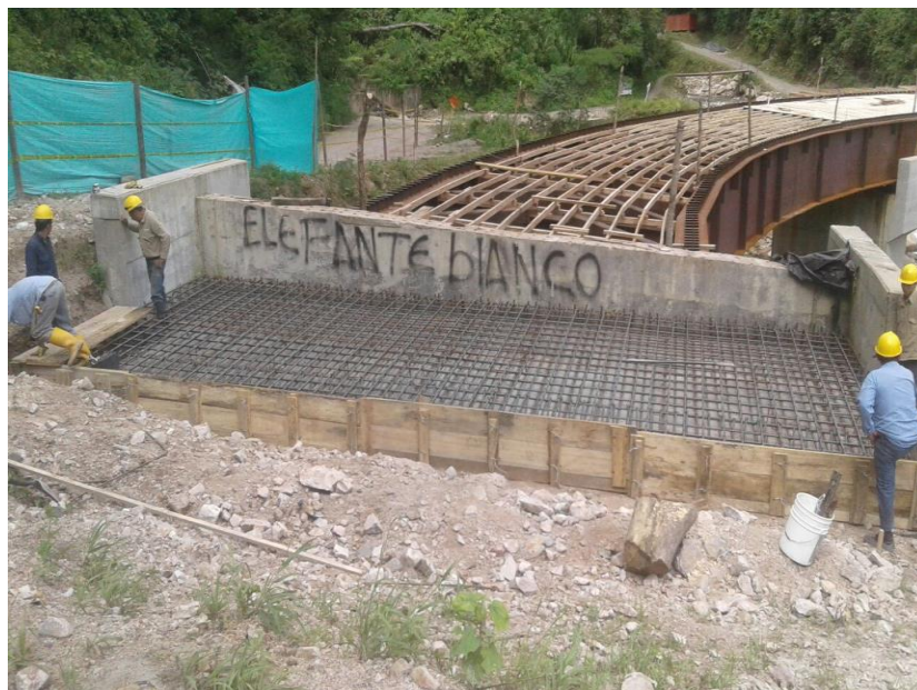
Figura 86. Instalación de tablero y acero de refuerzo Fuente: Pasante
