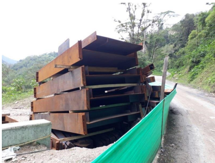
Figura 75. Tramos a instalar de la estructura metálica en el eje “C”
