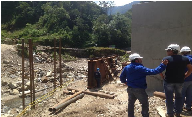
Figura 28. Supervisión de instalación los apoyos provisionales Fuente: Pasante
