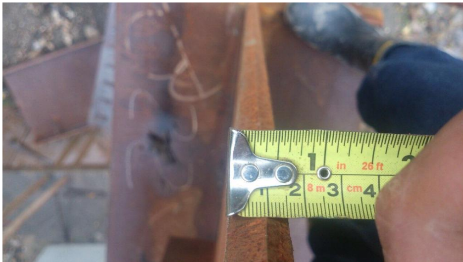
Figura 50 Verificación de calibres y espesores del acero estructural
