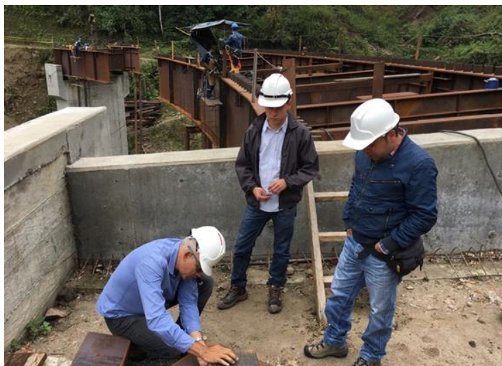
Figura 48. Verificación de calibres y espesores del acero estructural
