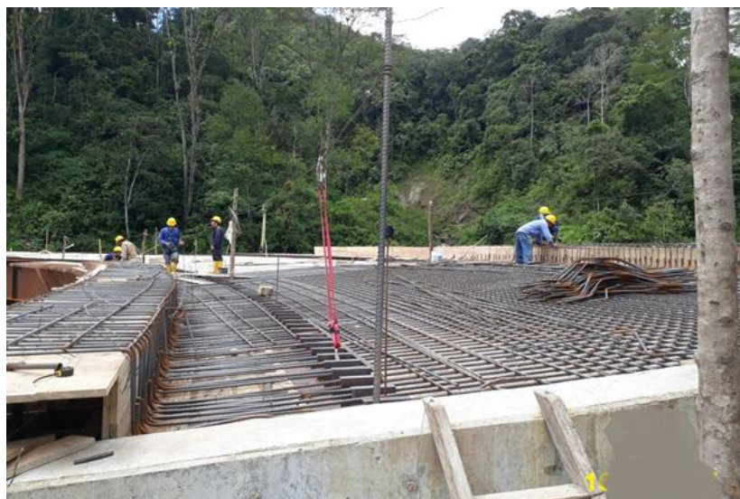
Figura 84. Instalación de tablero sobre a estructura metálica Fuente: Pasante
