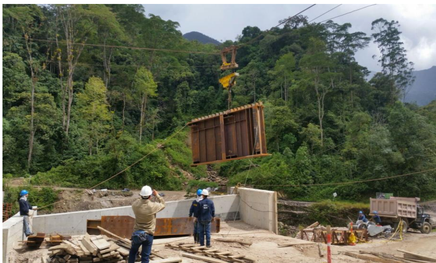
Figura 29. Prueba de carga de teleférico Fuente: Pasante
