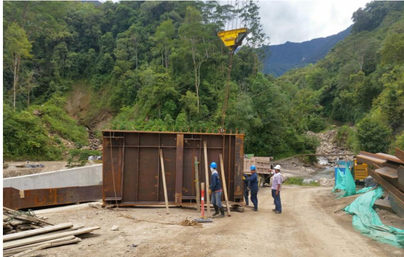
Figura 26. Prueba de carga del teleférico, para el transporte de tramos de la estructura metálica Fuente: Pasante
