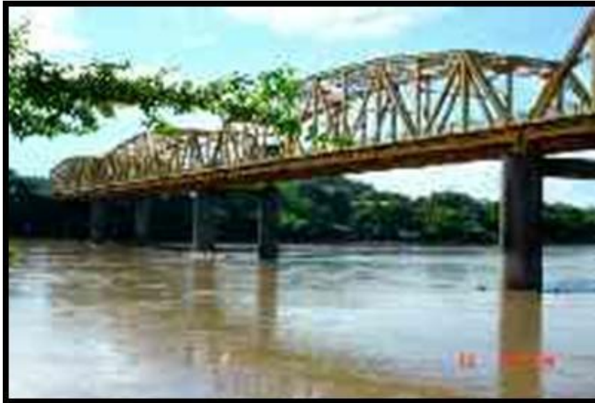
Figura 10. Puentes de armaduras
