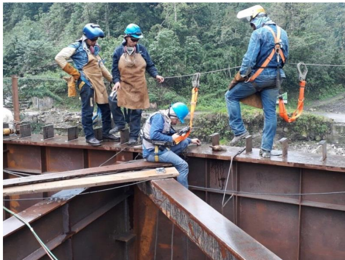
Figura 70. Ensayo de ultrasonido en los diferentes tramos del puente Quebrada el Oro Fuente: Pasante
