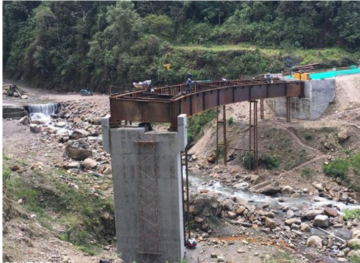
Figura 58 Instalación de soldadura en la estructura metálica entre ejes “A y “B”
