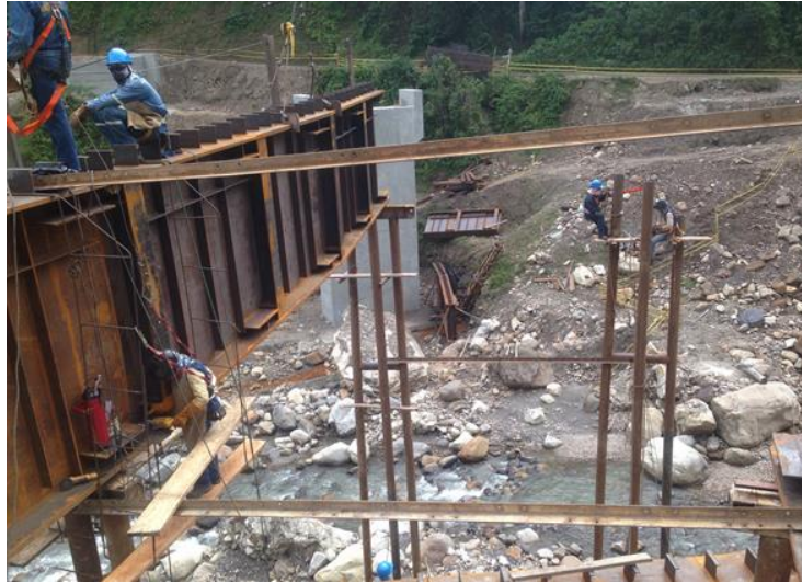
Figura 34. Instalación de soldadura en los tramos de la estructura metálica Fuente: Pasante
