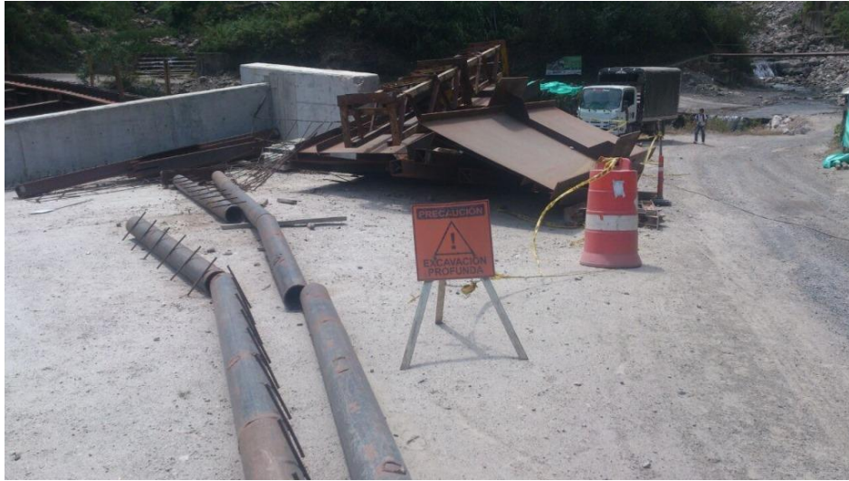
Figura 40. Material acopiado de estructura metálica del puente Quebrada el Oro Fuente: Pasante
