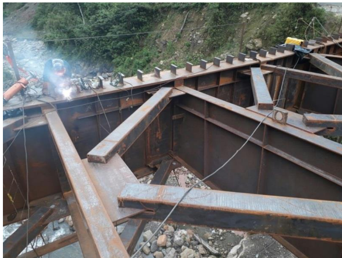
Figura 62. Instalación de soldadura en los tramos de la estructura metálica
