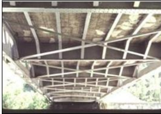
Figura 4. Vista inferior de las vigas transversales y longitudinales de un puente de cerchas de acero Fuente: www.google.com
