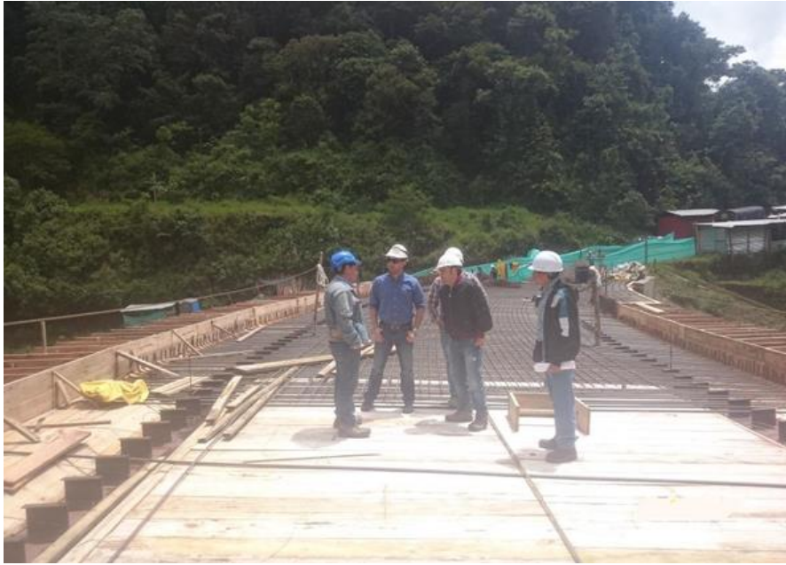
Figura 86. Instalación de tablero y acero de refuerzo Fuente: Pasante
