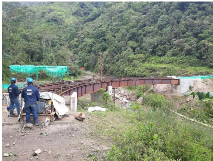
Figura 81. Vista panorámica desde el eje “C” del puente quebrada el oro Fuente: Pasante
