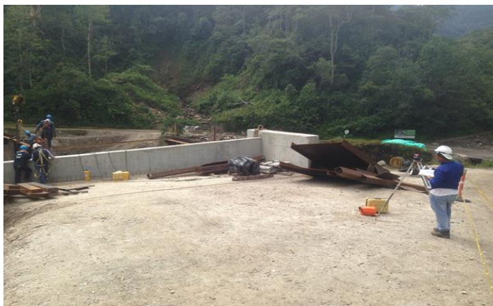
Figura 33. Verificación de tramos de la estructura metálica Fuente: Pasante
