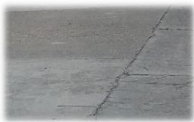
**Figura 5.** Daño en juntas - Separación de juntas longitudinales (SJ) Fuente Autor 2018.
