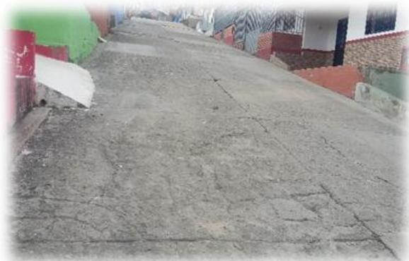
**Figura 3.** Grieta en bloque o fracturación múltiple (GB) Fuente Autor 2018.
