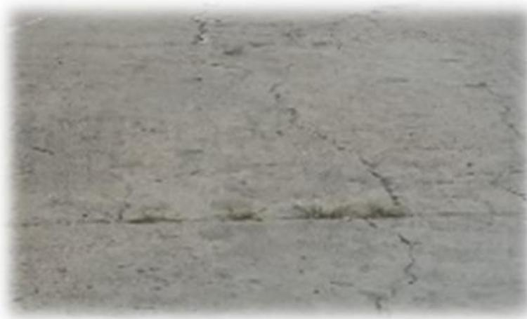
**Figura 2.** Grietas Longitudinales (GL) Fuente Autor 2018
