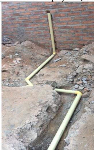
**Fotografía 41.** Tuberías sanitarias PVC 2''
