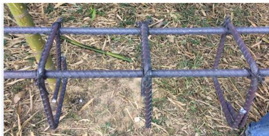
**Fotografía 10.** Armado acero transversal
