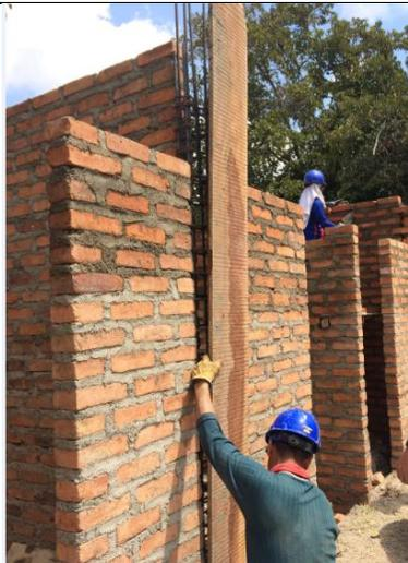
**Fotografía 19.** Encofrado de columna
