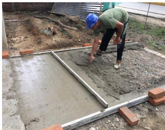
**Fotografía 24.** Losa en concreto
