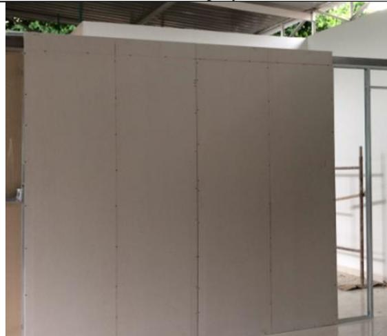
**Fotografía 45.** Muro en drywall
