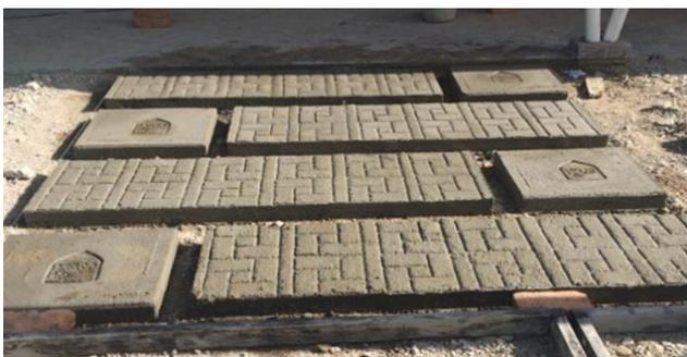
**Fotografía 29.** Losa en concreto estampado
