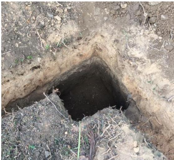
**Fotografía 7.** Excavación de zapatas
