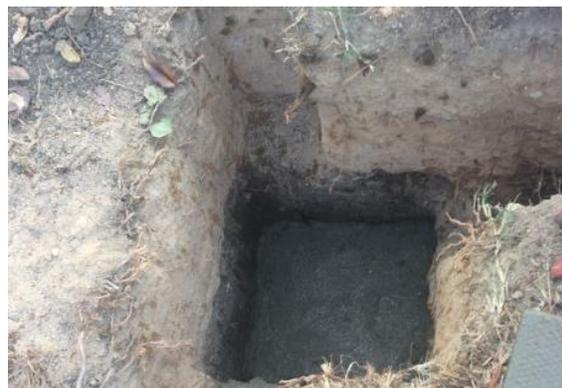
**Fotografía 12.** Concreto ciclópeo zapata
