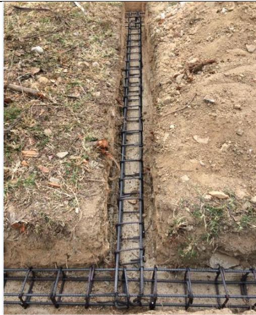
**Fotografía 14.** Armado de vigas
