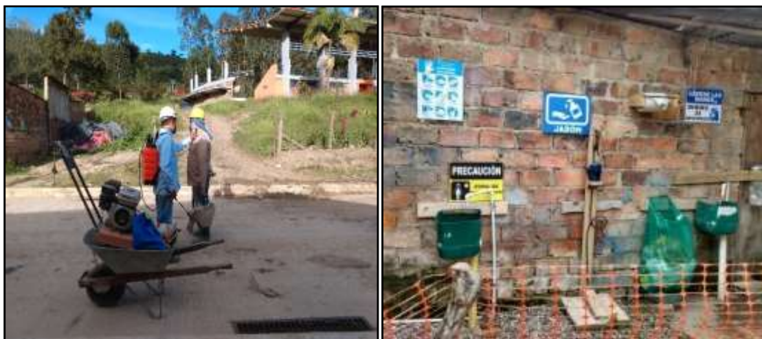
Figura 26. Elementos de bioseguridad en obra, Proyecto de estudio No.4 Fuente: Autores del Proyecto.
