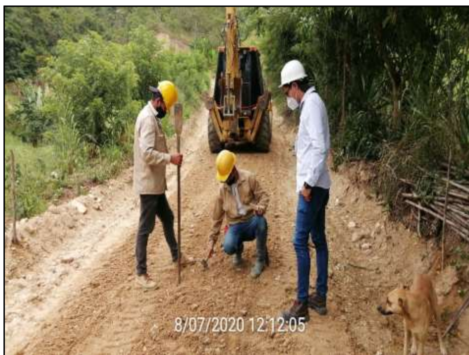
Figura 9. Uso de elementos de protección personal en obra.
