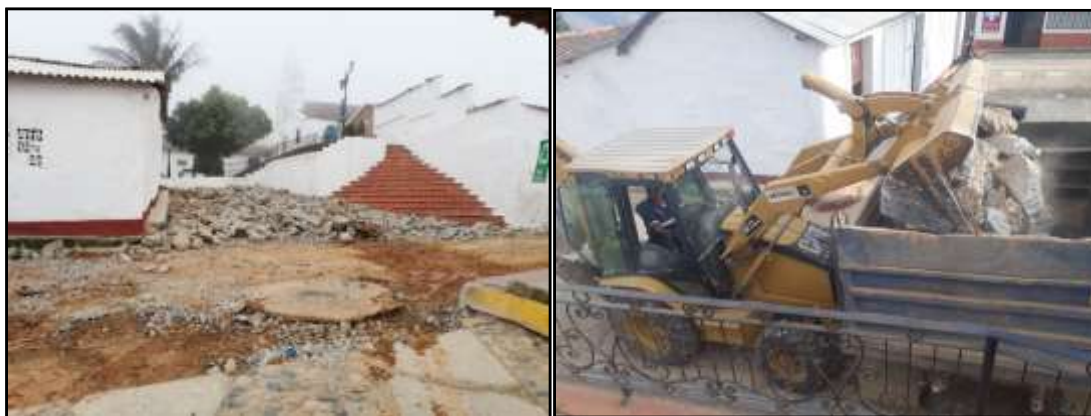
Figura 39. Retiro de escombros. Proyecto de estudio No.5 Fuente: Autores del proyecto.
