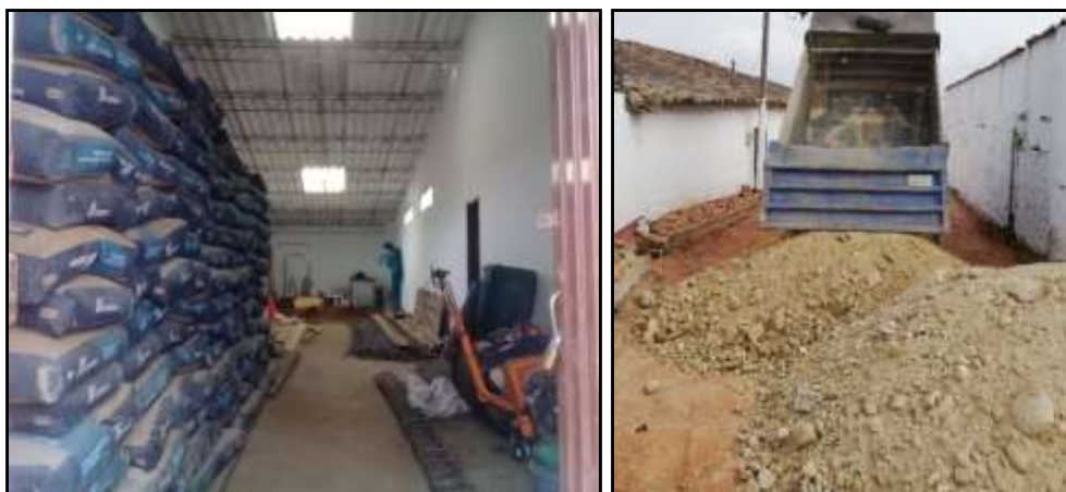
Figura 38. Almacenamiento y acopio de materiales. Proyecto de estudio No.5 Fuente: Autores del proyecto.
