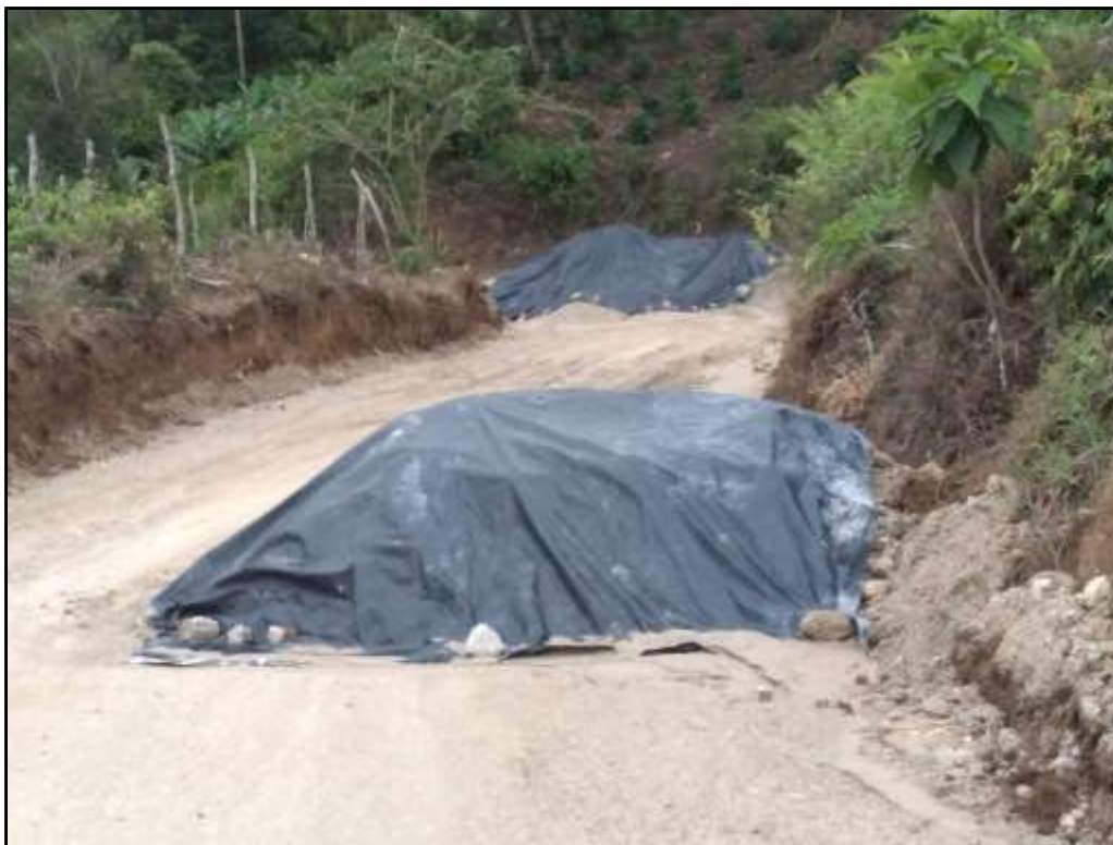
Figura 18. Acopio de materiales en obra.
