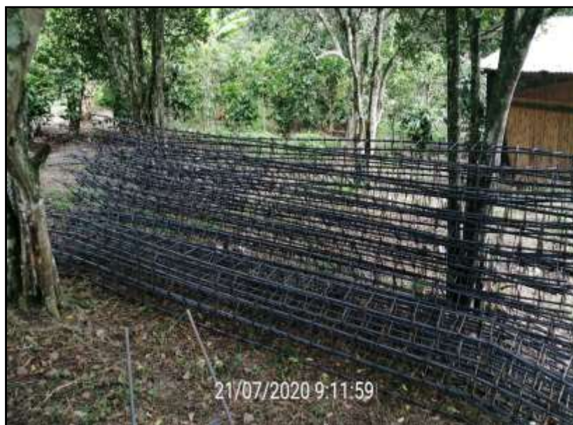
Figura 14. Acopio de acero de refuerzo en obra. Fuente: Autores del proyecto.
