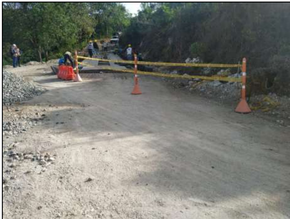
Figura 15. Señalización instalada en obra. Fuente: Autores del proyecto.
