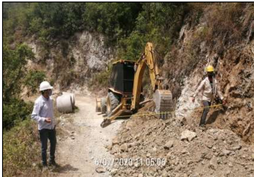
Figura 13. Retiro de material resultante de obra. Fuente: Autores del proyecto.
