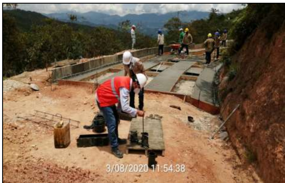
Figura 8. Toma de muestras de concreto.
