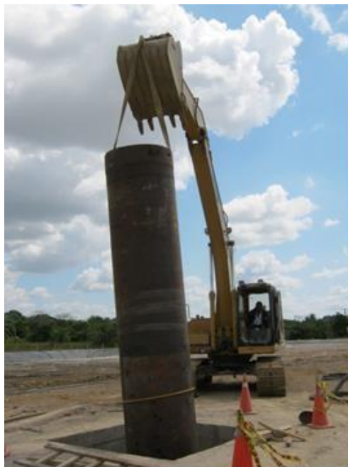
Figura 7. Instalación tubo conductor. Fuente: Autor.
