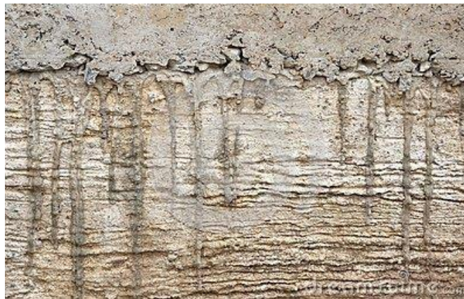
Figura 4. Exudación. Catcoparco M, (2012).
