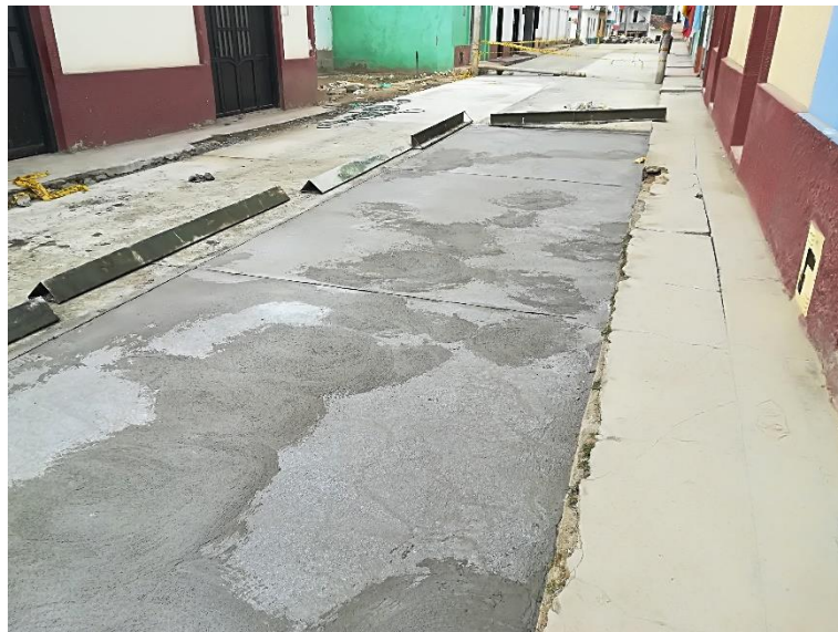
Figura 62. Fundida de carpeta de rodadura de un pavimento asfáltico. Autores del proyecto.
