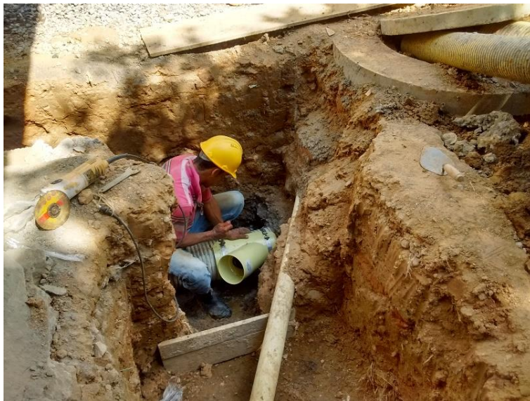
Figura 41. Instalación de silla yee para derivación domiciliaria hasta caja de inspección. Autores del proyecto.
