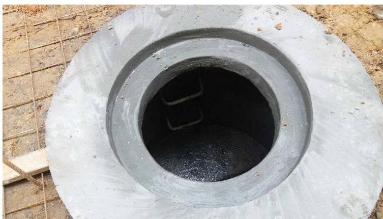
Figura 46. Corona de un pozo de inspección recién fundida en concreto reforzado. Autores del proyecto.
