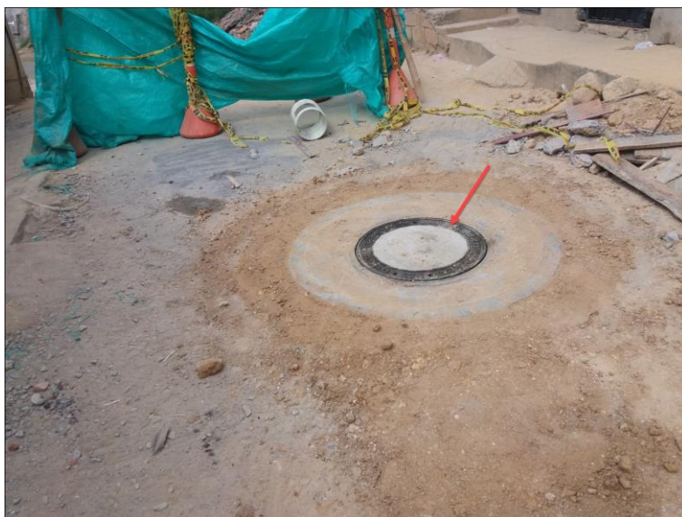
Figura 47. Tapa combinada en concreto reforzado y hierro fundido de un pozo de inspección en vías vehiculares. Autores del proyecto.
