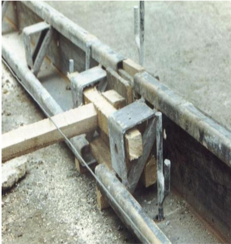
Figura 63. Alineadores de formaleta para pavimento rígido.360enconcreto. [Figura]. Recuperado de: https://www.360enconcreto.com/Portals/%5BComunidad360%5D/WEB-construccion-de-pavimentos-de-concreto.pdf
