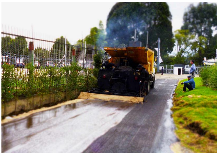
Figura 18. Riego de emulsión asfáltica en pavimento. IncoAsfaltos. Obtenido de: www.incoasfaltos.com
