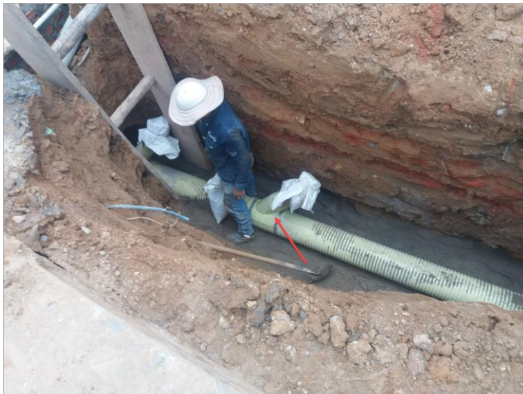
Figura 58. Uso de silla yee para conexión domiciliar. Autores del proyecto.
