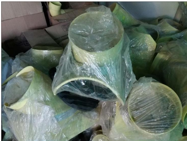
Figura 42. Almacenamiento de accesorio tipo silla yee en bodega de obra. Autores del proyecto.
