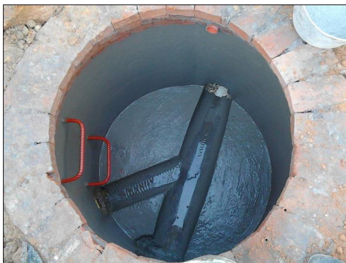
Figura 51. Construcción de cañuela con molde en tubería de PVC. Autores del proyecto.
