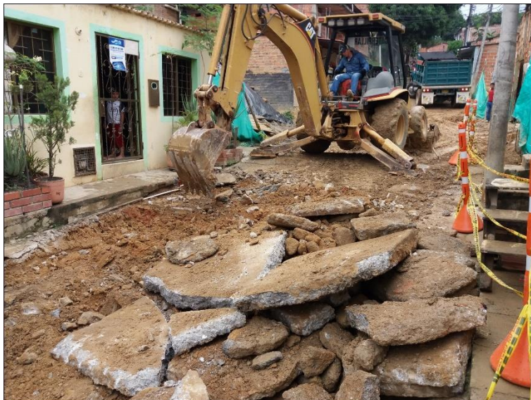
Figura 29. Demolición de pavimento rígido con retroexcavadora mixta(pajarita). Autores del proyecto.
