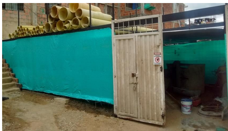
Figura 24. Almacén de obra en estructura metálica. Autores del proyecto.
