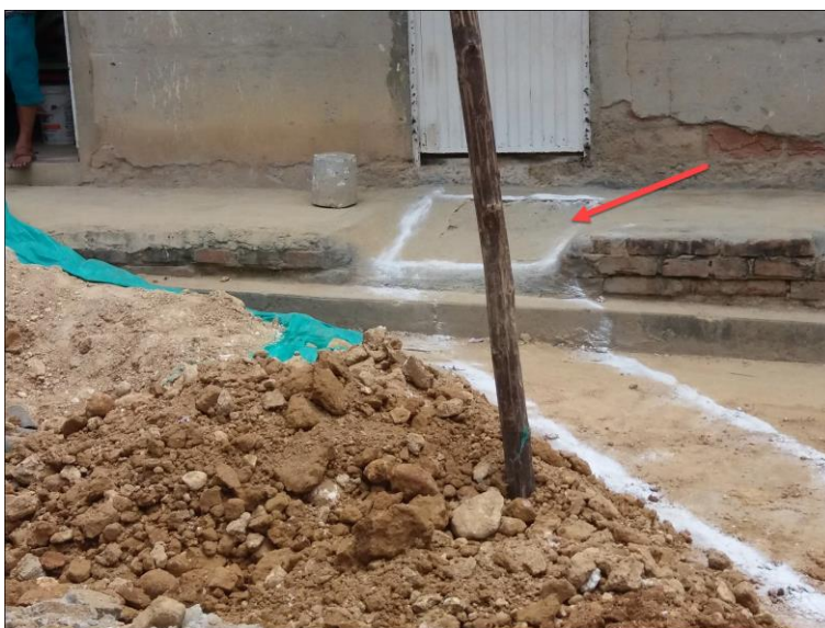
Figura 60. Delimitación para excavación de la sección para la caja de inspección. Autores del proyecto.
