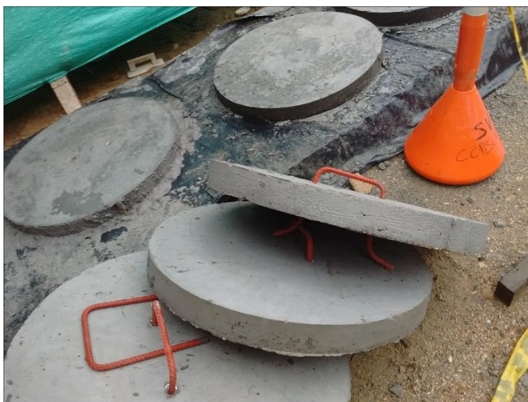
Figura 48. Tapa en concreto reforzado para pozo de inspección, usada para vías de tránsito peatonal. Autores del proyecto.
