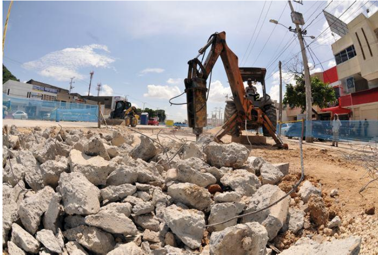
Figura 28. Demolición de estructura pavimento con martillo neumático. (El Universal, 2013)
