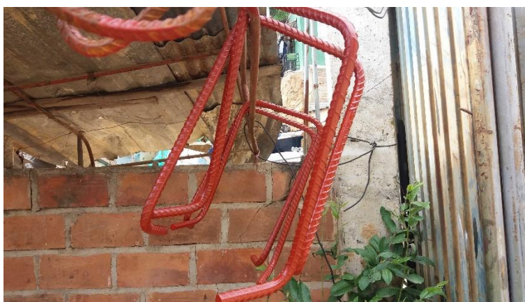
Figura 55. Aplicación de pintura anticorrosiva para pasos o escalones de pozos de inspección previo a su instalación. Autores del proyecto.
