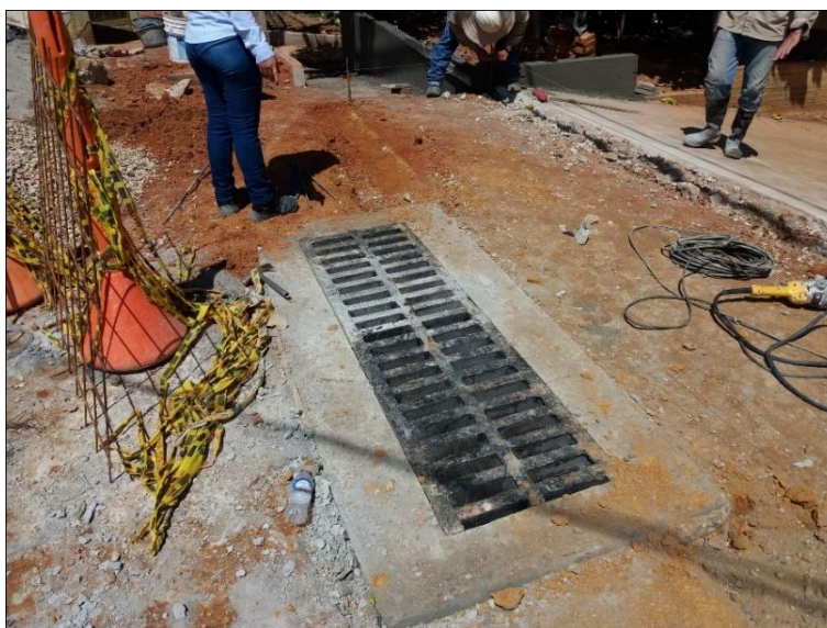
Figura 20. Rejilla en hierro fundido gris para sumidero lateral en vía. Autores del proyecto.
