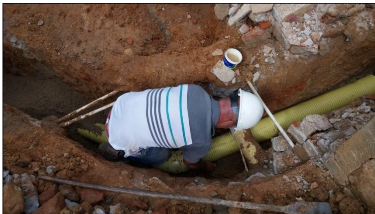
Figura 59. Derivación con tubería de 6” corrugada desde red de alcantarillado hasta caja de inspección con uso de semicodo. Autores del proyecto.
