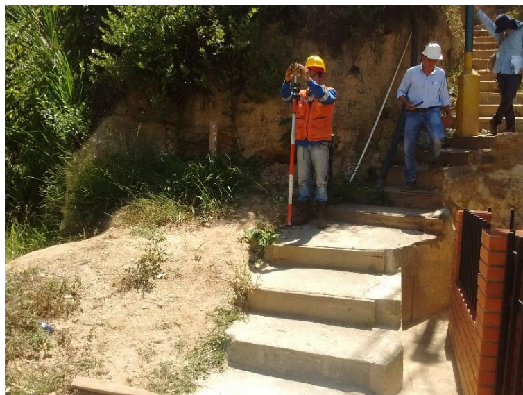
Figura 25. Localización de ejes de pozos de inspección con estación total. Autores del proyecto.
