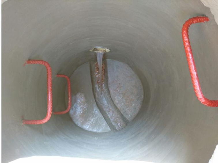
Figura 44. Vista interior de un pozo de inspección recién construido, esmaltado y escalones metálicos con aplicación de anticorrosivo. Autores del proyecto.
