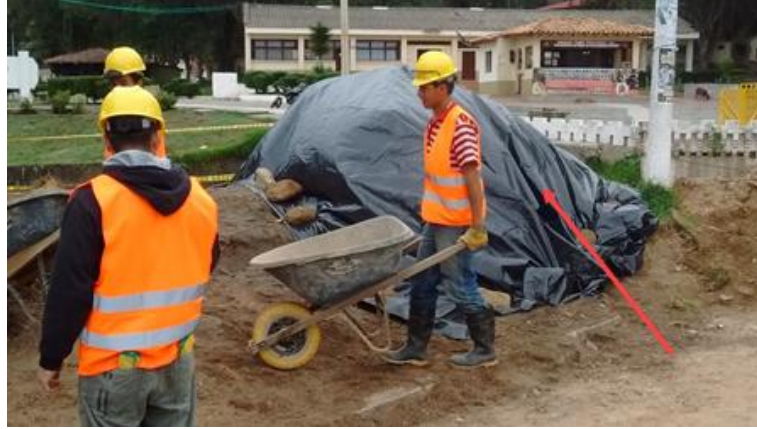
Figura 8. Cubrimiento de agregado grueso con plástico negro. Autores del proyecto.
