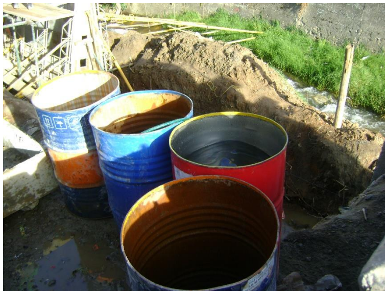
Figura 3. Depósito de agua en obra para mezclado de concreto. Autores del proyecto.
