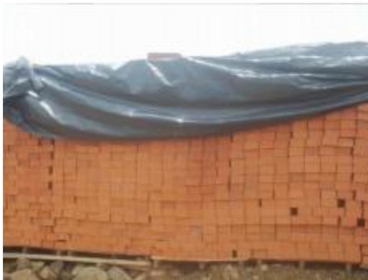
Figura 13. Recubrimiento del ladrillo con plástico. (Ladrillera Melendez, 2018)
