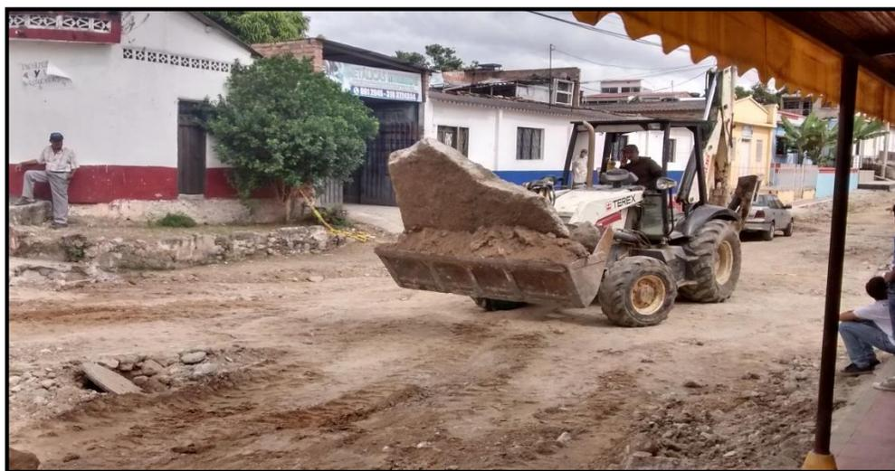
*Fotografía 9.* Retiro de material proveniente de la demolición de un pavimento rígido en el sector norte del municipio de Ocaña. Fuente: Autores (2019)
