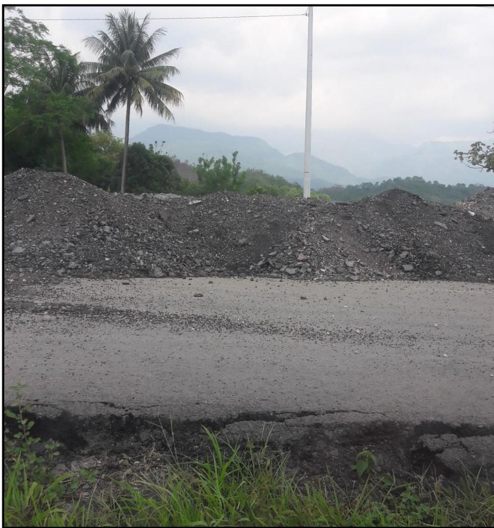
*Fotografía 6.* Zona de disposición de material de pavimento flexible fresado en la vía Aguaclara – Ocaña, para su posterior reúso. Fuente: Autores (2019)
