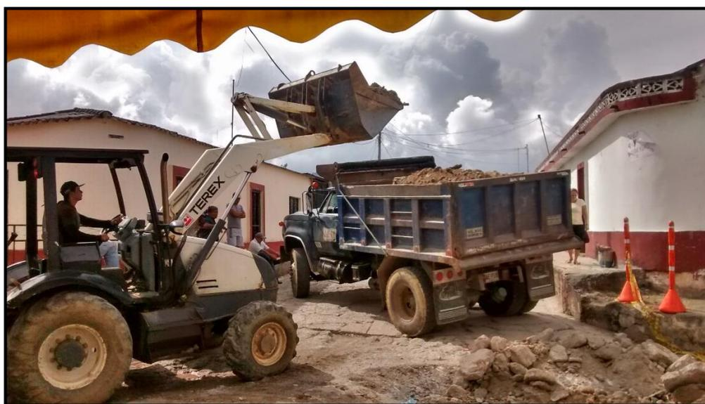
*Fotografía 10.* Transporte de residuos provenientes de la demolición de un pavimento rígido en el sector norte del municipio de Ocaña. Fuente: Autores (2019)
