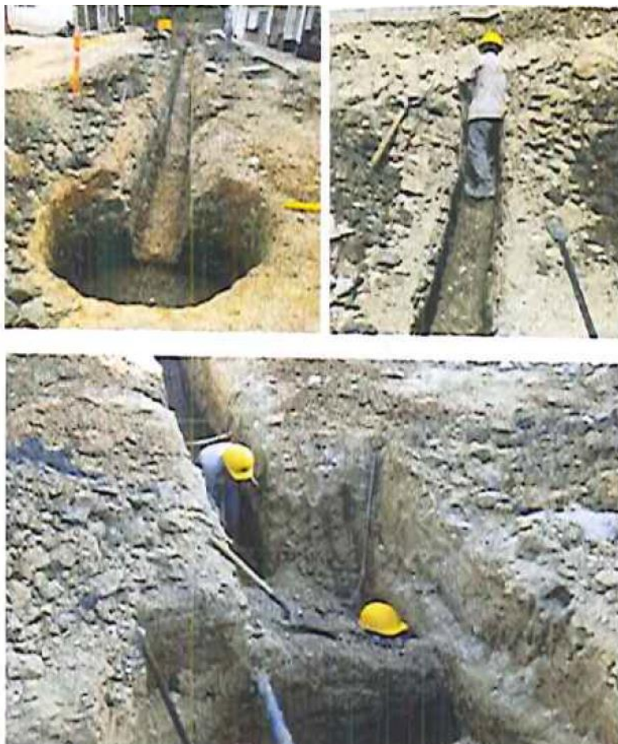
Figura 14. Actividad Excavación varia sin clasificar. Fuente: Autor de la pasantia, 2020.
