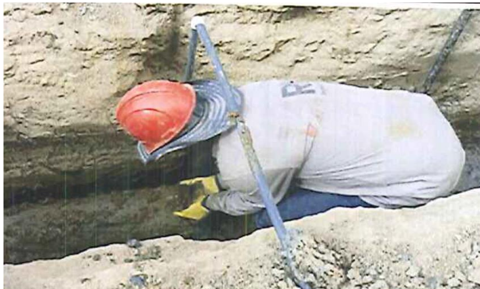
Figura 16. Actividad Retiro de tubería de gres existente. Fuente: Autor de la pasantía, 2020.
