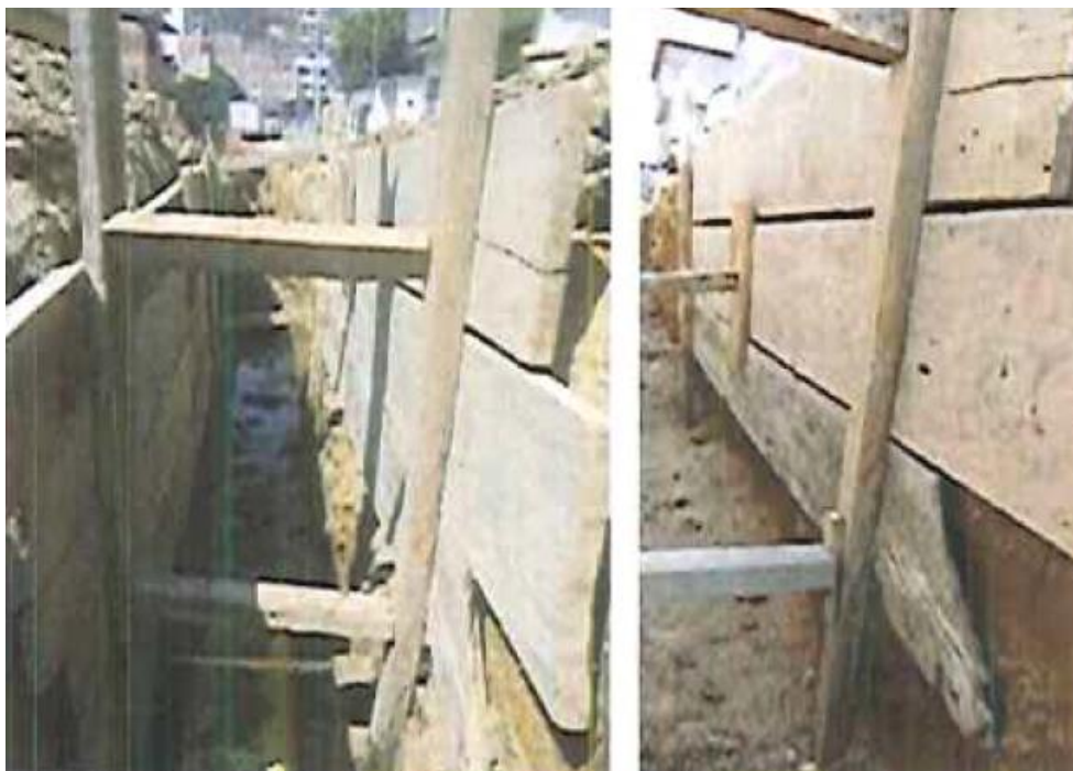
Figura 15. Actividad Entibado tipo 2 H=0-3. Fuente: Autor de la pasantía, 2020.
