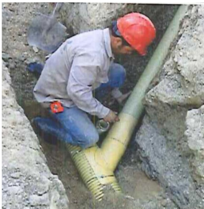
Figura 19. Actividad Instalación Silla Yee 8"- 6". Fuente: Autor de la pasantía, 2020.
