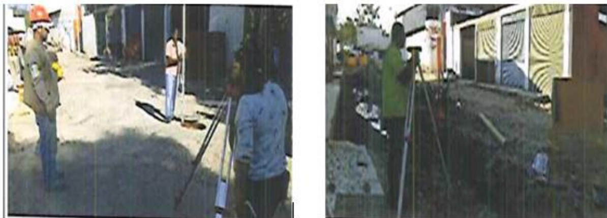
Figura 12. Actividad preliminar localización y replanteo. Fuente: Autor de la pasantía, 2020.
