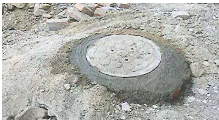
Figura 23. Actividad realce de pozos de inspección Fuente: Autor de la pasantía, 2020.
