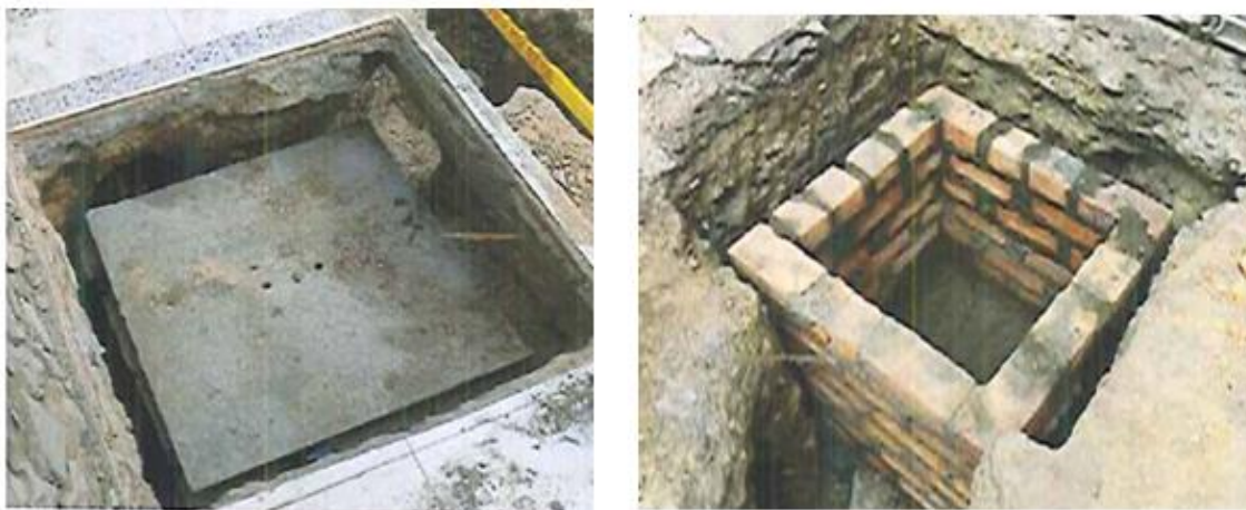
Figura 21. Actividad construcción de registro domiciliario Fuente: Autor de la pasantía, 2020.
