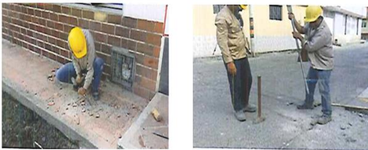
Figura 13. Actividad Demolición de concreto para andenes y pavimento rígido. Fuente: Autor de la pasantía, 2020.
