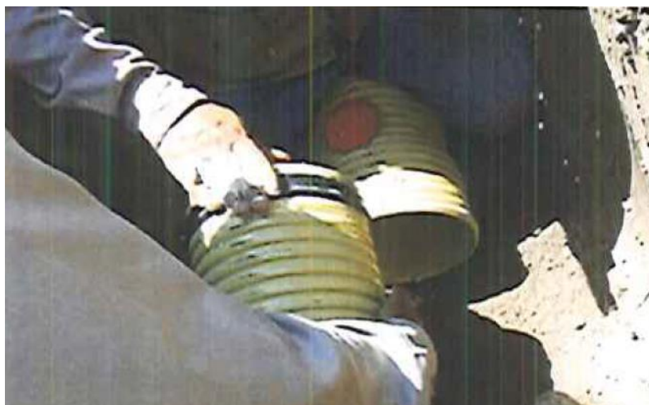
Figura 18. Actividad Instalación de tubería NOVAFOR. Fuente: Autor de la pasantía, 2020.
