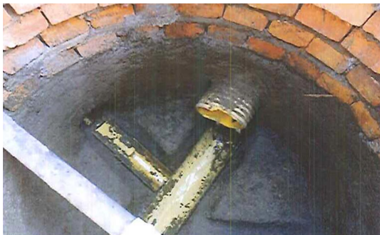
Figura 20. Actividad Conexión pozos existente. Fuente: Autor de la pasantía, 2020.
