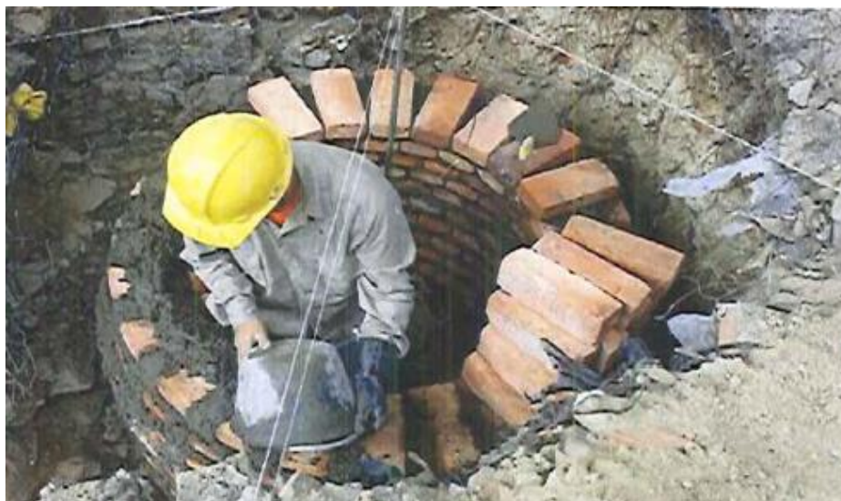
Figura 24. Actividad construcción de pozos de inspección Fuente: Autor de la pasantía, 2020.
