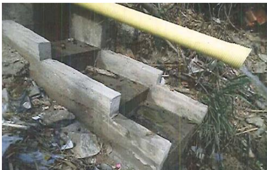
Figura 25. Actividad construcción cabezal por tubería de descarga Fuente: Autor de la pasantía, 2020.
