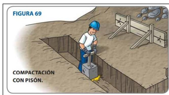
Figura 4. Compactación con pisón. Construye seguro. Manual del maestro constructor (2010). Obtenido https://www.acerosarequipa.com/manuales/pdf/manual-del-maestro-constructor.pdf
