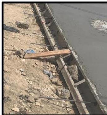
*Figura 28. Barras de anclaje colocada en las formaletas, con concreto fraguado lo suficiente para mantener las barras en su posición*
