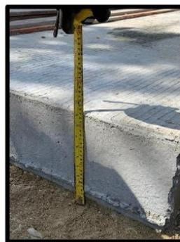
Figura 59. Chequeo del espesor de la placa
