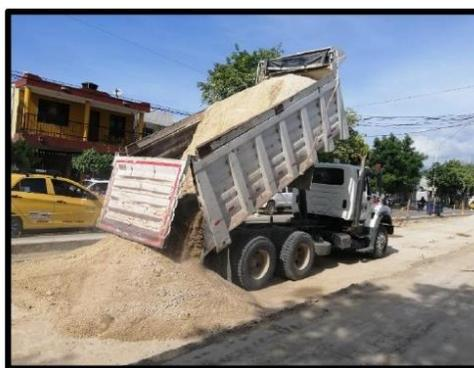
*Figura 14. Descargue de material seleccionado para sub base*
