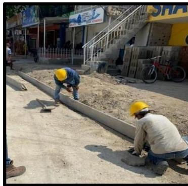
*Figura 23. Armado de formaletas a nivel marcado por el hilo*
