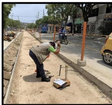
Figura 21. Toma de densidad de subbase con densímetro nuclear
