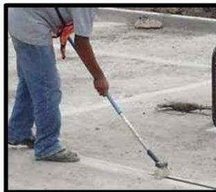
Figura 57. Colocación del cordón para las juntas
