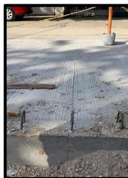
Figura 60. Fisura en placa de concreto
