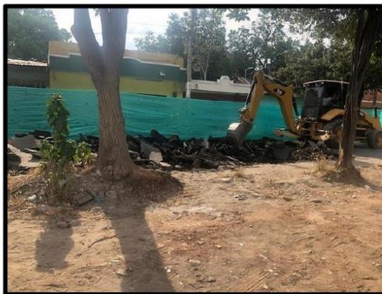
Figura 2. Retroexcavadora demoliendo pavimento flexible con la pala
