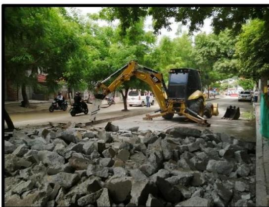
Figura 3. Retroexcavadora demoliendo pavimento rígido con taladro
