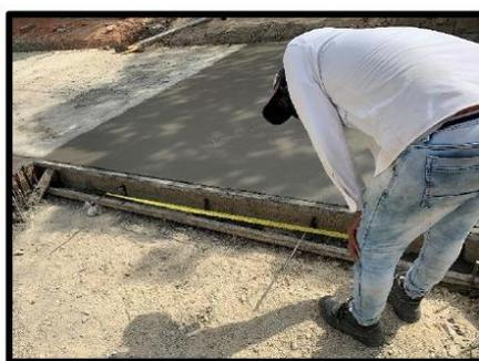
*Figura 29. Revisión del espaciamiento entre las barras de acuerdo a las especificaciones técnicas del pavimento*
