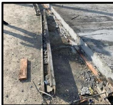
Figura 53. Desencofrado de placas
