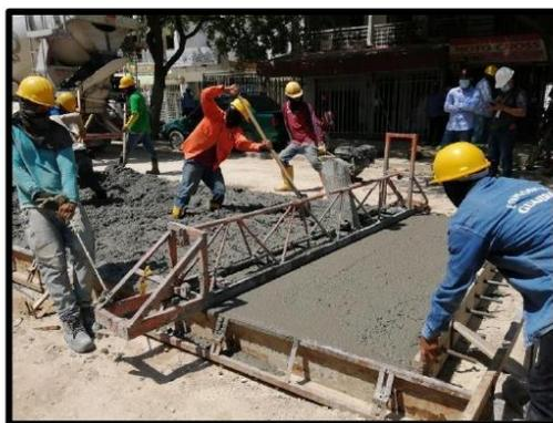
Figura 44. Vibrado con regla vibratoria
