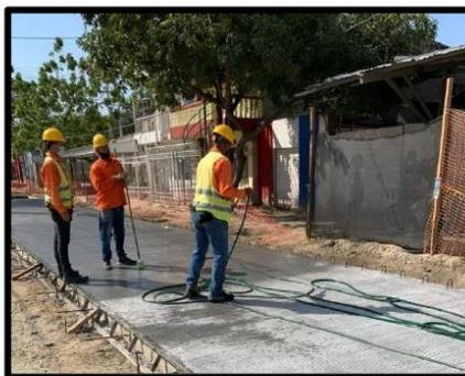
*Figura 55. Humectación de placas con manguera*
