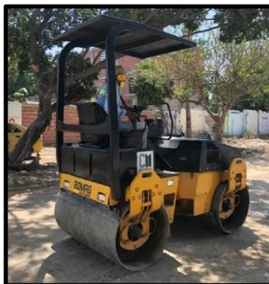
Figura 12. Compactación de la subrasante con vibro compactadora de dos rodillos
