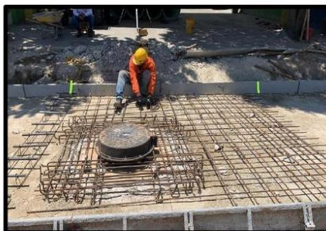
*Figura 35. Refuerzo para la placa con manhole en su interior*
