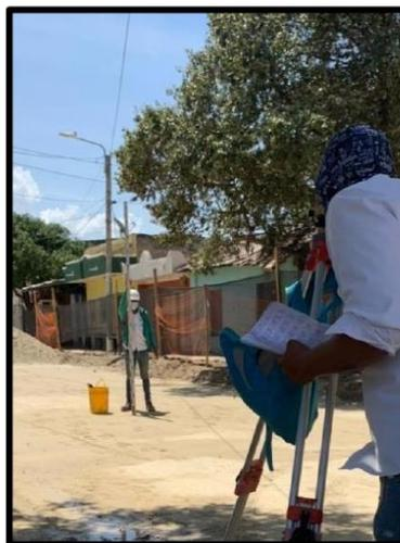
*Figura 16. Chequeo de cota de las estacas guías con la regla y el nivel topográfico*
