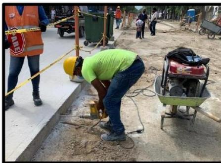
Figura 30. Perforación en pavimento existente para anclaje de barras de amarre
