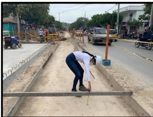
*Figura 24. Chequeo de espesor con regla sobre formaleta y pavimento existente*
