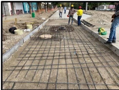
Figura 32. Refuerzo para losa con longitud 24 veces mayor al espesor
