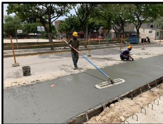
Figura 47. Acabado superficial con flotador
