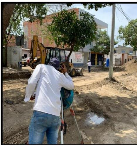
*Figura 10. Chequeo de cotas con nivel topográfico*
