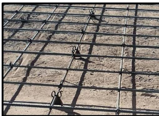
*Figura 37. Silletas para la altura del refuerzo de acero*
