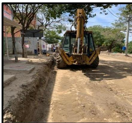
*Figura 9. Nivelación de la sub rasante con la retroexcavadora*
