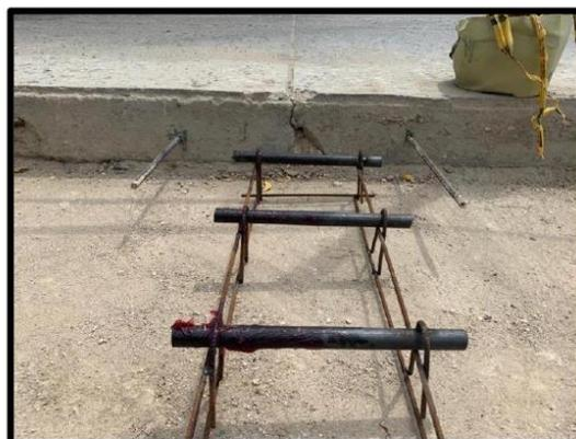
*Figura 26. Canastillas con dovelas engrasadas a la mitad en dirección del flujo vehicular, separadas 30cm de las barras de transferencia para libre movimiento dentro de la placa*
