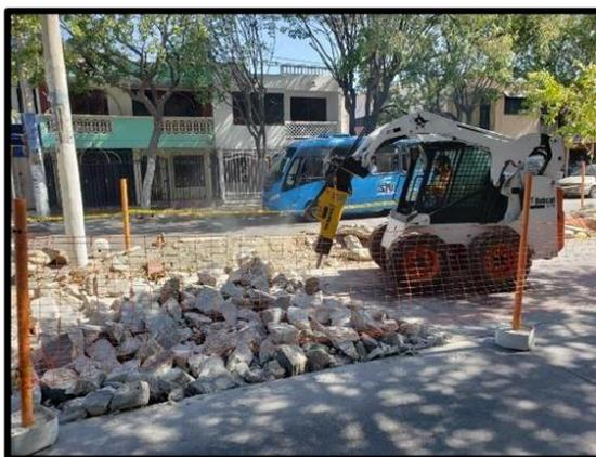
*Figura 5. Minicargador demoliendo pavimento rígido con taladró*
