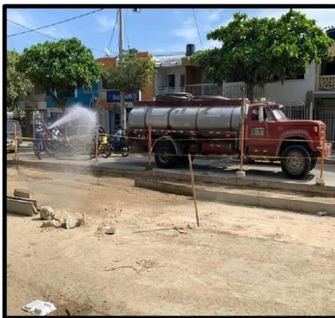
*Figura 11. Humectación con carrotanque*
