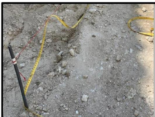
Figura 22. Varilla con hilo tensionado a nivel marcado en la cinta.
