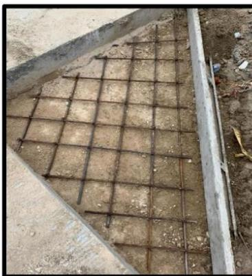
*Figura 36. Losa triangular para los cruces en las boca-calles.*
