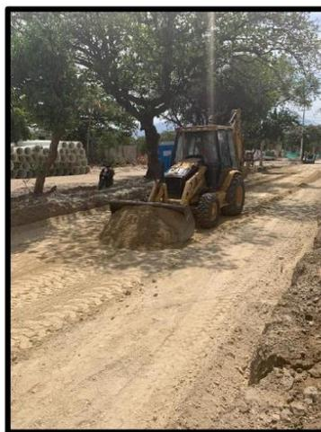
*Figura 17. Extensión de material con retocargadora*
