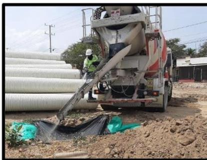
Figura 52. Lavado del mixer en sitio preparado para las aguas con residuo de concreto
