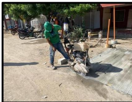
Figura 54. Corte de junta con cortadora de pavimento
