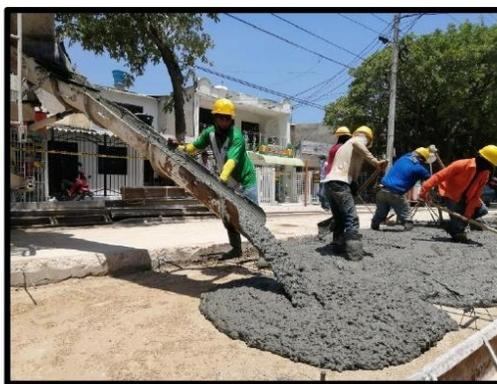
Figura 43. Vaciado del concreto
