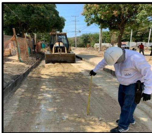
*Figura 25. Chequeo de espesor con hilo tensionado sobre formaletas y renivelación de sub base*
