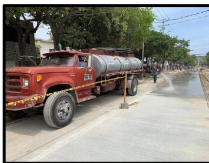
*Figura 56. Humectación de placas con carro tanque*
