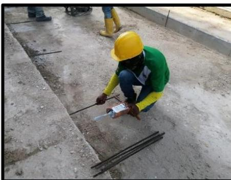
Figura 31. Anclaje de barras de amarre con epóxido Sika
