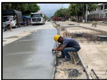
Figura 49. Colocación de varillas U para bordillo
