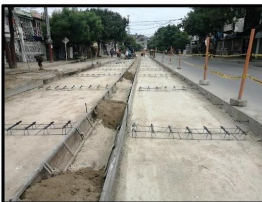
*Figura 27. Dovelas ubicadas en las juntas transversales de la calzada*
