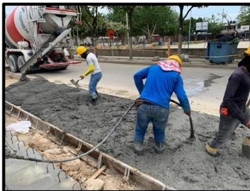
*Figura 45. Vibrado con vibrador de punta*
