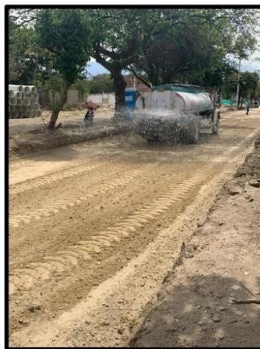
*Figura 19. Humectación del material extendido
