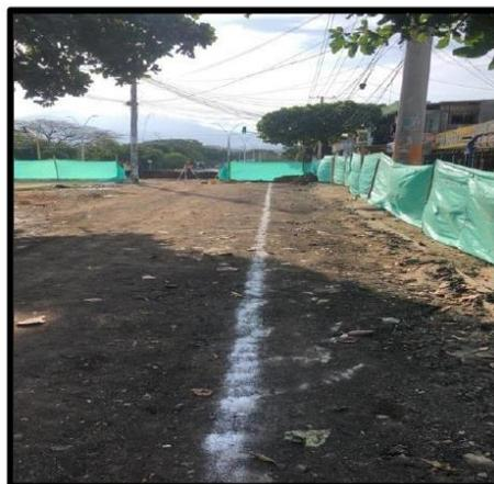
*Figura 8. Trazado de los ejes de la vía con cal.*
