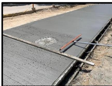
Figura 50. Rayado del concreto con peine metálico
