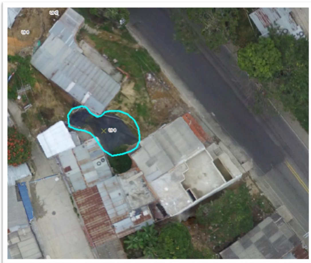
Figura 27 Localización de talud crítico, barrio La Colina. GIGMA, 2019.
