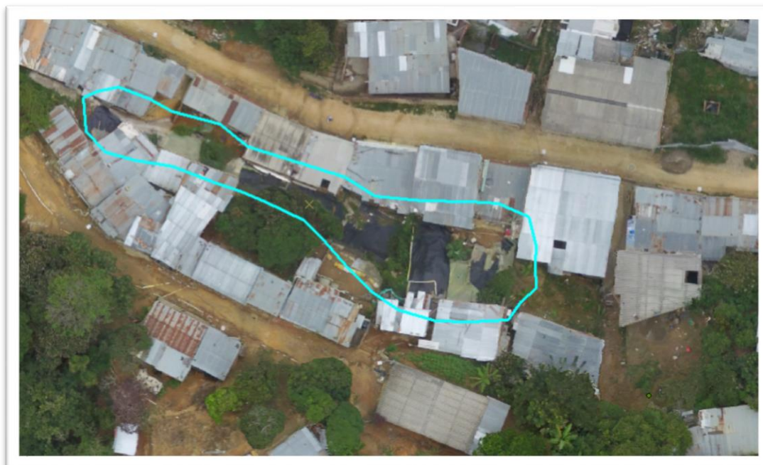
Figura 31 Localización de talud crítico, barrio San Fermín. GIGMA, 2019.
