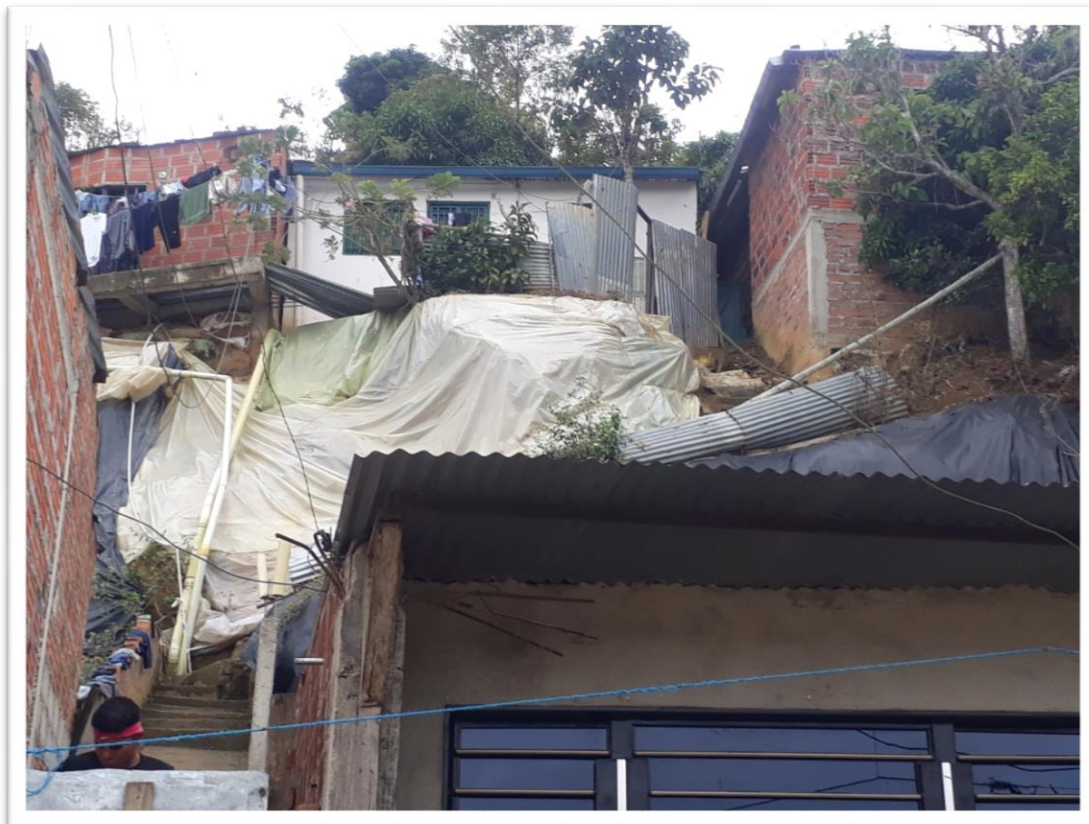
Figura 32 Fotografía talud crítico,barrio San Fermin. Autores del proyecto.2019
