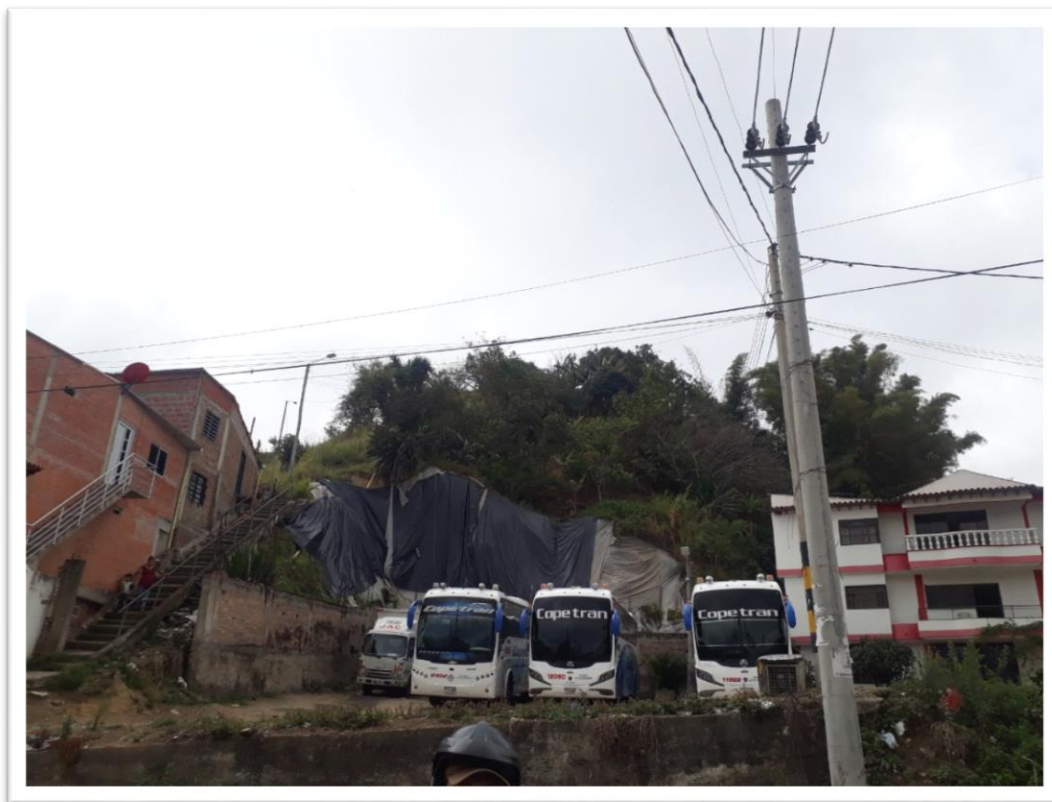
Figura 43. Fotografía talud propenso,barrio Las Mercedes. Autores del proyecto,2019
