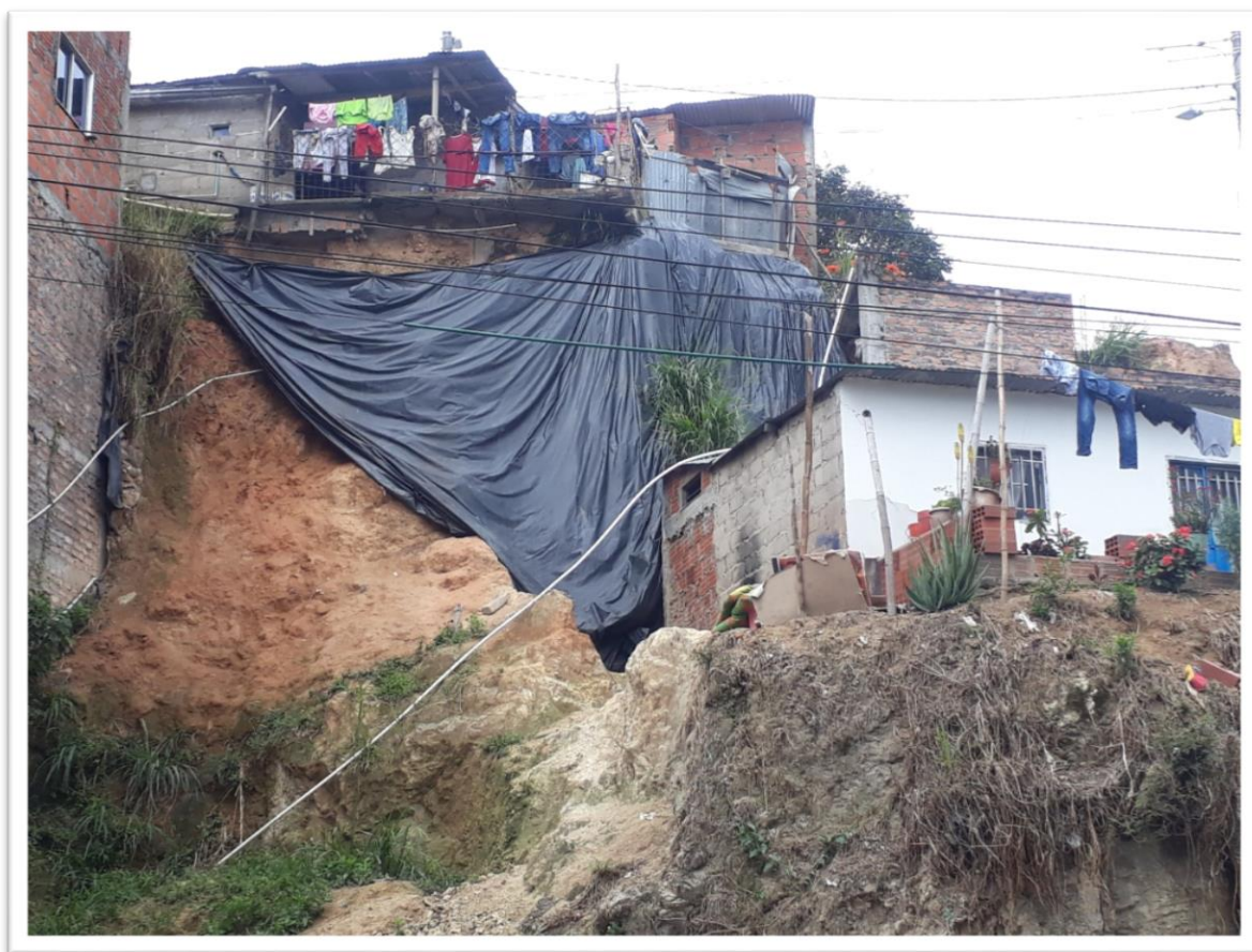
Figura 28 Fotografía talud crítico, barrio La Colina Autores del proyecto, 2019.
