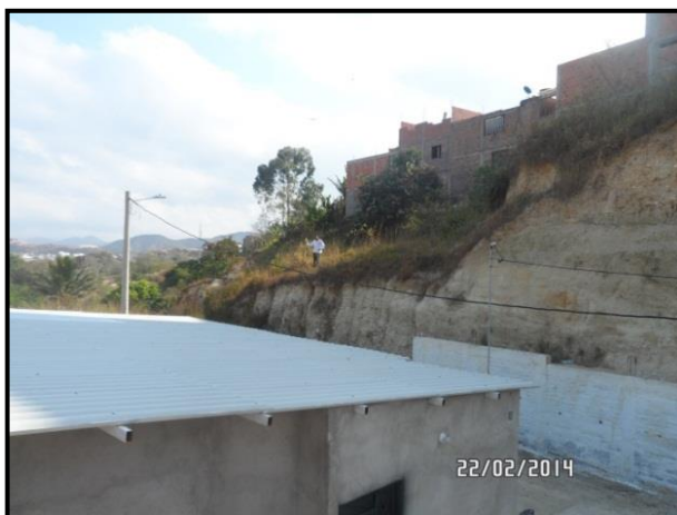
Fotografía 34. Toma de puntos en el constado aledaño al talud.
