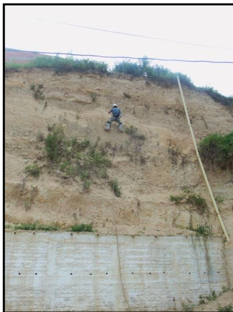
Fotografía 22. Descenso por la pared del talud.
