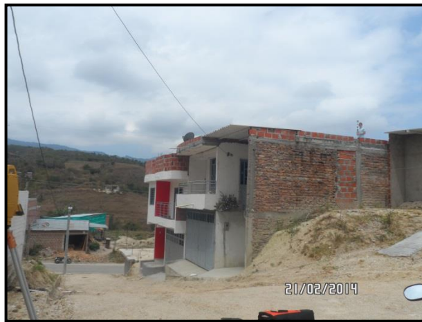
Fotografía 32. Cambio de estación.
