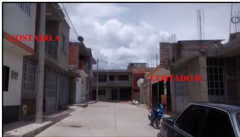
Fotografía 45. Viviendas sobre el talud
