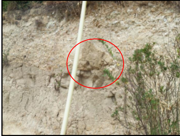
Fotografía 9. Fuga de agua de la tubería del sistema de drenaje existente.
