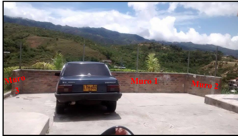
Fotografía 48. Muros de seguridad (segmentos).
