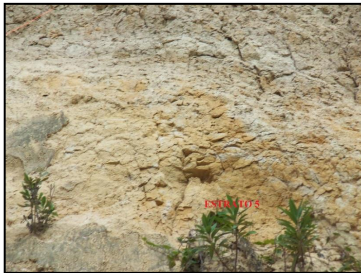
Fotografía 55. Estrato 5 de suelo que conforma el talud (arenisca).
