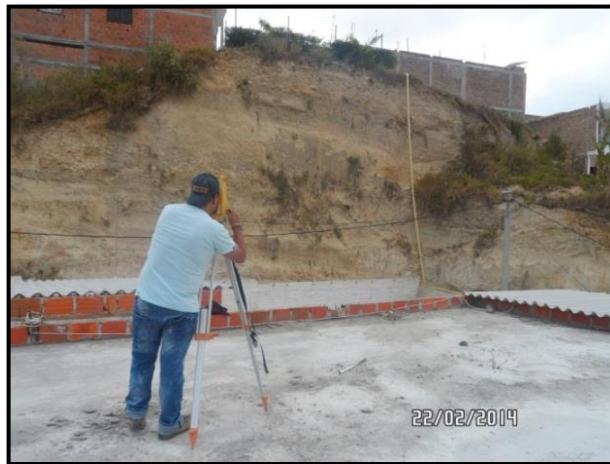
Fotografía 36. Toma de puntos sin reflector.
