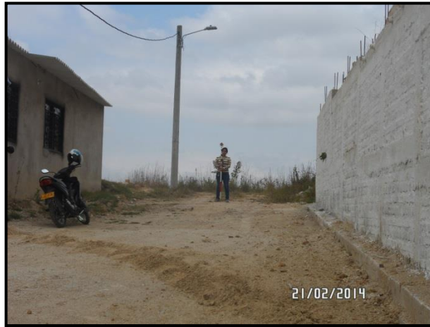
Fotografía 31. Toma de puntos con la estación en el eje de la vía.
