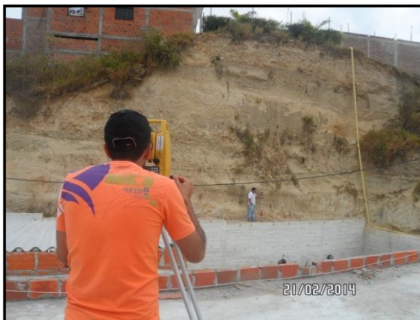
Fotografía 33. Toma de puntos con la estación y el prisma.
