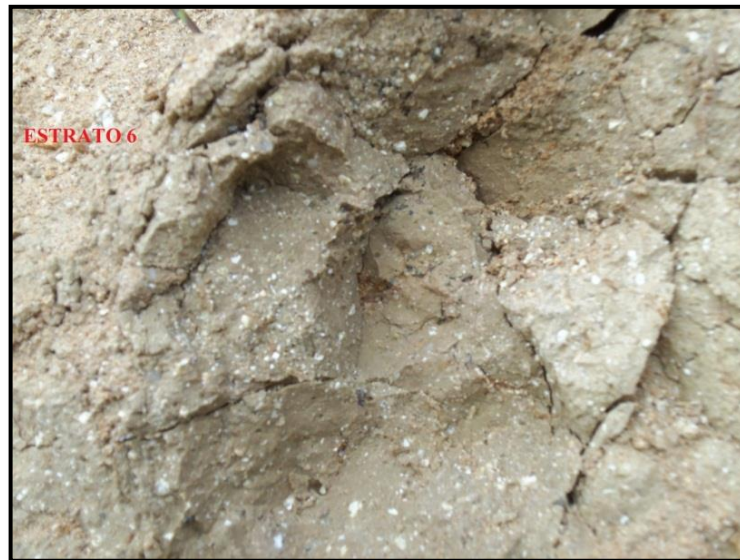
Fotografía 56. Estrato 6 de suelo que conforma el talud (arcillolita).
