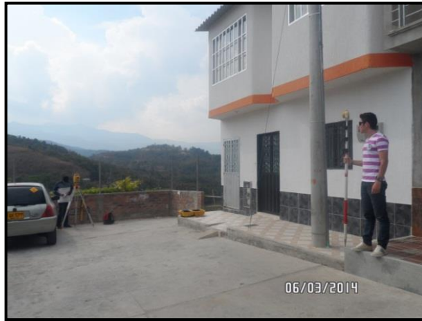
Fotografía 39. Marcación de puntos en el borde de la vía.
