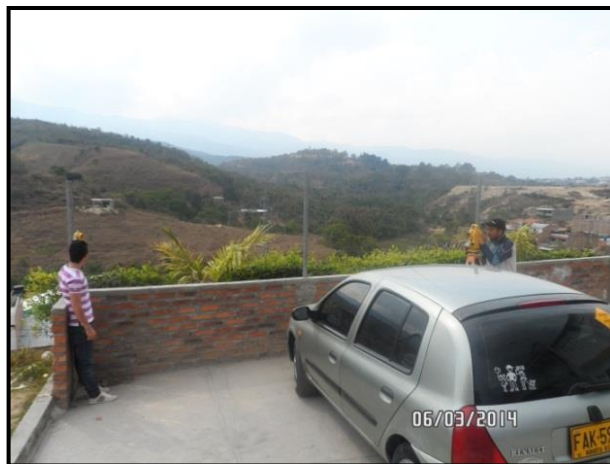
Fotografía 38. Toma de punto en el muro de seguridad de la corona del talud.
