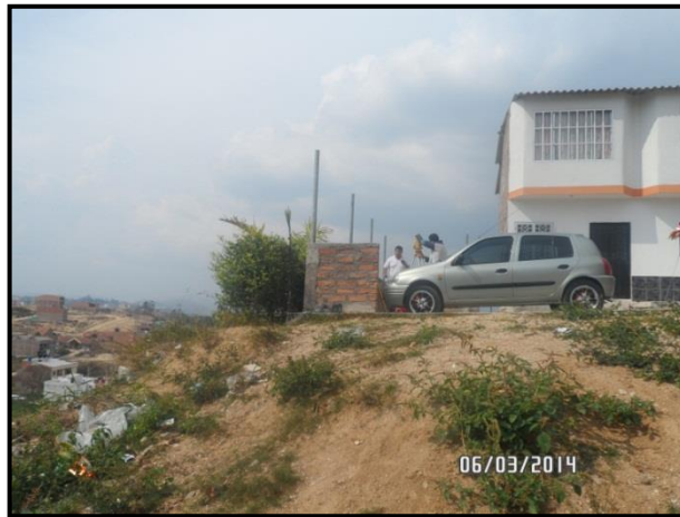
Fotografía 8. Lote cercano a la corona del talud y vehículo estacionado.
