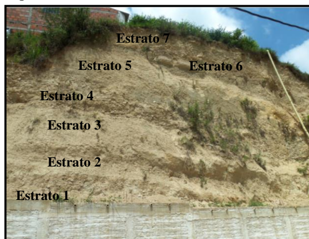
Fotografía 4. Estratos que conforman el talud.
