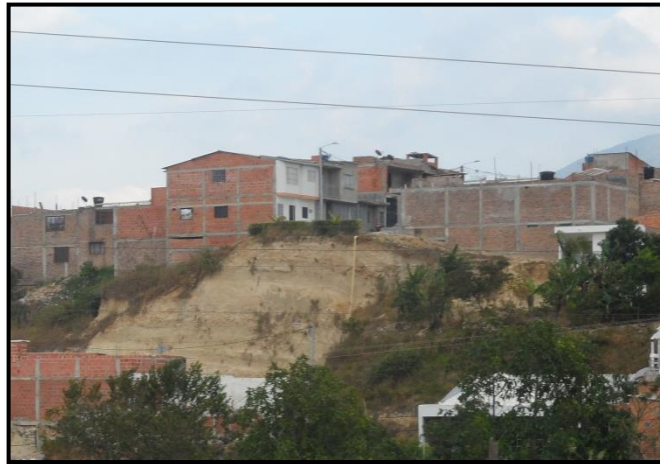
Fotografía 44. Vista del talud con las cargas a las que está sometido.
