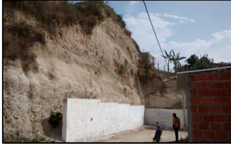
Fotografía 2. Muro de Contención.
