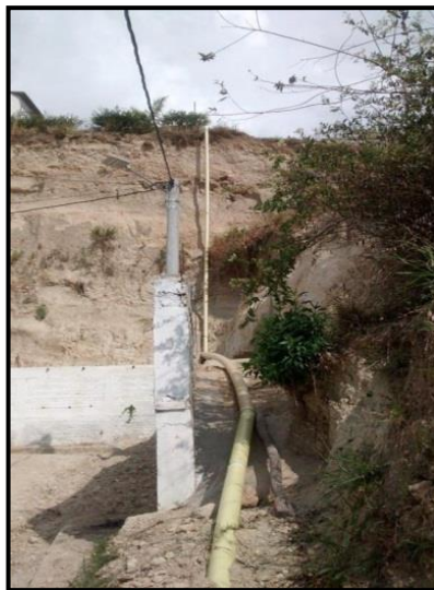
Fotografía 3. Sistema de drenaje del talud.
