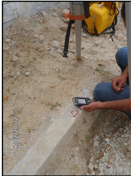
Fotografía 30. Toma de coordenadas punto base (GPS).
