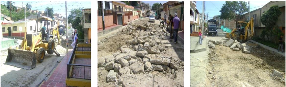
**Corte con equipo especial a las partes más críticas del barrio Marabel.** Esta actividad se realizó muy detalladamente debido a que en algunas áreas solo se requería demolición con maquinaria, por lo tanto solo se utilizó la cortadora en las áreas indicadas.
