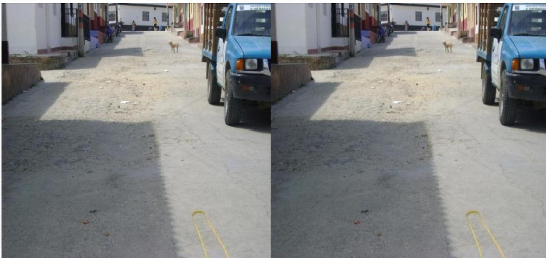
**Registro fotográfico.** Se observa la discontinuidad de la vía en el cual se debe ampliar la calzada para dar paso vehicular y construir un muro en concreto reforzado.
