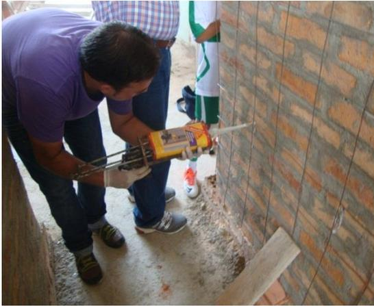
**Fotografía 45.** Anclajes instalados en muretes
