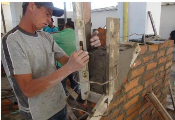
**Fotografía 49(b).** Elaboración de cuñas de nivelación de mortero en las esquinas
