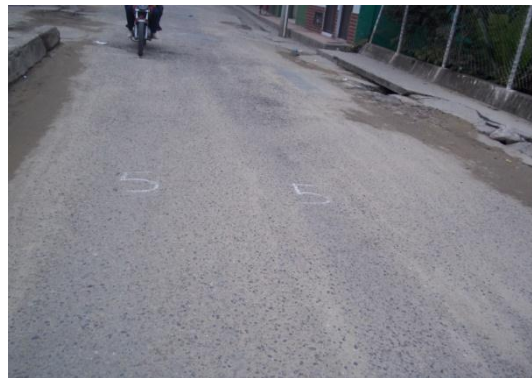
Fotografía 6. Desgaste superficial.
