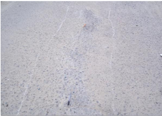
Fotografía 5. Fisura longitudinal
