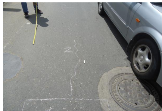
Fotografía 143. Fisura longitudinal.
