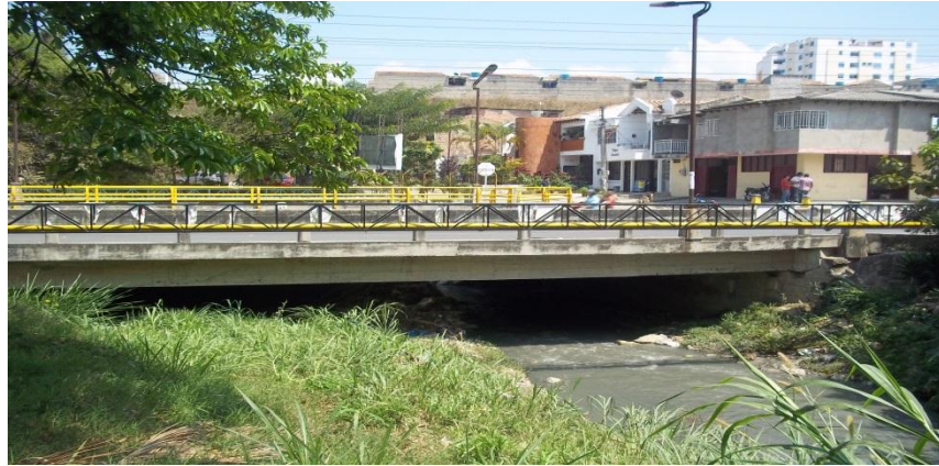
Fotografía 140. Panorámica aguas arriba
