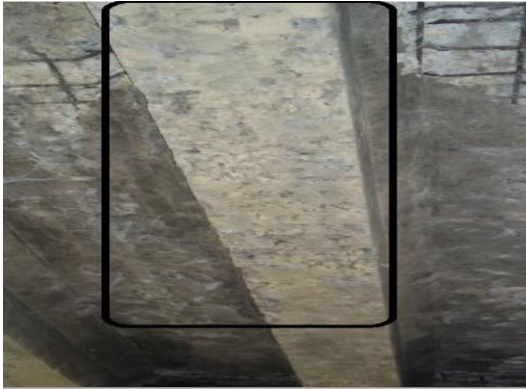
Fotografía 28. Viga 2, segregación.
