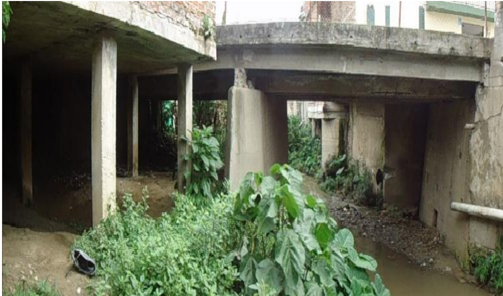
Fotografía 1. Panorámica aguas arriba
