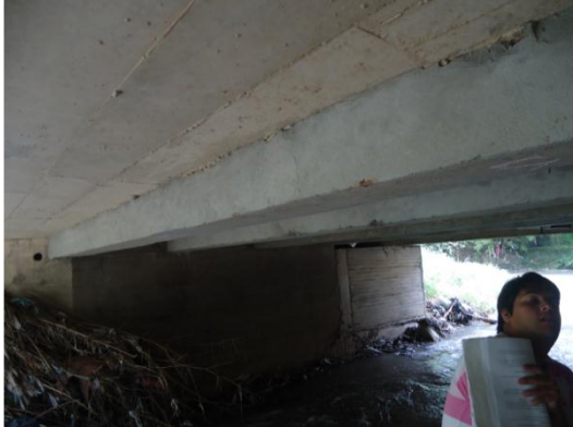
Fotografía 178. Viga 1, buen estado.
