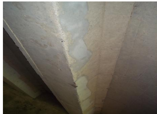
Fotografía 181. Viga 2, buen estado.
