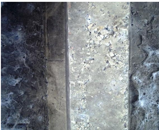
Fotografía 30. Viga 3, segregación.
