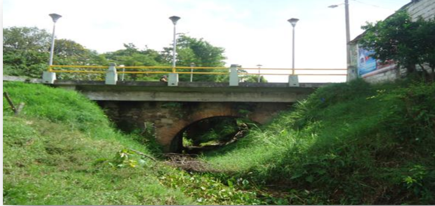
Fotografía 214. Panorámica aguas arriba
