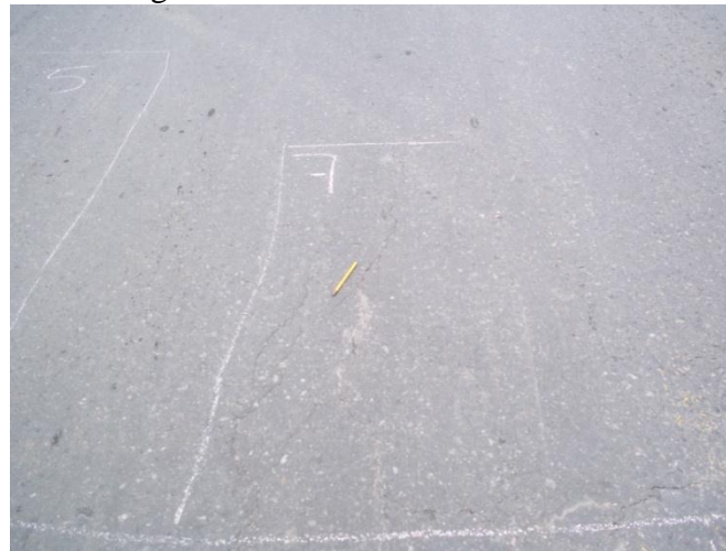
Fotografía 222. Fisura longitudinal.
