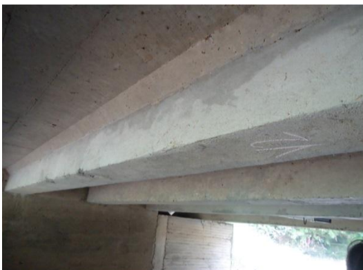
Fotografía 180. Viga 2, buen estado.
