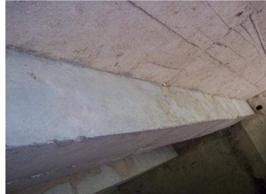
Fotografía 179. Viga 1, buen estado.
