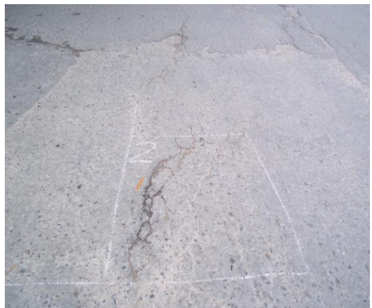
Fotografía 74. Fisura longitudinal.
