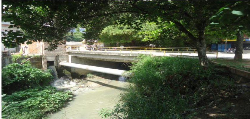
Fotografía 71. Panorámica aguas arriba
