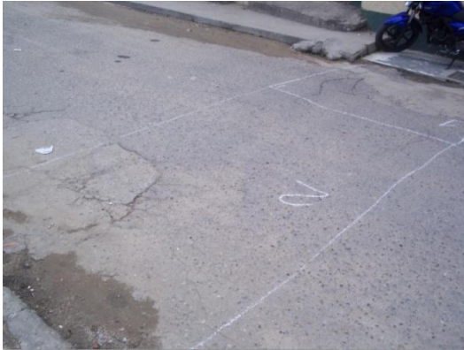
Fotografía 3. Hundimiento
