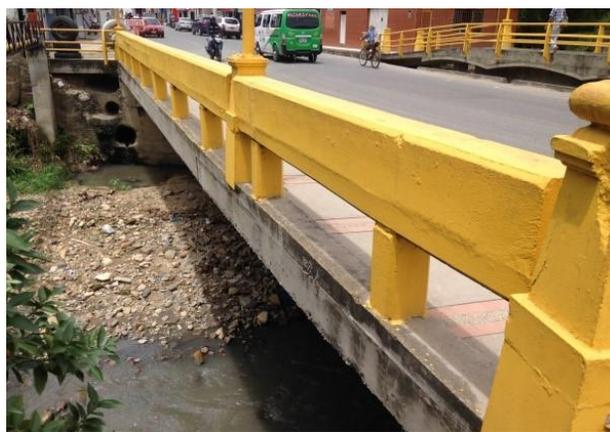
Figura 29. Estado de drenajes puente de La Gloria. Fuente: Autores 2016
