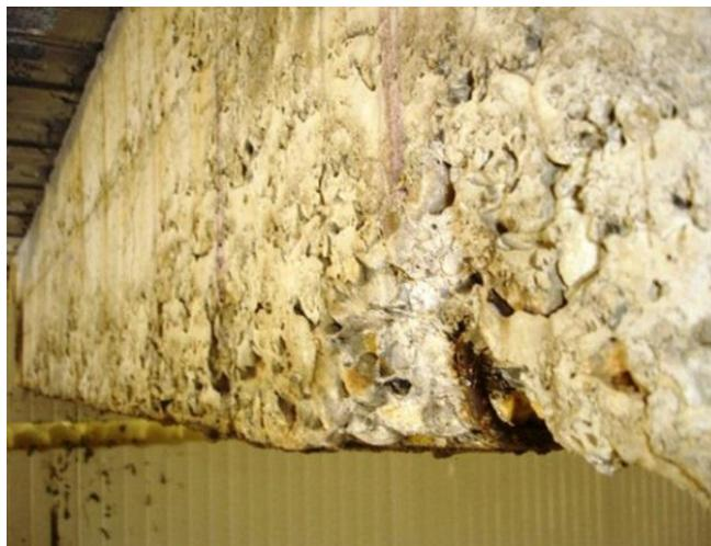
Figura 2. Difusión del dióxido de carbono a través de los poros de concreto, daños por corrosión. Fuente: Osorio (2012).
