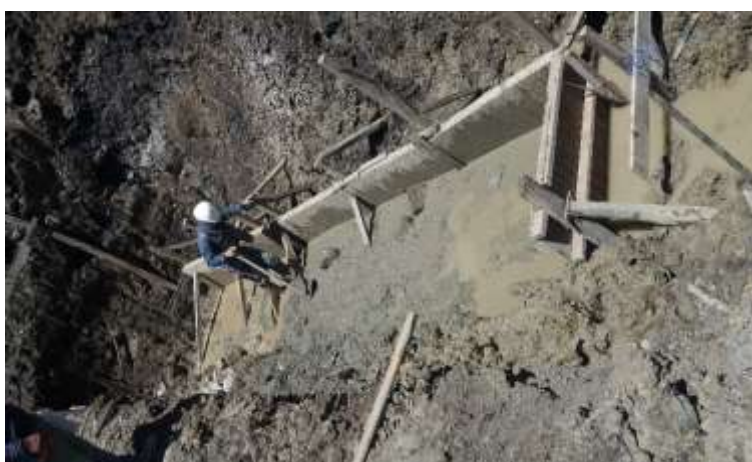
Figura 13. Mejoramiento condiciones del suelo mediante la aplicación de concreto ciclópeo para la implantación del muro.
