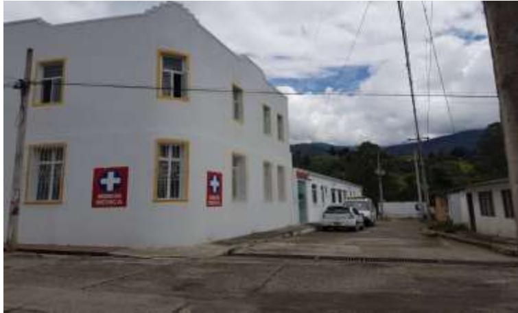
Figura 29. Fachada construcción de urgencias
