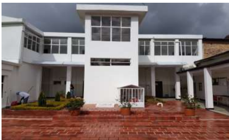
Figura 28. Construcción de oficinas
