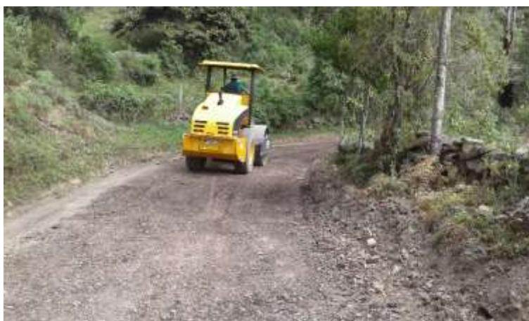
Figura 22. Compactación de afirmado (recebo)
