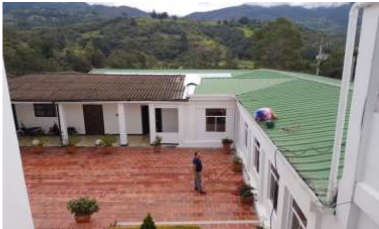
Figura 30. Panorámica construcción urgencias
