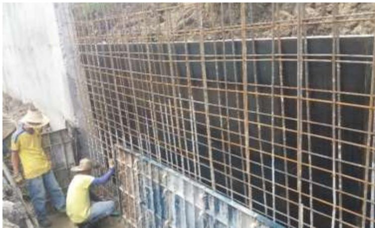
Figura 16. Proceso de instalación formaleta exterior muro
