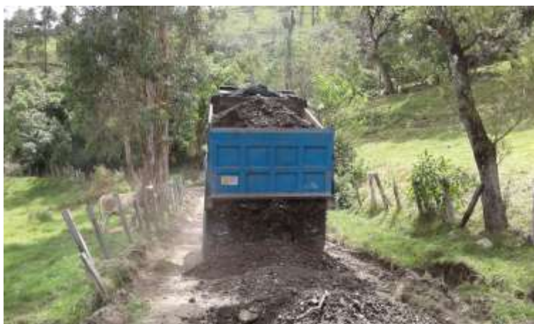
Figura 20. Suministro de afirmado (recebo)
