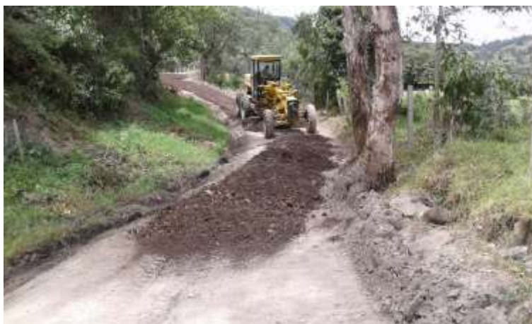
Figura 21. Instalación de afirmado (recebo)
