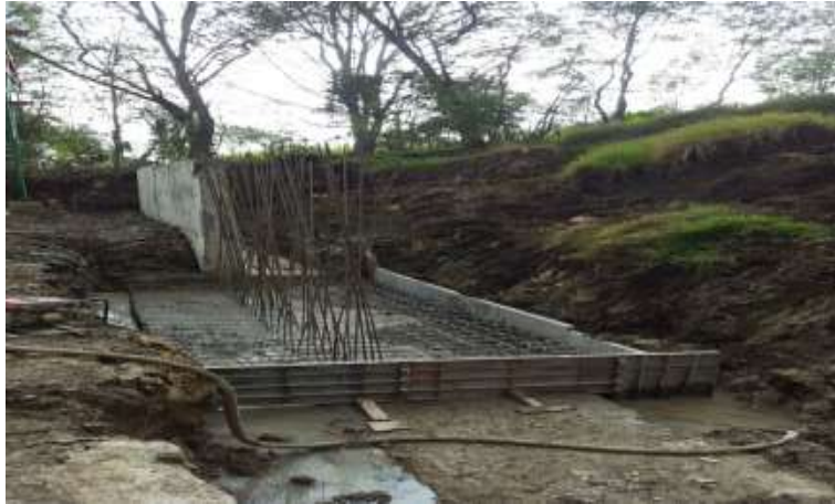
Figura 15. Instalación de refuerzo del muro
