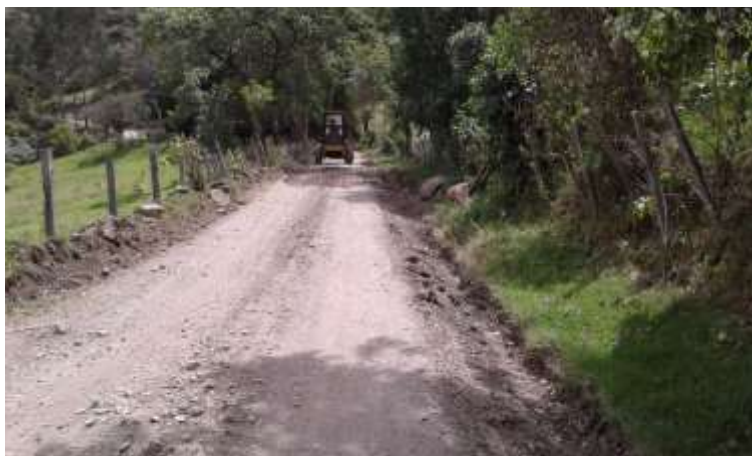
Figura 19. Raspado y Cuneteado de la calzada existente
