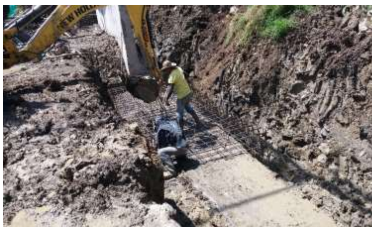
Figura 14. Proceso figurado y armado de refuerzo zapata del muro
