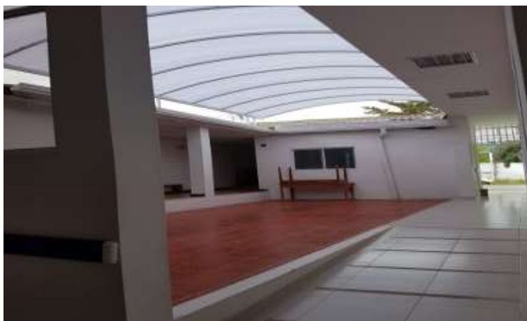
Figura 31. Rampa de acceso a urgencias.
