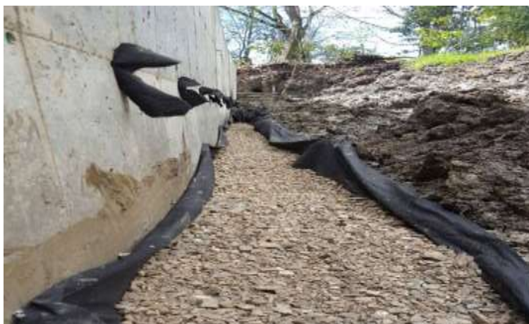
Figura 18. Construcción filtro posterior muro occidental
