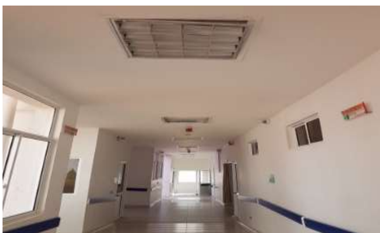
Figura 27. Construcción de urgencias.
