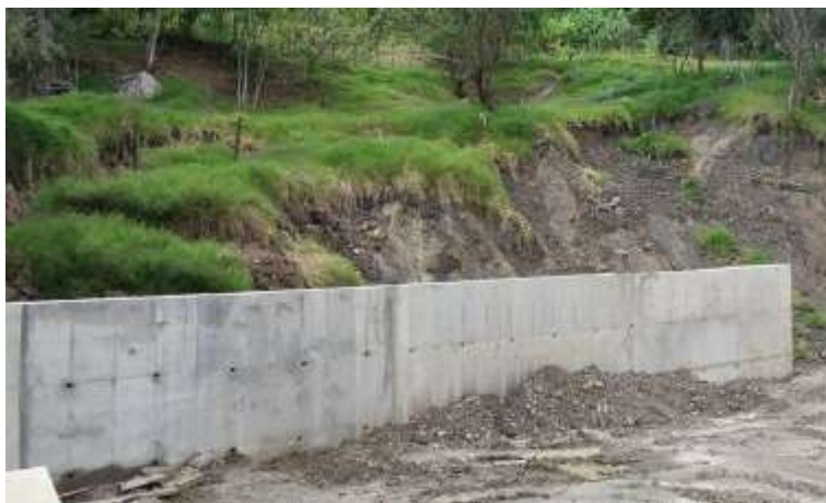
Figura 17. Muro de contención occidental
