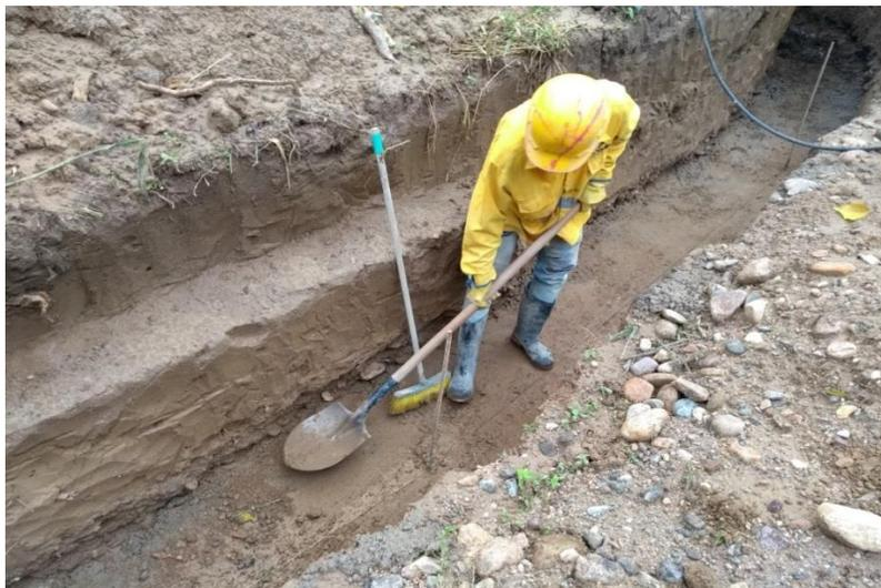
**Fotografía 8.** Limpieza de zona de aplicación de concreto.
