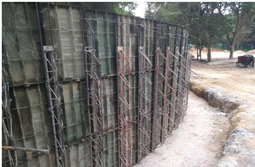
**Fotografía 15.** Encofrado muro redoma izquierda.
