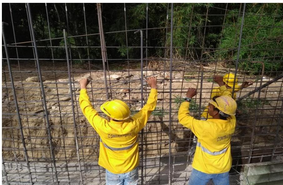
**Fotografía 22.** Colocación del refuerzo.
