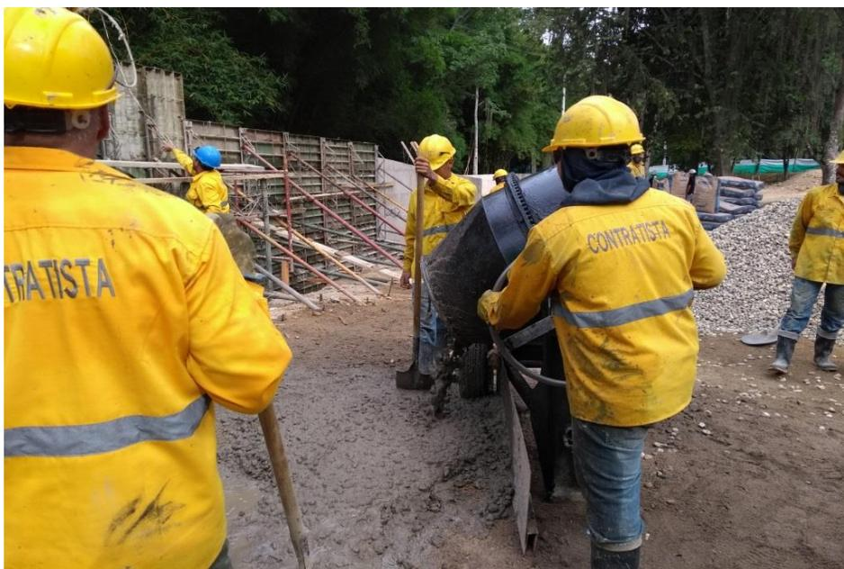
**Fotografía 11.** Vaciado de mezcladora.
