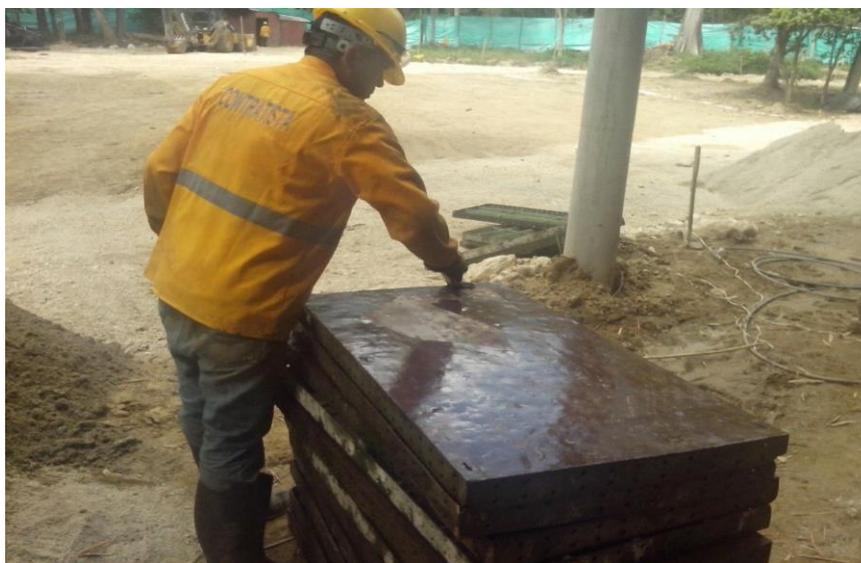
**Fotografía 9.** Aplicación de desmoldante al encofrado.
