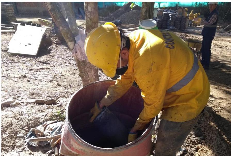
**Fotografía 30.** Elaboración de especímenes de concreto.
