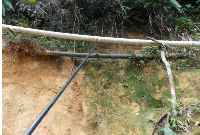
Figura 14. Conexión fraudulenta
