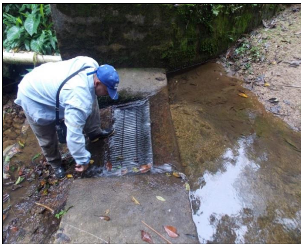
Figura 38. Bocatoma de fondo para captación del agua.
