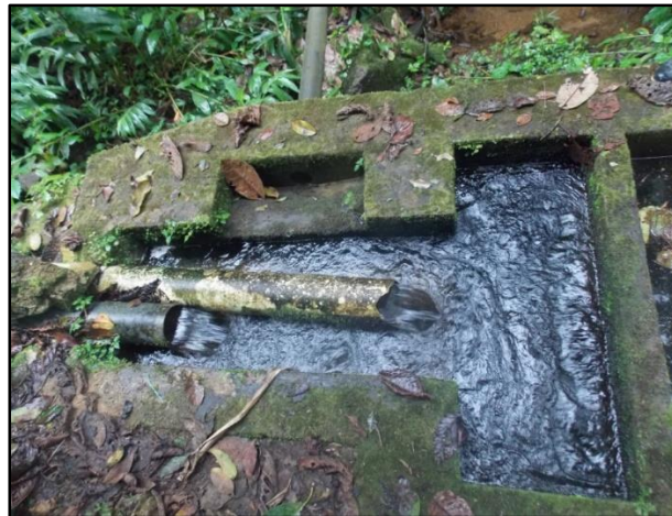
Figura 12. Tubería de llegada al desarenador.
