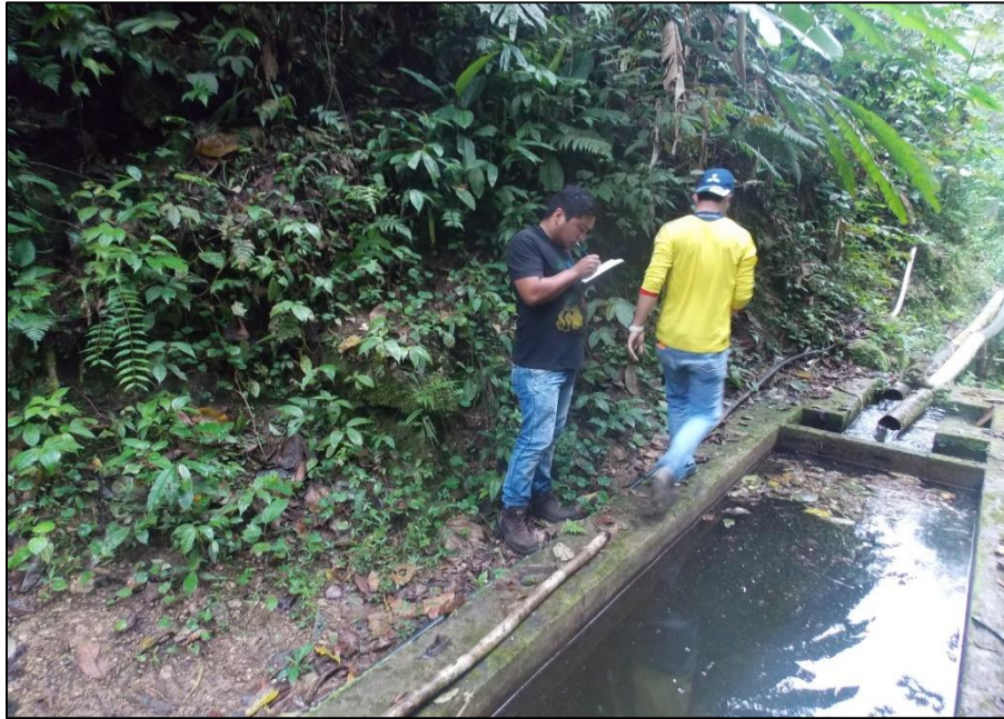
Figura 41. Mediciones para la evaluación hidráulica del desarenador. Fuente: Autores 2017
