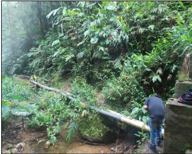
Figura 39. Medición de la longitud entre la bocatoma y el tanque desarenador Fuente: Autores 2017
