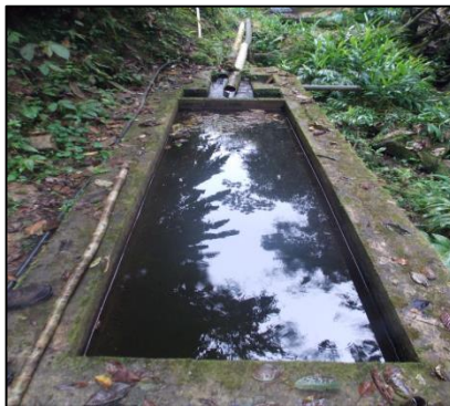
Figura 10. Tanque desarenador del sistema de acueducto de González
