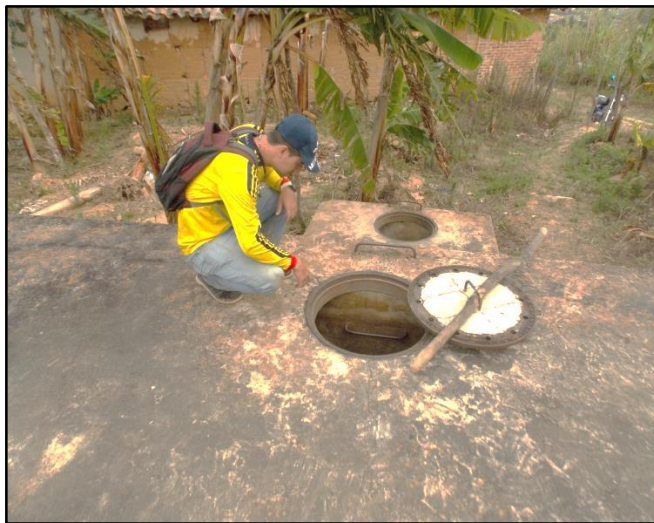
Figura 46. Inspección del tanque de almacenamiento
