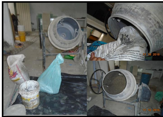
Figura 21. Elaboración de las mezclas de concreto.
