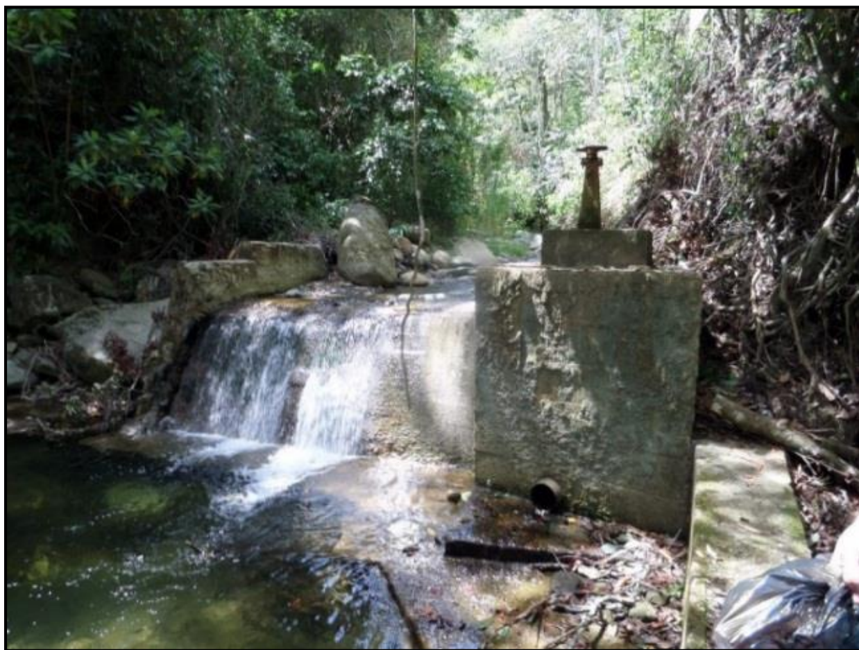
Figura 12. Captación existente – Quebrada la Enea.
