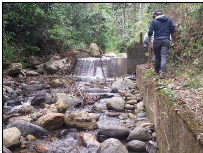
Figura 17. Tubería de aducción recubierta en concreto.
