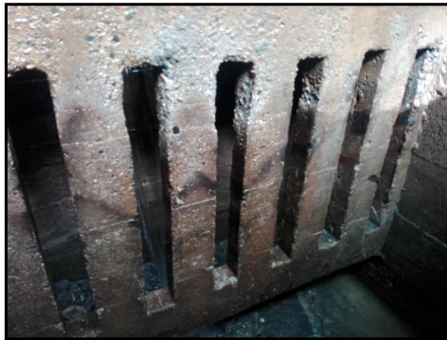
Figura 26. Pantalla deflectora rectangular.
