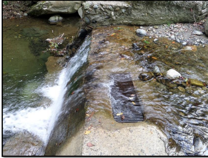
Figura 15. Rejilla de la captación existente.
