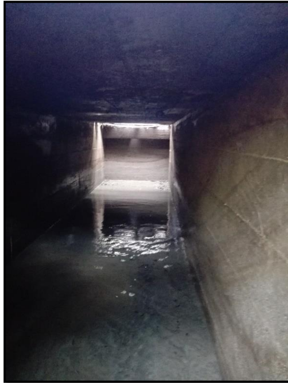
Figura 25. Vista interna del Desarenador actual.
