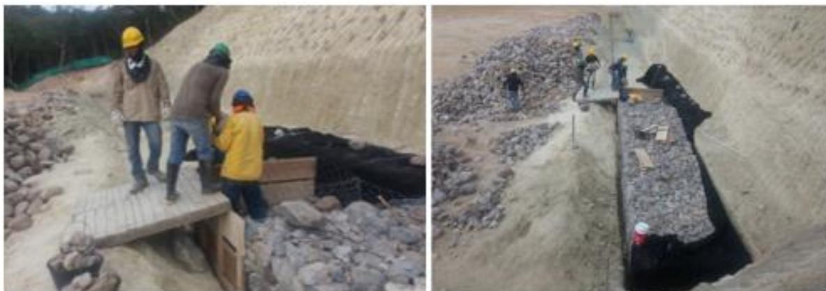
**Imagen 26.** Instalación de Geotextil.
