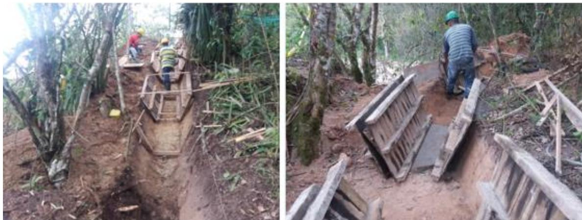
**Imagen 14.** Zanja de coronación, Instalación de formaletas y malla electro soldada.
