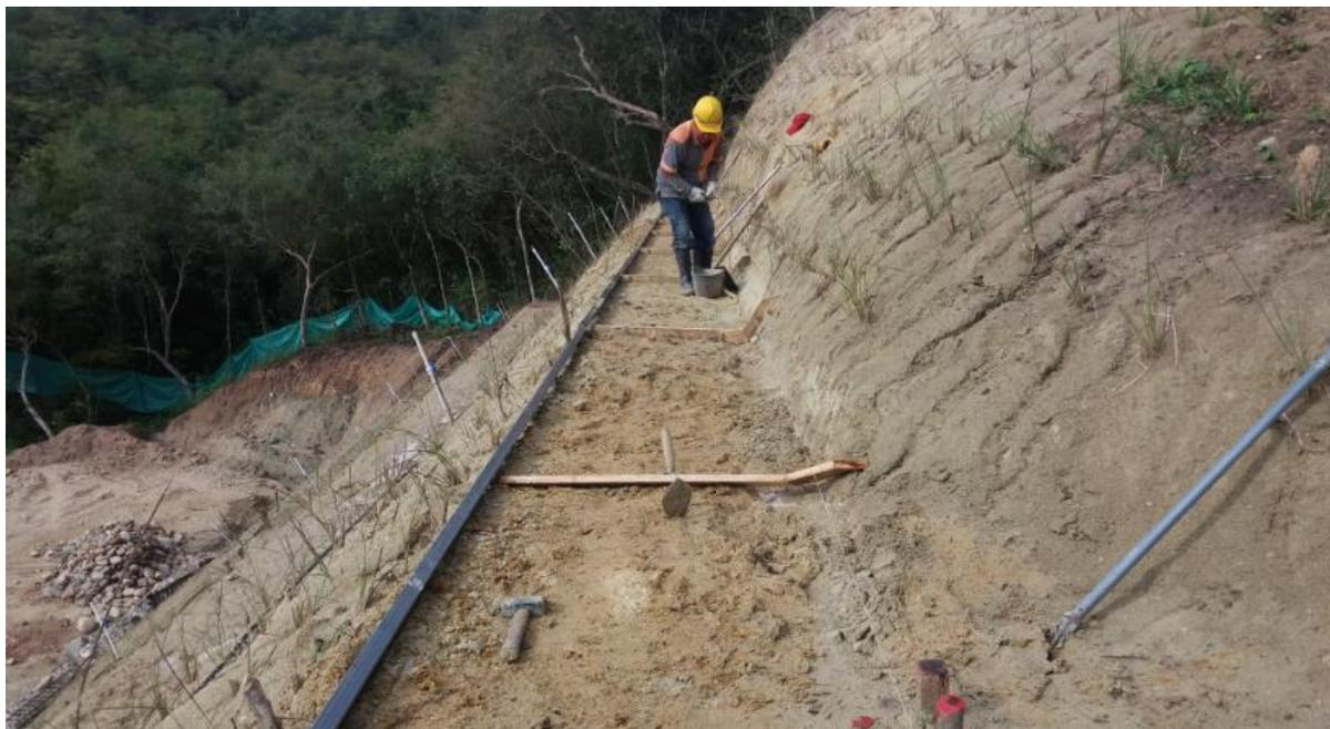
**Imagen 8.** Berma Cuneta, instalación de Formaleta y malla electrosoldada.
