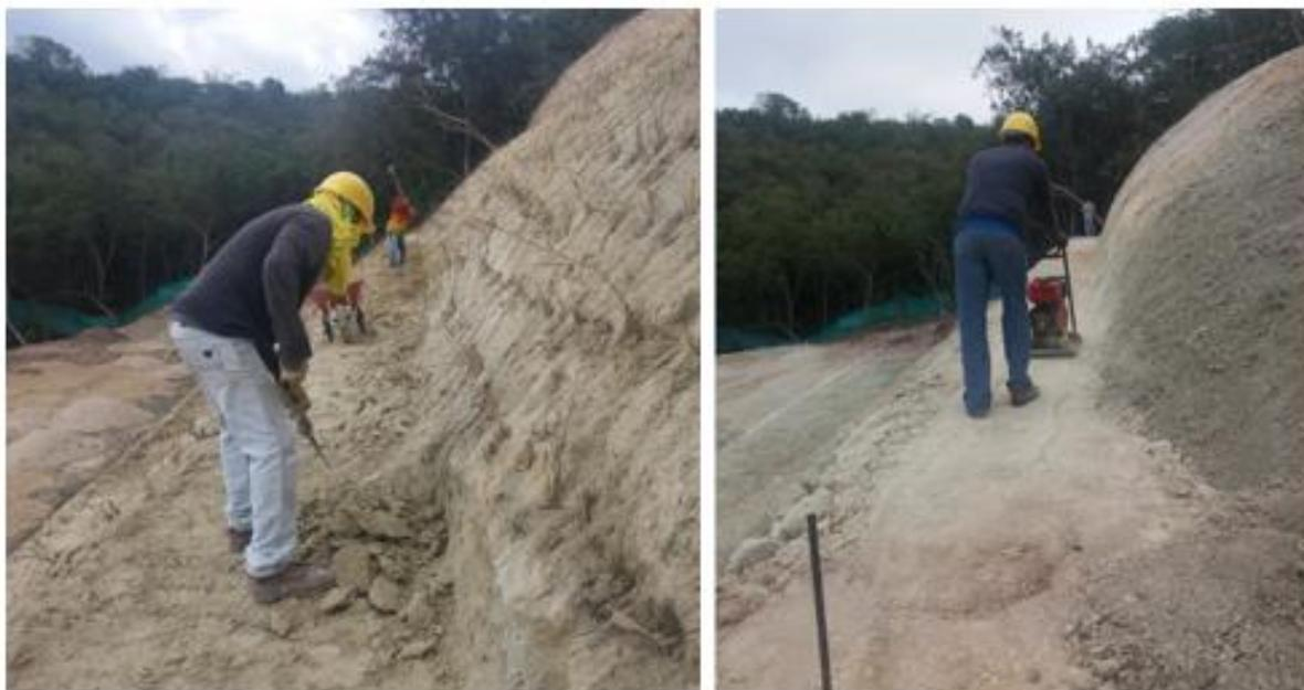
**Imagen 7.** Berma Cuneta, conformación de la superficie de apoyo.
