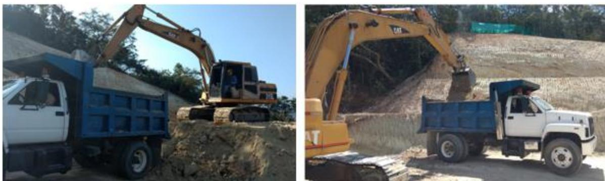
**Imagen 6.** Cargue y transporte de material de excavación.
