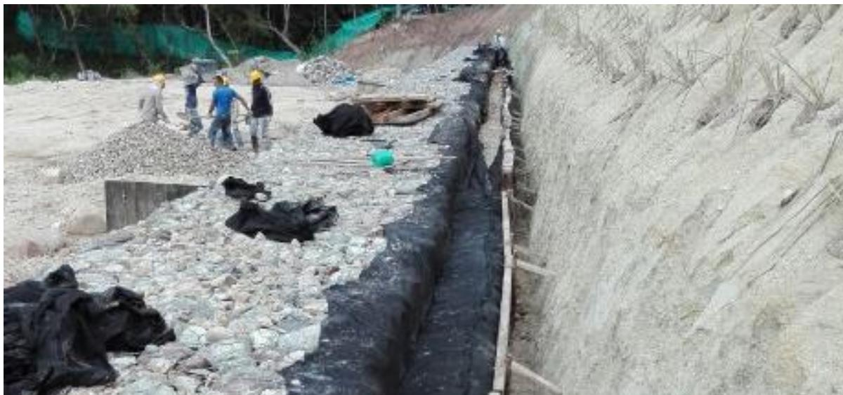
**Imagen 34.** Aseguramiento del geotextil
