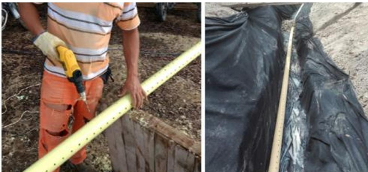
**Imagen 32.** Instalación de Geotextil y tubería perforada
