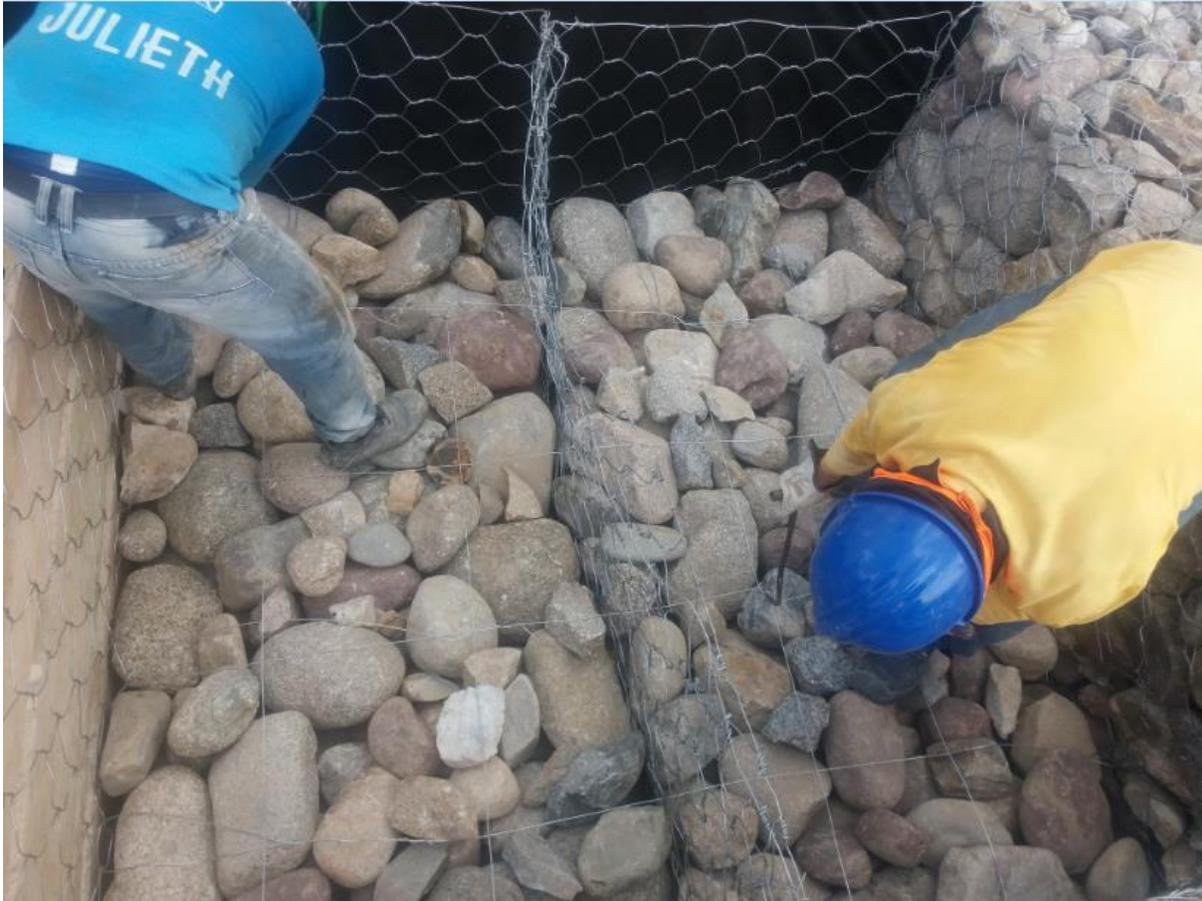
**Imagen 30.** Instalación de conectores de alambre en Gaviones
