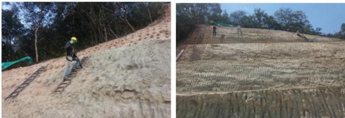
**Imagen 20.** Instalación de Pasto Vetiver, Preparación del suelo.
