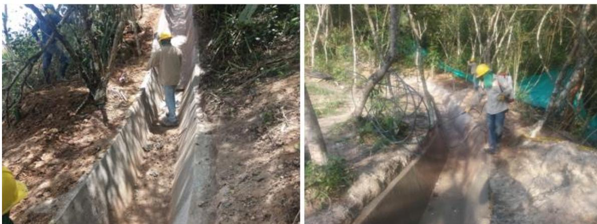
**Imagen 17.** Zanja de coronación, Aplicación de Anti sol.
