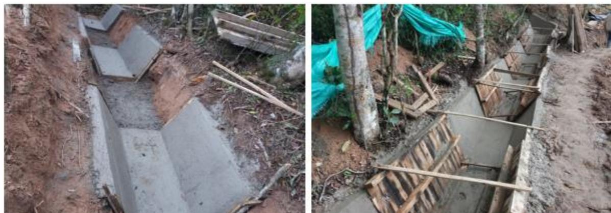
**Imagen 15.** Zanja de coronación, construcción.
