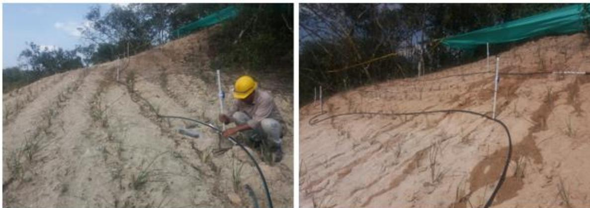
**Imagen 24.** Instalación de sistema de riego del vetiver.
