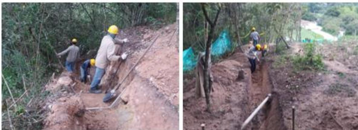
**Imagen 13.** Zanja de coronación, Conformación de la Superficie de Apoyo.
