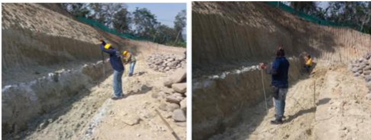
**Imagen 25.** Conformación del terreno para Gaviones.
