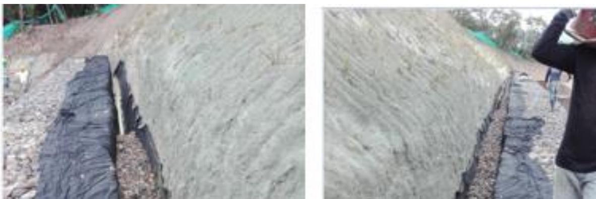
**Imagen 33.** Llenado con material filtrante.
