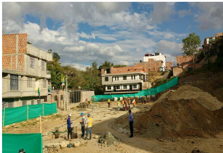
Figura 6: Adecuación del terreno del CIC (Centro de integración ciudadana).
