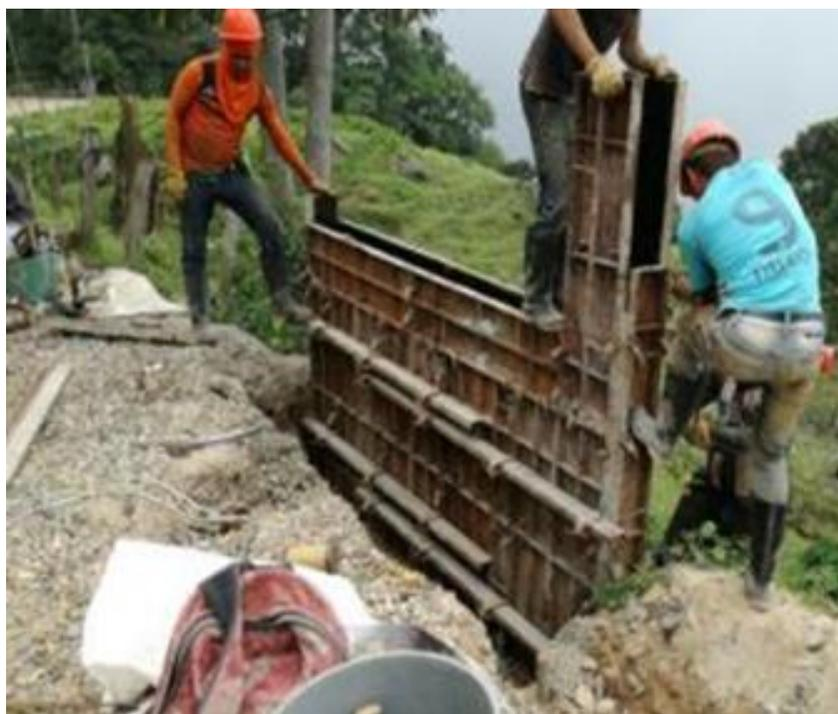
Figura 22. Construcción de bordillo de cierre PR13+380
