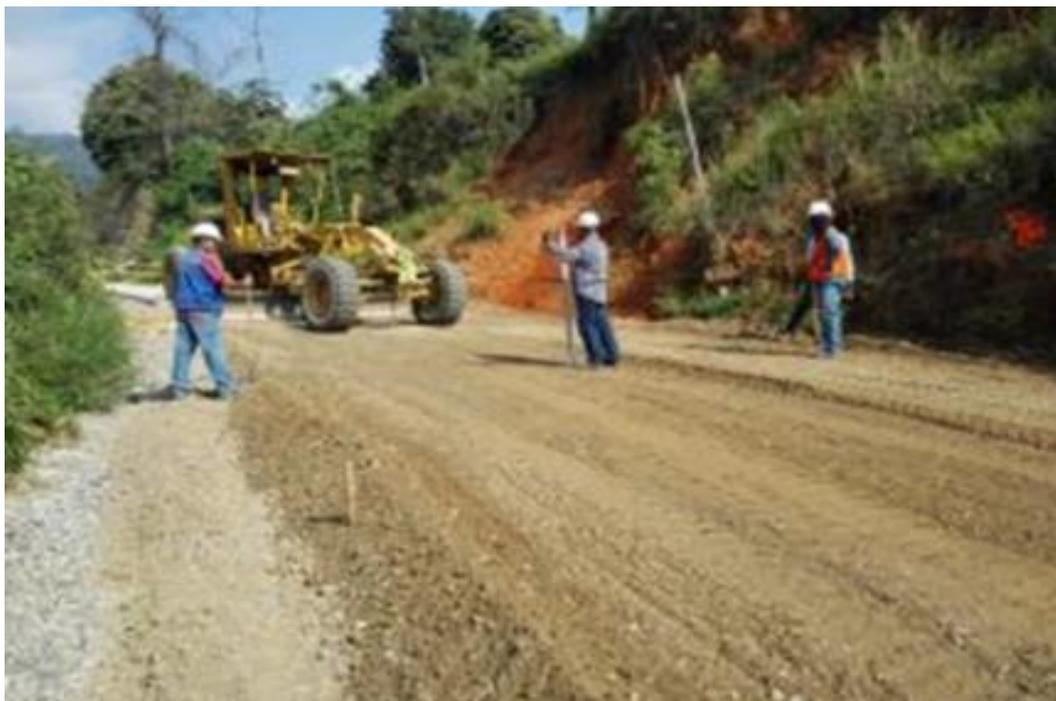
Figura 24. Céreo de base granular tramo PR13+500 al PR13+635
