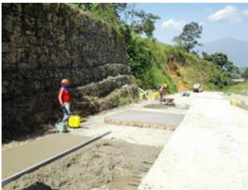
Figura 18. Construcción de losas en concreto borde derecho tramo
