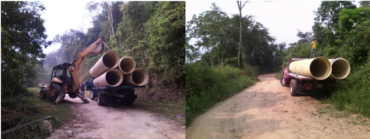
Figura 10. Transporte de alcantarillas.
