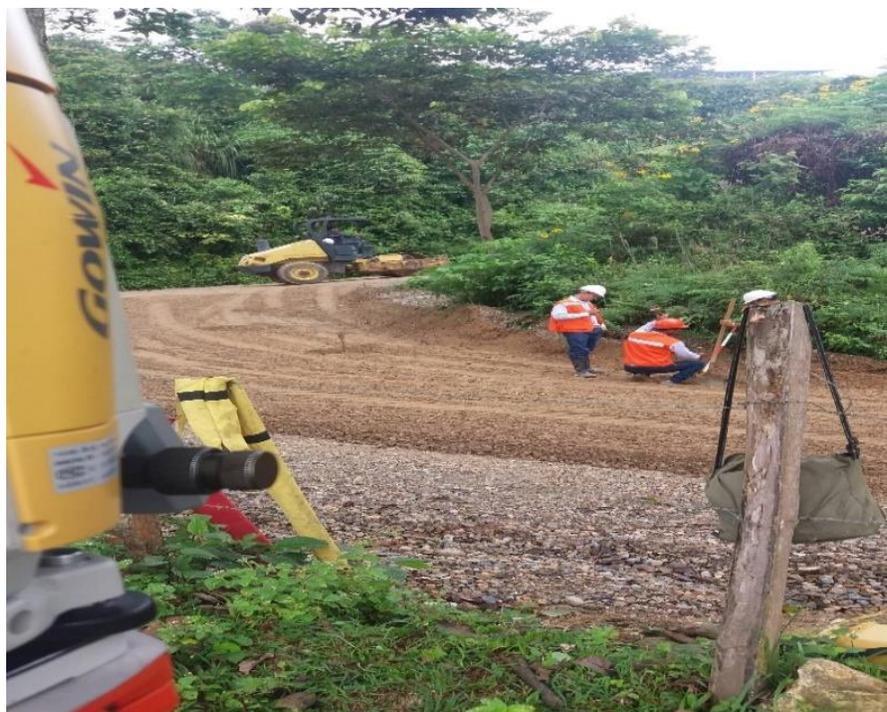
Figura 28. Topografía nivelación y cero de base granular segunda capa.
