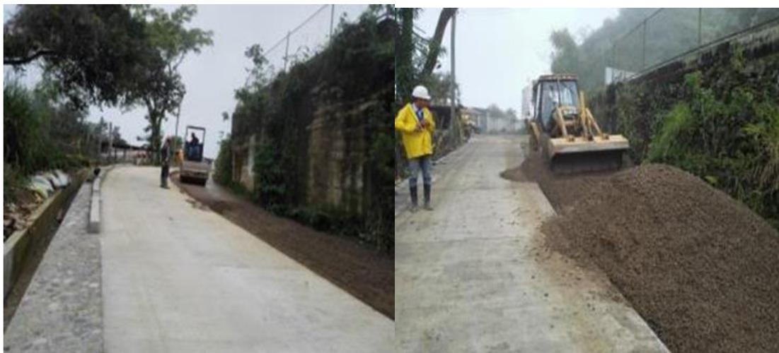
Figura 13. Vaciado y extensión de base granular carril derecho PR13+635-580
