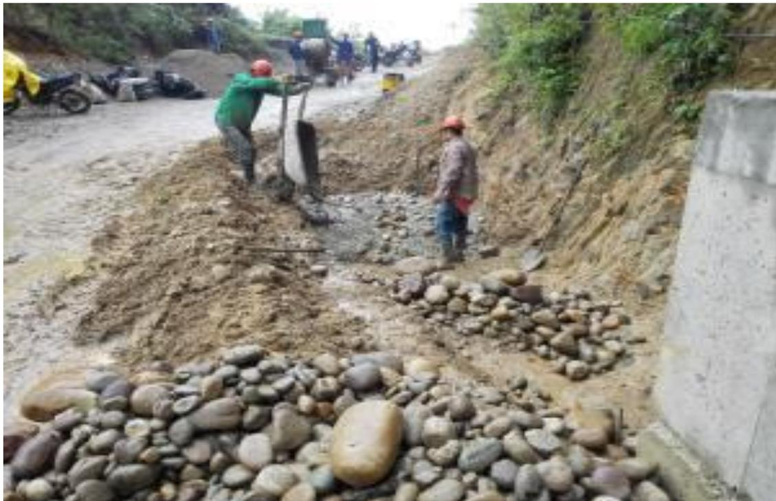
Figura 29. Construcción de extensión de canal abierto PR13+000
