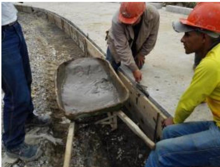
Figura 14. Construcción PR 13+600 aplicación de cemento fluido para proteger losas en concreto
