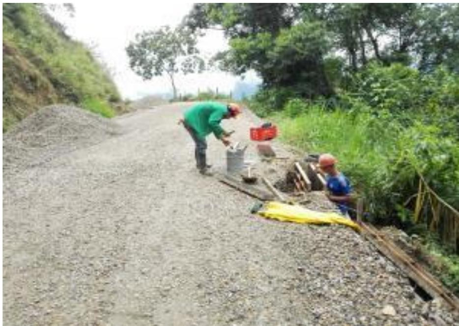
Figura 25 Construcción de bordillo de cierre para confinamiento de estructura de pavimento PR13+240
