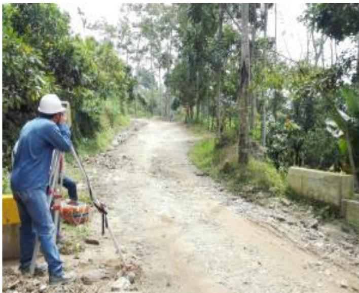
Figura 15. Levantamiento topográfico y control de niveles
