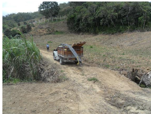
Figura 17. Material ingresando a la obra. Fuente: Autor del proyecto
