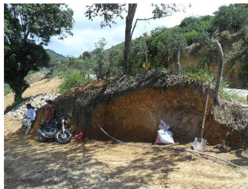
Figura 23. Talud intervenido (cercano vía acceso) Fuente: Autor del proyecto
