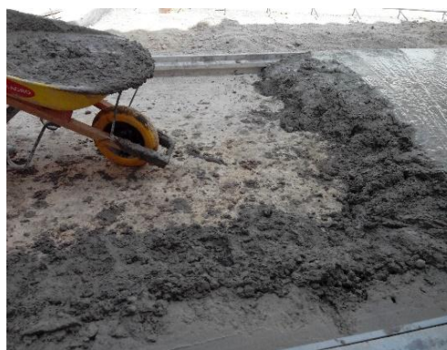
Figura 114. Vaciado de rieles de concreto Fuente: Autor del proyecto
