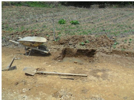
Figura 16. Excavación (presencia de nivel freático). Fuente: Autor del proyecto
