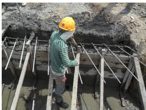
Figura 66. Vibrado manual del concreto (muro Box). Fuente: Autor del proyecto
