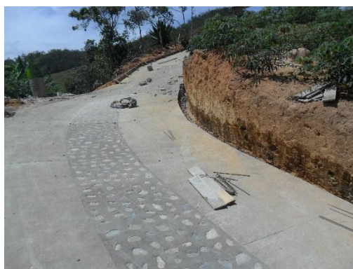
Figura 43. Tramo de vía pavimentado. Fuente: Autor del proyecto
