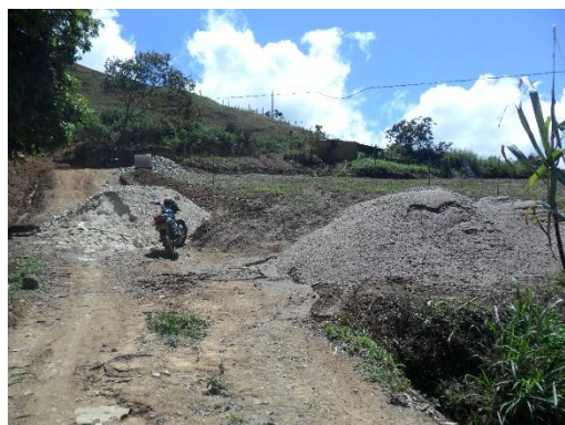
Figura 81. Material instalado en la obra. Fuente: Autor del proyecto
