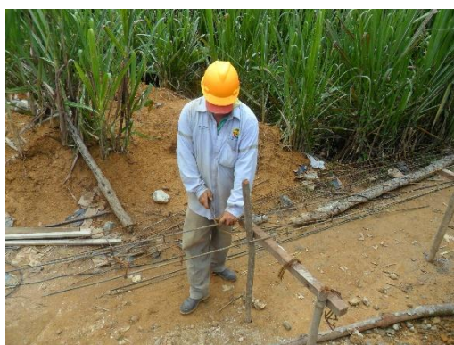
Figura 44. Figurado y armado del acero. Fuente: Autor del proyecto
