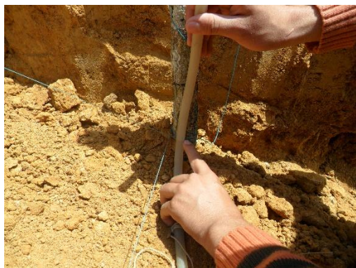
Figura 10. Nivelación del terreno (manguera nivel). Fuente: Autor del proyecto
