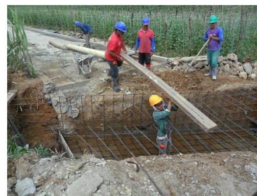
Figura 57. Acero de refuerzo boxculvert. Fuente: Autor del proyecto
