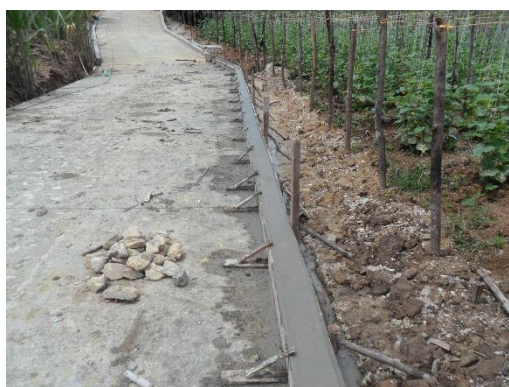
Figura 50. Bordillos fundidos. Fuente: Autor del proyecto
