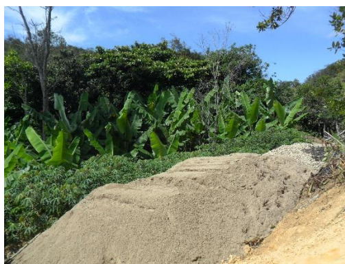
Figura 19. Material ubicado en la zona prevista. Fuente: Autor del proyecto
