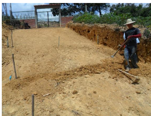
Figura 15. Replanteo y nivelación del terreno. Fuente: Autor del proyecto
