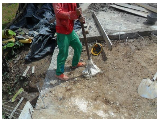
Figura 68. Compactación manual del terreno. Fuente: Autor del proyecto
