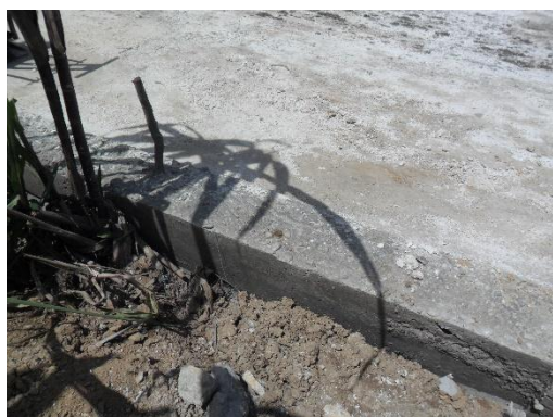
Figura 42. Muro de contención (zona media). Fuente: Autor del proyecto
