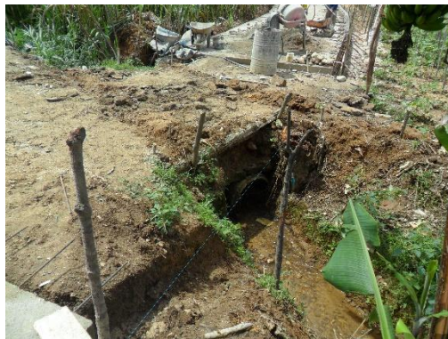
Figura 53. Estructura de drenaje existente. Fuente: Autor del proyecto
