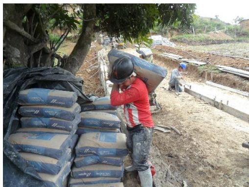
Figura 83. cemento almacenado en la obra. Fuente: Autor del proyecto
