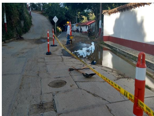
Figura 107. Delimitación del sitio de la obra. Fuente: Autor del proyecto
