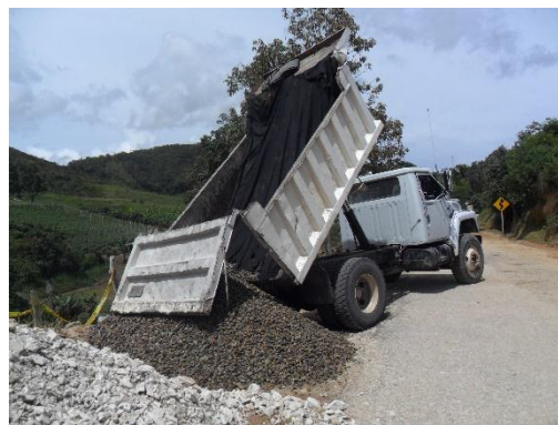
Figura 84. Descargue de material. Fuente: Autor del proyecto
