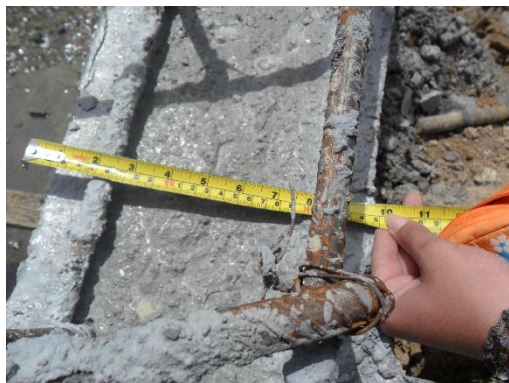
Figura 103. Verificación de espesor de muro Fuente: Autor del proyecto
