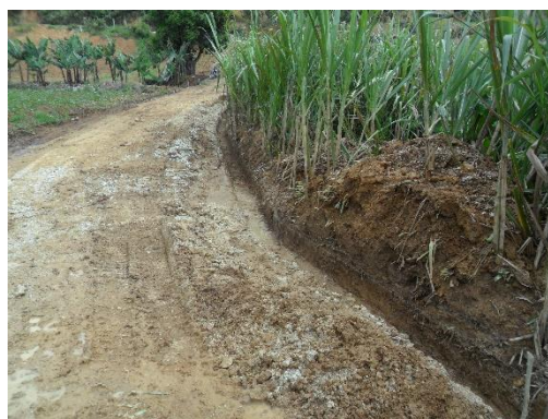
Figura 31. Excavación para Muros de contención. Fuente: Autor del proyecto
