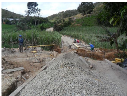
Figura 85. Material existente en la obra. Fuente: Autor del proyecto
