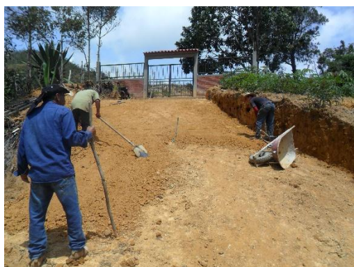
Figura 12. Revisión del ancho de la vía. Fuente: Autor del proyecto
