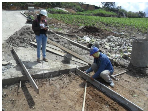
Figura 70. Formateado del tramo de vía faltante. Fuente: Autor del proyecto
