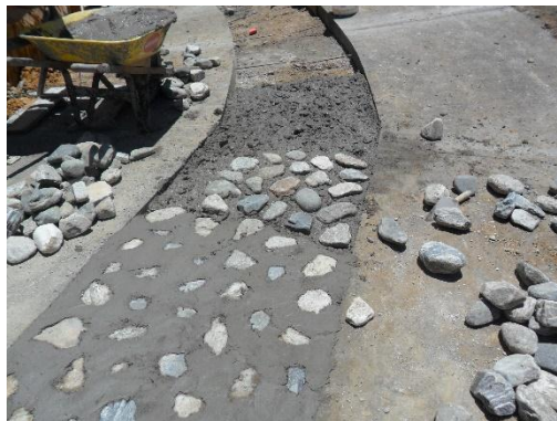
Figura 35. Colocación de piedras para ciclópeo. Fuente: Autor del proyecto
