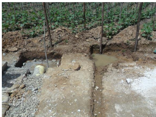
Figura 40. Canalización de agua hacia la cañada. Fuente: Autor del proyecto
