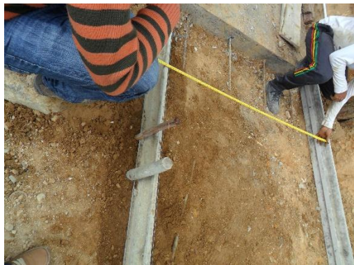
Figura 95. Verificación de anchos de carril Fuente: Autor del proyecto
