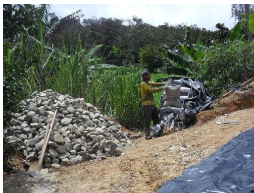
Figura 80. Zona temporal de almacenamiento. Fuente: Autor del proyecto
