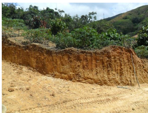
Figura 13. Talud intervenido. Fuente: Autor del proyecto
