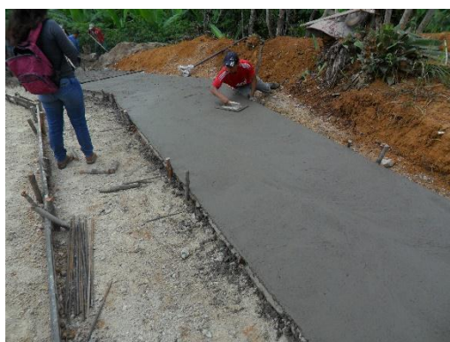
Figura 26. Allanado de los rieles en concreto Fuente: Autor del proyecto
