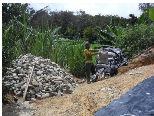
Figura 30. Material utilizado en obra. Fuente: Autor del proyecto
