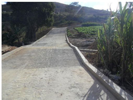
Figura 76. Placa huella terminada. Fuente: Autor del proyecto
