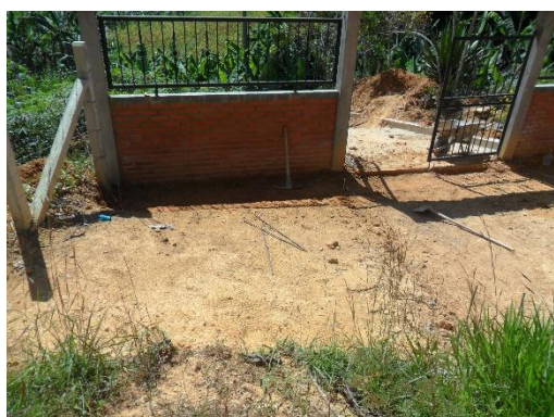
Figura 74. Terreno compactado y nivelado. Fuente: Autor del proyecto
