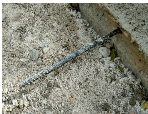
Figura 116. Acero de refuerzo para juntas. Fuente: Autor del proyecto
