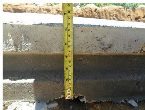
Figura 94. Verificación de espesores Fuente: Autor del proyecto
