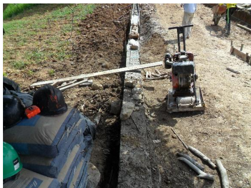
Figura 91. Vibrocompactador tipo rana. Fuente: Autor del proyecto
