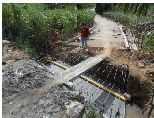
Figura 61. Placa base fundida. Fuente: Autor del proyecto
