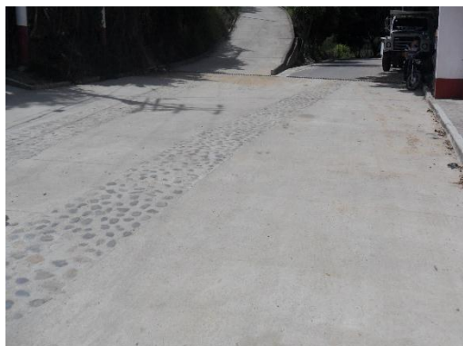
Figura 125. Pavimento en concreto terminado. Fuente: Autor del proyecto
