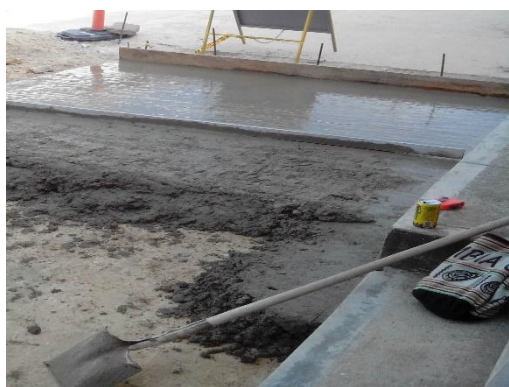
Figura 115. Vaciado rieles de concreto Fuente: Autor del proyecto
