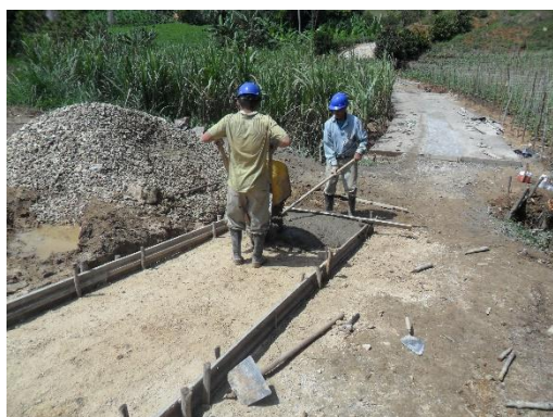
Figura 48. Transporte y vaciado del concreto. Fuente: Autor del proyecto
