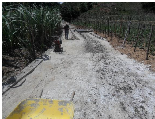
Figura 39. Receba compactada sobre el terreno. Fuente: Autor del proyecto
