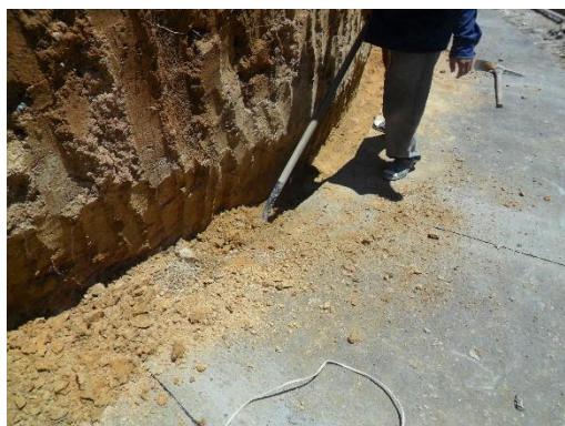
Figura 38. Excavaciones para los bordillos. Fuente: Autor del proyecto
