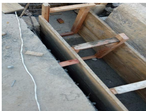
Figura 121. Formateado canal longitudinal Fuente: Autor del proyecto
