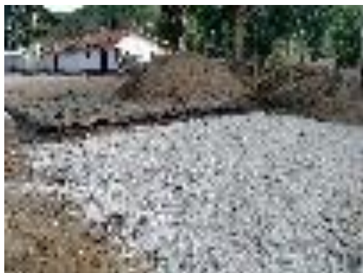
Figura 128. Material existente en la obra. Fuente: Autor del proyecto
