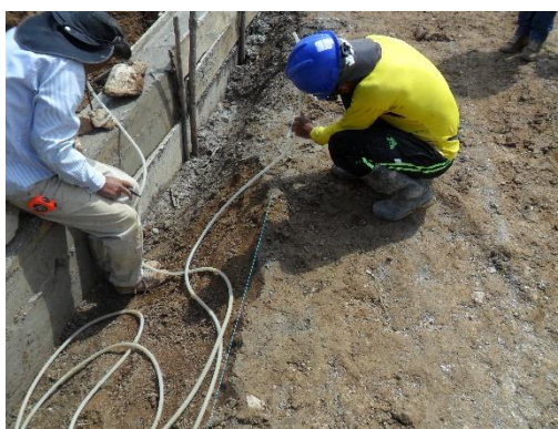
Figura 45. Verificación de niveles. Fuente: Autor del proyecto
