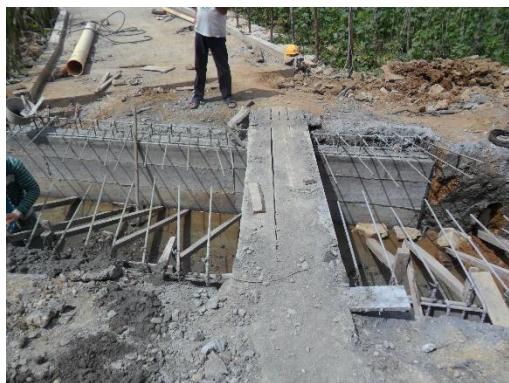
Figura 64. Muro del boxculvert fundido. Fuente: Autor del proyecto
