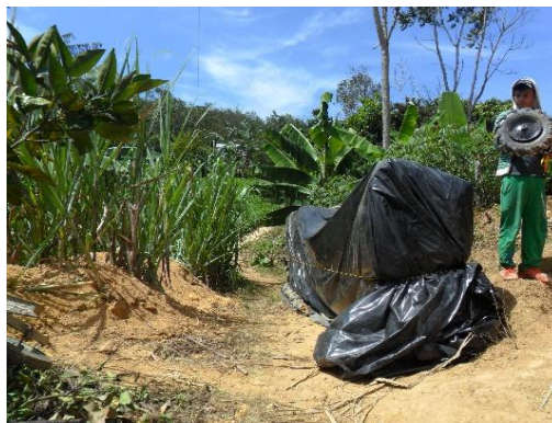
Figura 78. Cemento debidamente cubierto. Fuente: Autor del proyecto
