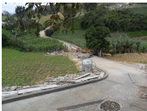
Figura 60. Avance de la obra. Fuente: Autor del proyecto
