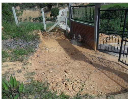
Figura 63. Excavación (Entrada cementerio). Fuente: Autor del proyecto
