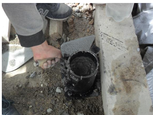
Figura 99. Preparación de los cilindros Fuente: Autor del proyecto
