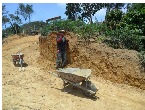
Figura 14. Remoción de material del talud. Fuente: Autor del proyecto
