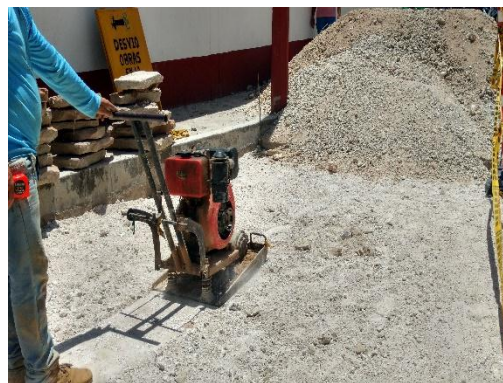
Figura 112. Mejoramiento de la subrasante Fuente: Autor del proyecto
