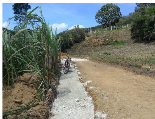
Figura 21. Receba compactada (zanja del muro) Fuente: Autor del proyecto
