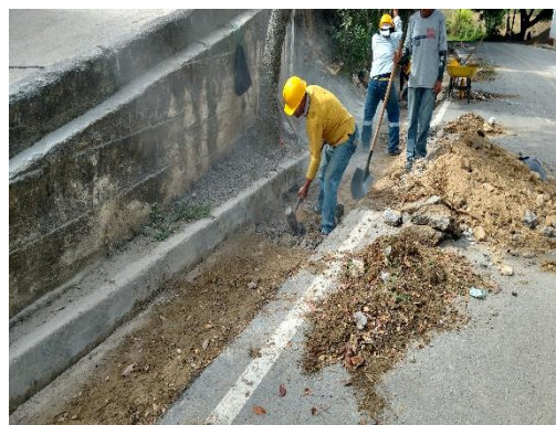
Figura 110. Demolición manual de cunetas. Fuente: Autor del proyecto
