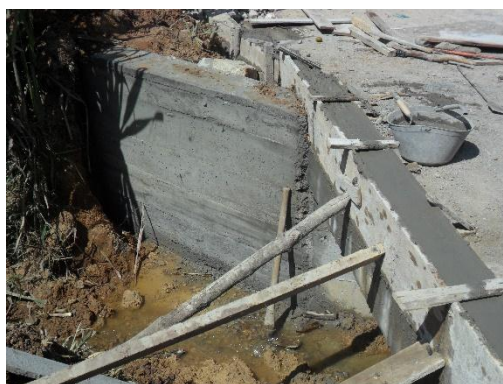
Figura 73. Aleta fundida. Fuente: Autor del proyecto
