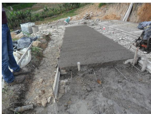
Figura 54. Placas de concreto fundidas. Fuente: Autor del proyecto
