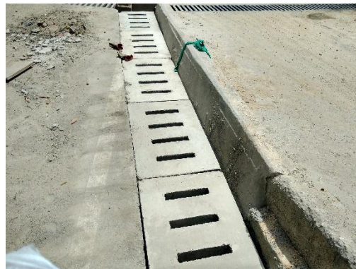
Figura 124. Rejillas en concreto para el canal longitudinal Fuente: Autor del proyecto
