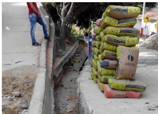
Figura 130. Cemento acumulado para su uso. Fuente: Autor del proyecto
