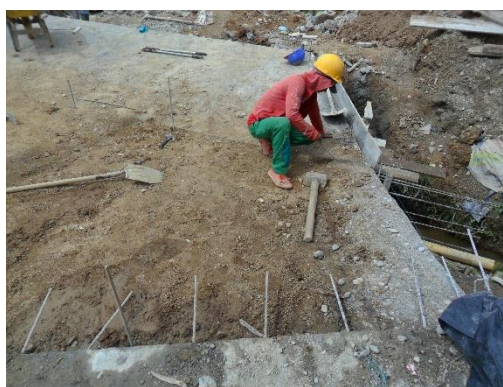
Figura 69. Replanteo del tramo de vía. Fuente: Autor del proyecto
