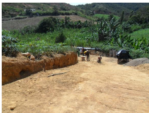
Figura 18. Terreno nivelado y compactado. Fuente: Autor del proyecto
