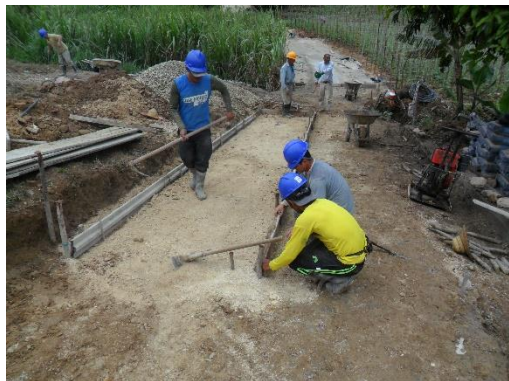
Figura 46. Formateado y aplicación de receba. Fuente: Autor del proyecto
