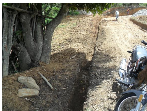
Figura 32. Excavación para muro de contención. Fuente: Autor del proyecto
