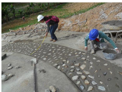
Figura 56. Acabado final del ciclópeo. Fuente: Autor del proyecto
