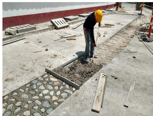
Figura 118. Riel en concreto ciclópeo. Fuente: Autor del proyecto
