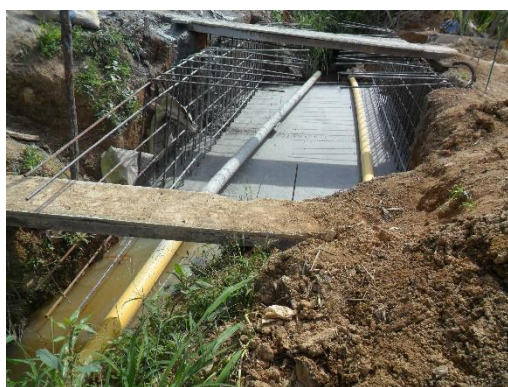
Figura 62. Canalización de la quebrada (Tub. 4”). Fuente: Autor del proyecto
