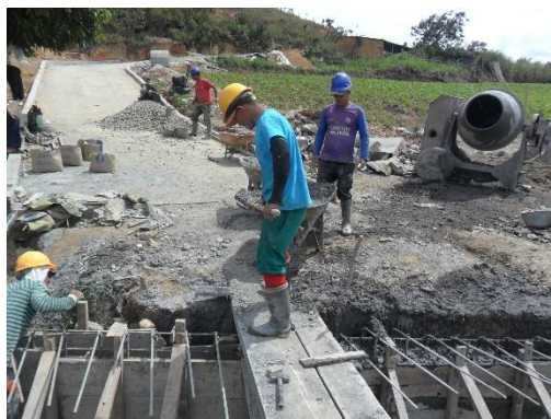
Figura 65. Vaciado de concreto sobre muros (Box). Fuente: Autor del proyecto
