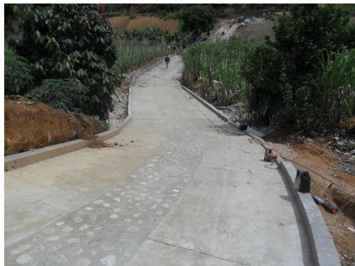
Figura 52. Avance de la obra. Fuente: Autor del proyecto
