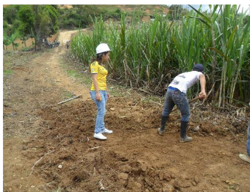
Figura 7. Nivelación manual del terreno. Fuente: Autor del proyecto
