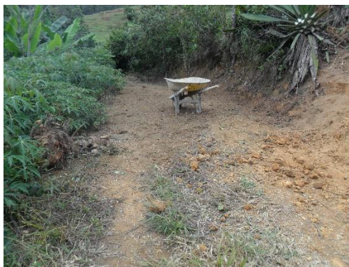
Figura 5. Sitio para almacenamiento de material. Fuente: Autor del proyecto
