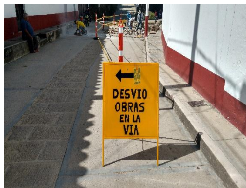
Figura 108. Señalización del sitio de la obra. Fuente: Autor del proyecto
