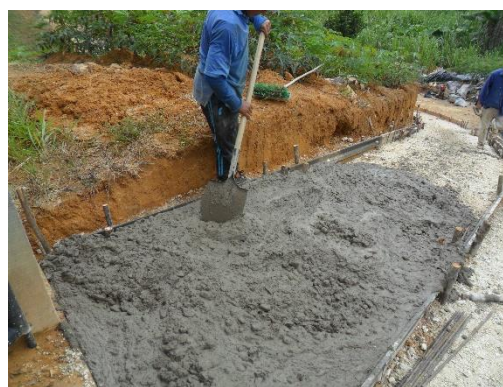
Figura 27. chuzado con herramienta menor Fuente: Autor del proyecto
