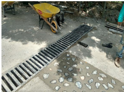
Figura 123. Instalación de rejilla en hierro Fundido para canal transversal Fuente: Autor del proyecto
