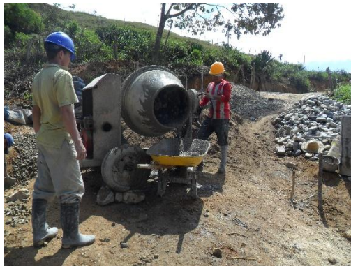
Figura 47. Elaboración de la mezcla. Fuente: Autor del proyecto
