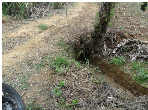
Figura 8. Alcantarilla existente. Fuente: Autor del proyecto
