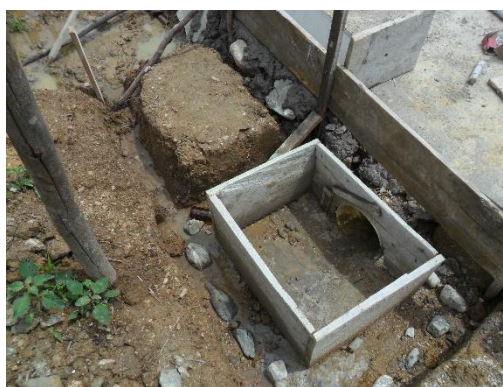
Figura 51. Formaleta para la caja de Inspección. Fuente: Autor del proyecto
