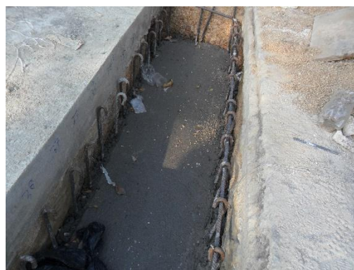
Figura 120. Acero de refuerzo de canal transversal. Fuente: Autor del proyecto
