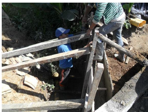
Figura 72. Formateado aleta del boxculvert. Fuente: Autor del proyecto
