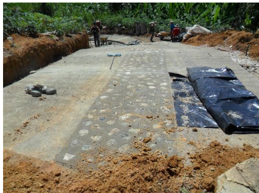
Figura 34. Tramo de vía pavimentado. Fuente: Autor del proyecto
