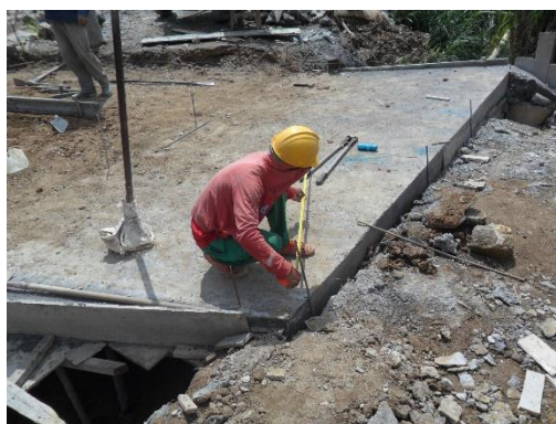
Figura 67. Placa superior del boxculvert. Fuente: Autor del proyecto
