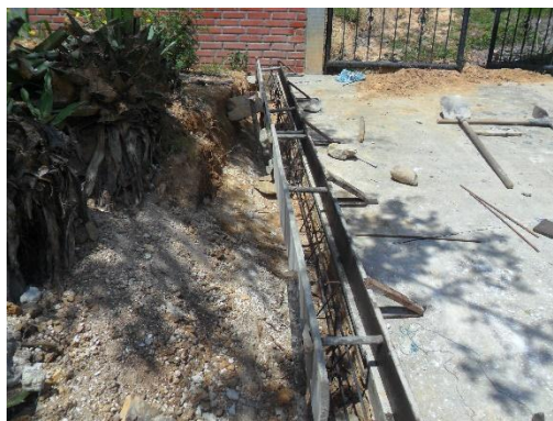
Figura 41. Formateado y refuerzo de bordillos. Fuente: Autor del proyecto
