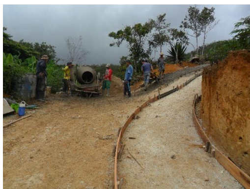
Figura 24. Formateado de un tramo de vía Fuente: Autor del proyecto
