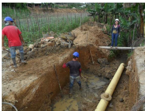
Figura 55. Manejo de aguas y excavaciones. Fuente: Autor del proyecto
