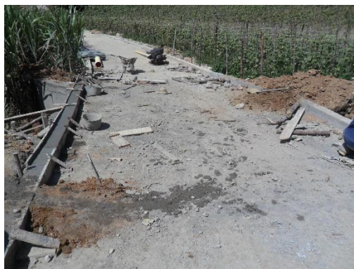
Figura 71. Tramo del boxculvert pavimentado. Fuente: Autor del proyecto
