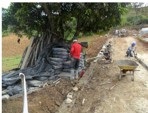
Figura 82. cemento almacenado en la obra. Fuente: Autor del proyecto
