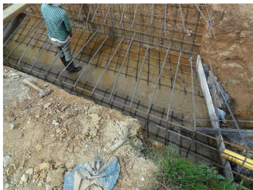
Figura 58. Acero de refuerzo para muros y base. Fuente: Autor del proyecto
