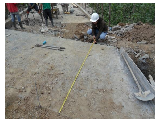
Figura 106. Verificación de medidas (ancho) Fuente: Autor del proyecto
