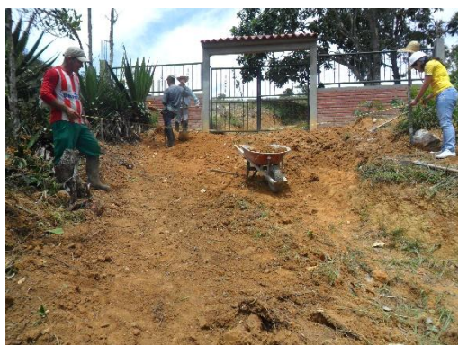
Figura 6. Tramo crítico (altas pendientes). Fuente: Autor del proyecto
