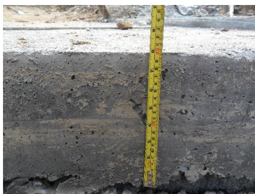
Figura 105. Verificación de espesor placa (Box) Fuente: Autor del proyecto
