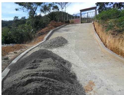
Figura 86. Material existente en la obra. Fuente: Autor del proyecto
