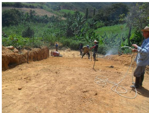
Figura 11. Zona crítica (pendiente) intervenida. Fuente: Autor del proyecto.
