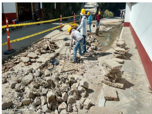
Figura 109. Demolición manual de placas de concreto. Fuente: Autor del proyecto
