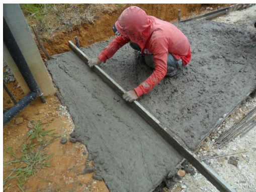
Figura 28. Corte y nivelación de la superficie Fuente: Autor del proyecto
