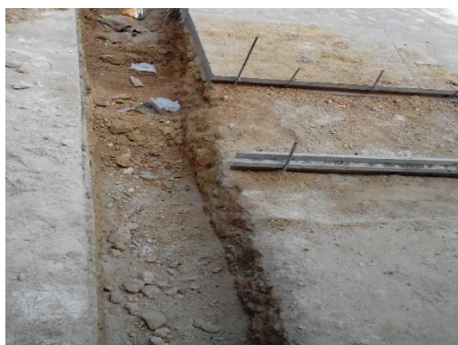
Figura 119. Excavación para el canal de recolección. Fuente: Autor del proyecto
