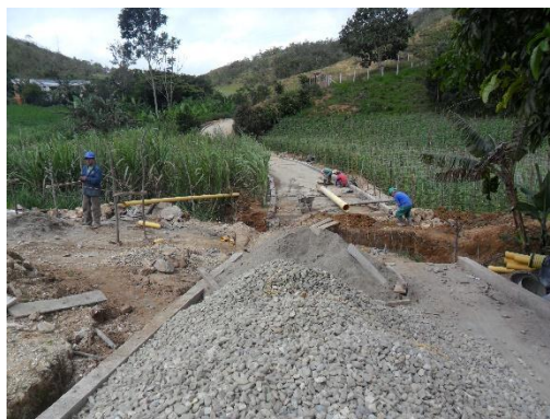
Figura 59. Material utilizado en la obra. Fuente: Autor del proyecto
