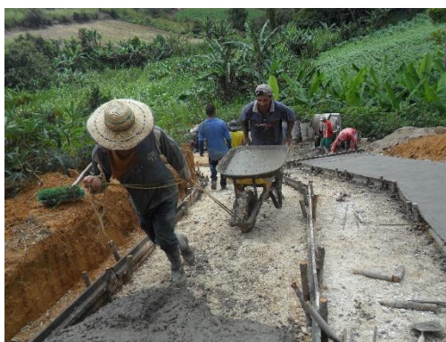
Figura 25. Transporte y vaciado de concreto Fuente: Autor del proyecto
