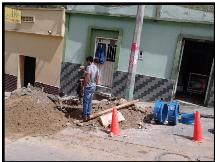
Fotografía N° 9. Reparación tubería 18" Sector La Popa.
