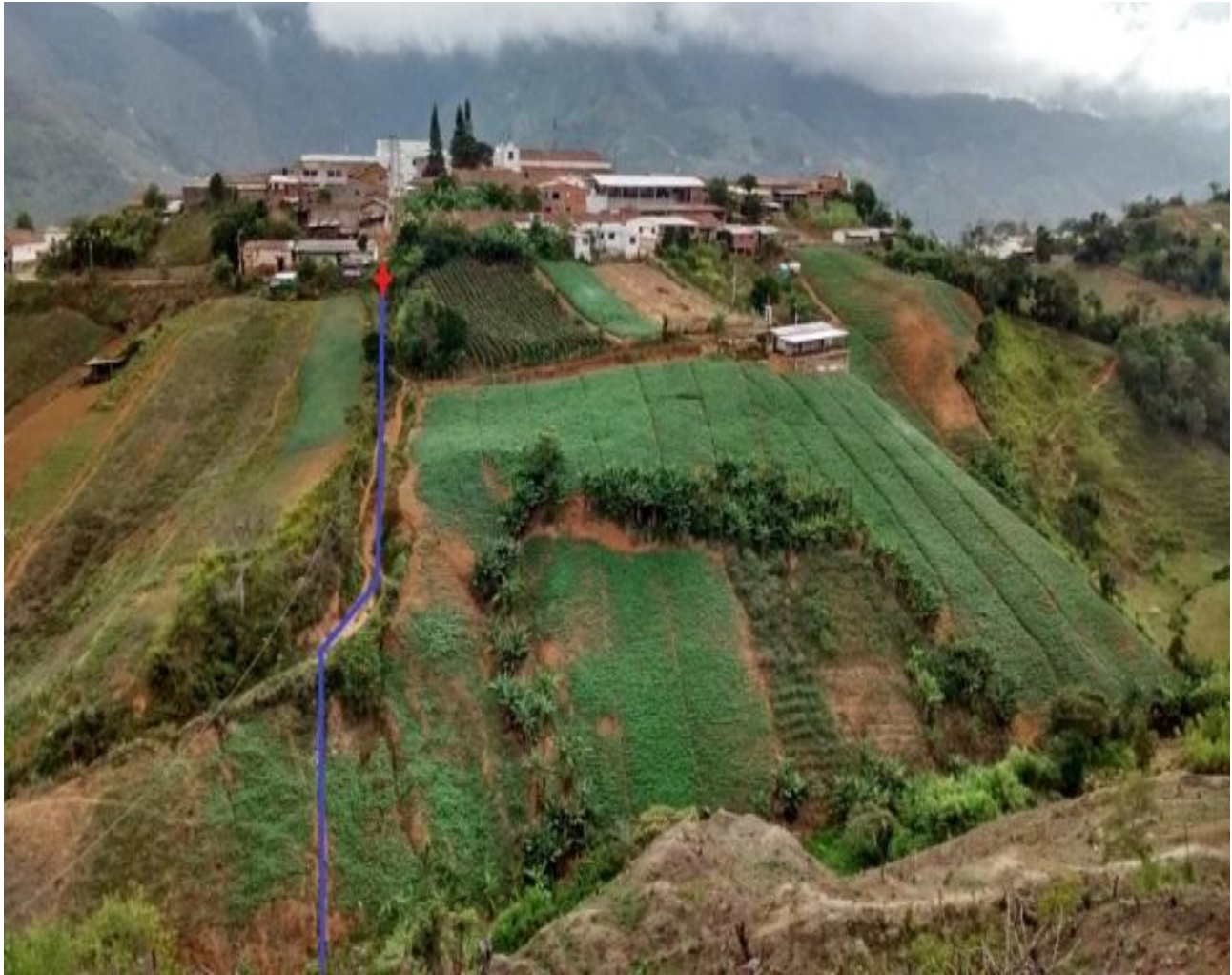
Fotografía 19. Vista general de Otaré desde la PTAP. La línea azul corresponde a la línea de conducción y el punto rojo al lugar donde están ubicadas las válvulas de corte.
