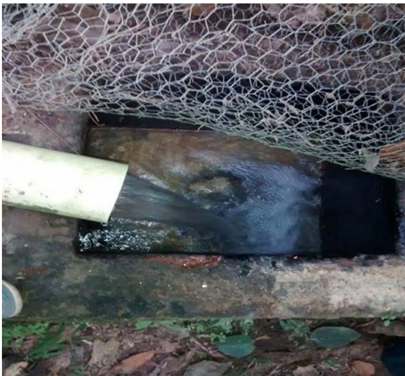
Fotografía 3. Vista general del tanque para aforo.
