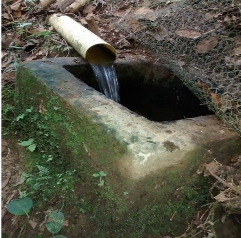
Fotografía 2. . Llenado de tanque para aforo
