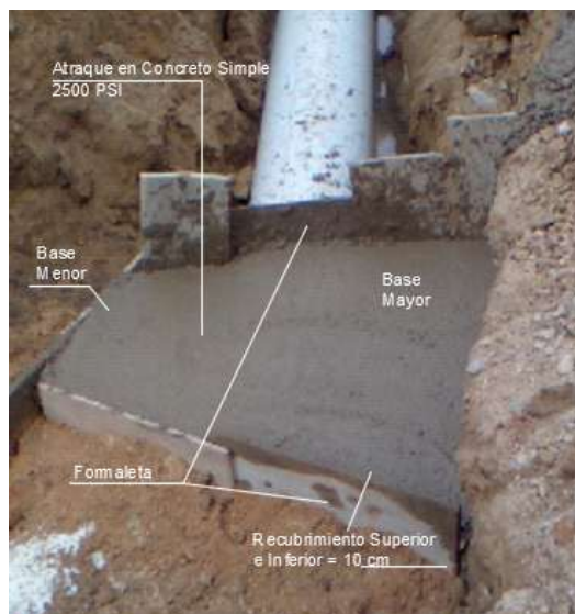
Foto 36. Atraque en concreto en codo de 45
