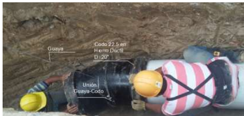
Foto 34. Instalación de Codo de 22.5 en Hierro Dúctil (HD) Diámetro=20"
