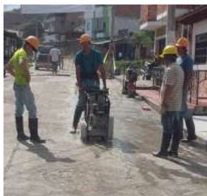
Foto 19. Obrero haciendo corte de pavimento en el inicio del proyecto
