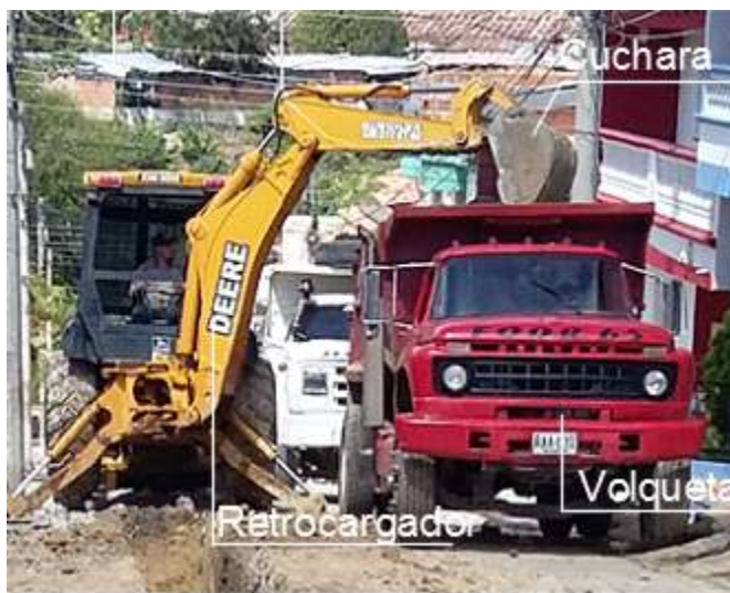
Foto 26. Cargue de material de sitio a las Volquetas
