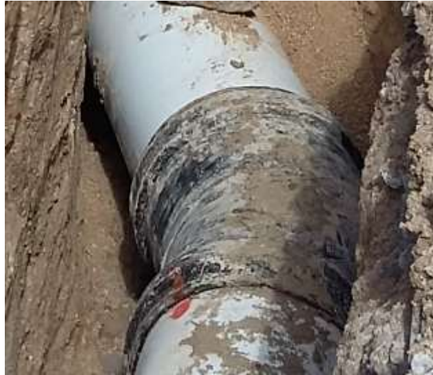
Foto 33. Codo 22.5 en Hierro Dúctil (HD) Diámetro 20"
