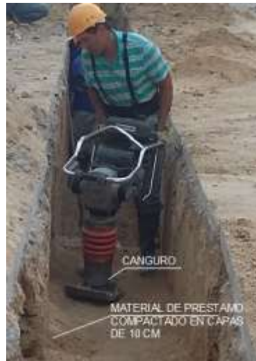
Foto 38. Compactación mecánica de material de préstamo
