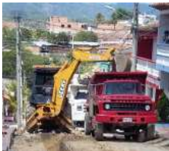
Foto 12. Retro cargador cargando el material de sitio a las volquetas
