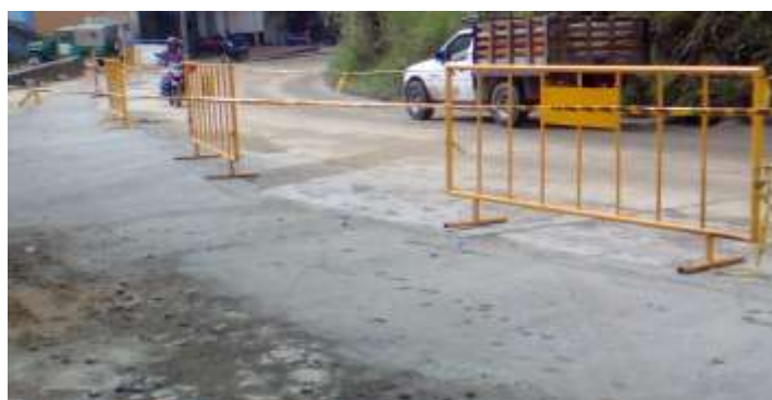
Foto 49. Señalización para evitar el paso de terceros y vehículos sobre el nuevo pavimento
