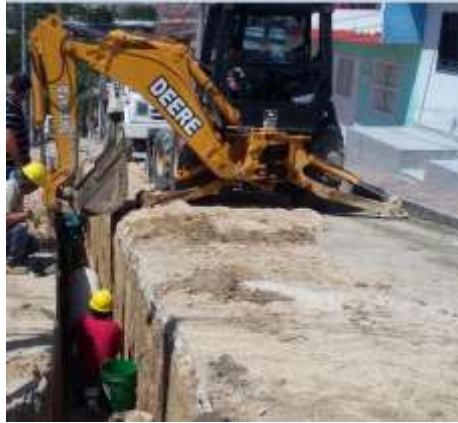
Foto 13. Retro cargador ayudando a bajar tubería Pvc 20” a la excavación
