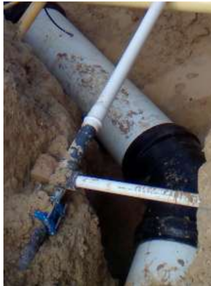
Foto 32. Instalación de Codo de 45 en Hierro Dúctil (HD) Diámetro=20"
