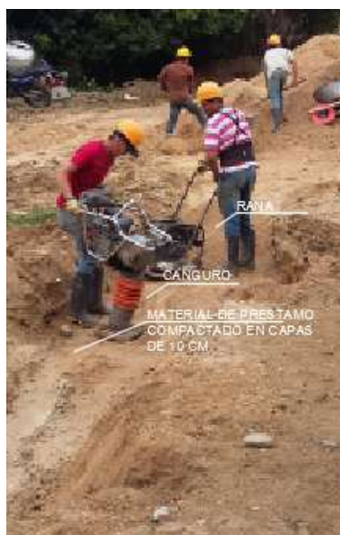
Foto 37. Compactación mecánica de material de préstamo
