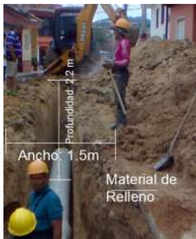
Foto 22. Excavación mecánica tramo 3-4
