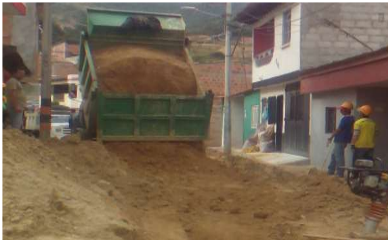
Foto 8. Volqueta descargando material de sitio
