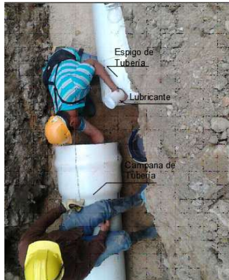
Foto 30. Obrero aplicando lubricante en la campana de tubería PVC 20''
