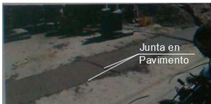
Foto 48. Junta constructiva en concreto
