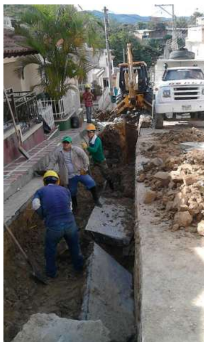
Foto 23. Excavación mecánica y manual de losa completa tramo 2-3
