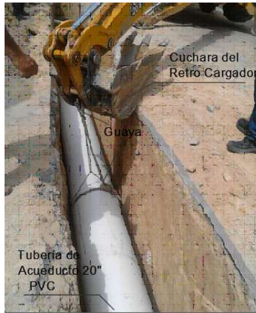
Foto 29. Instalación de tubería PVC 20"
