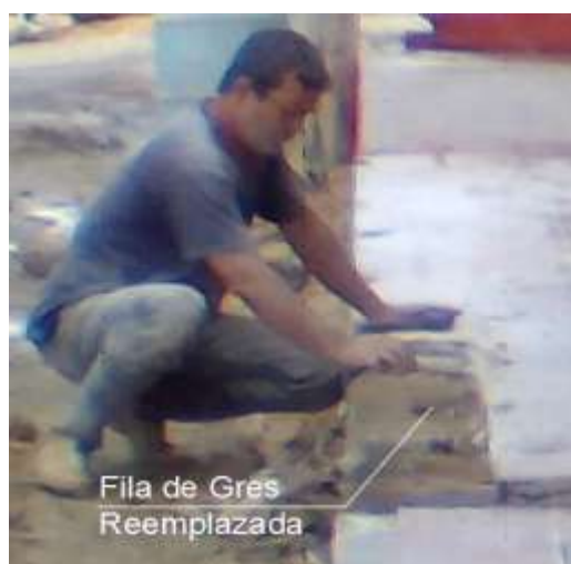
Foto 50. Obrero realizando las reparaciones en los andenes afectados
