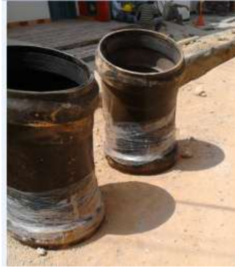
Foto 31. Codo de 45 a la orilla de la excavación
