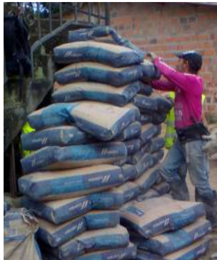
Foto 43. Cemento utilizado en el proceso de pavimentación
