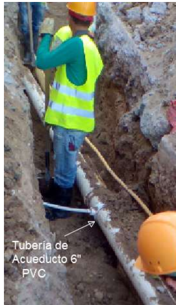
Foto 24. Tubería 6" PVC atraviesa la excavación del tramo 5-6
