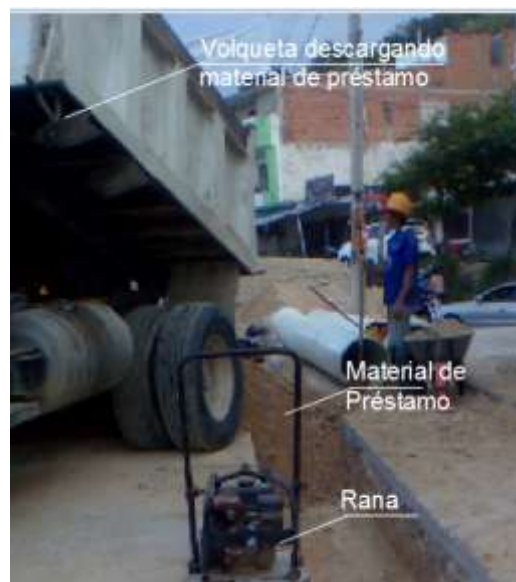
Foto 39. Volqueta descargando material de préstamo para relleno de excavación
