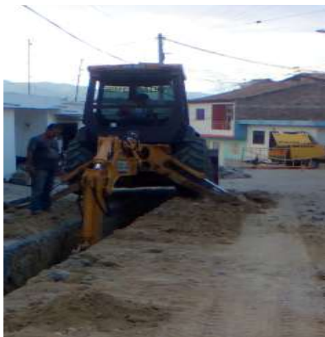
Foto 11. Retro cargador haciendo la excavación
