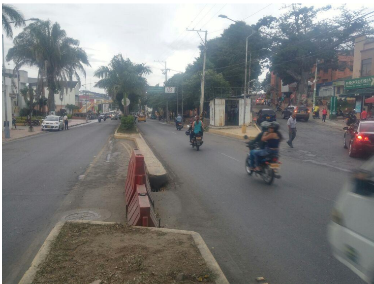
Figura 2. Imagen del punto de estudio K050+088 ruta 70 tramo 07 sobre la avenida Francisco Fernández de Contreras.
