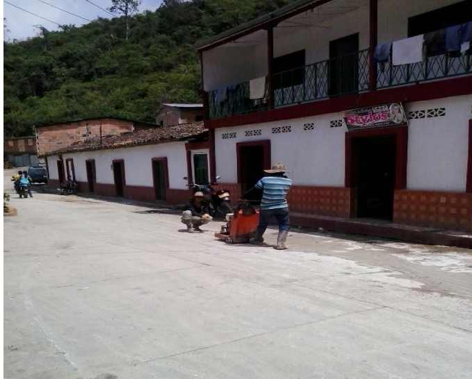
Figura 5. Corte de pavimento rígido con disco
