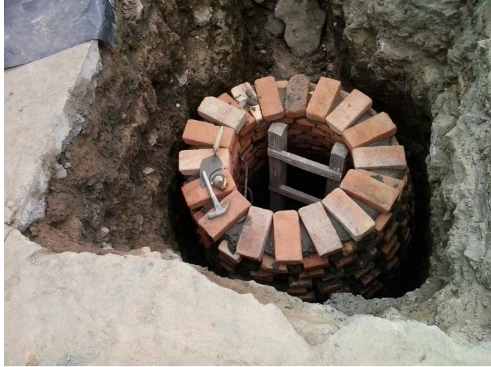
Figura 11. Construcción de pozo Cilindros en mampostería.
