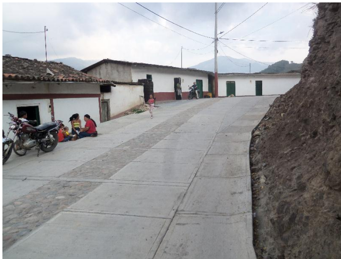
Figura 21. Obra terminada de pavimentación del barrio la parrilla.
