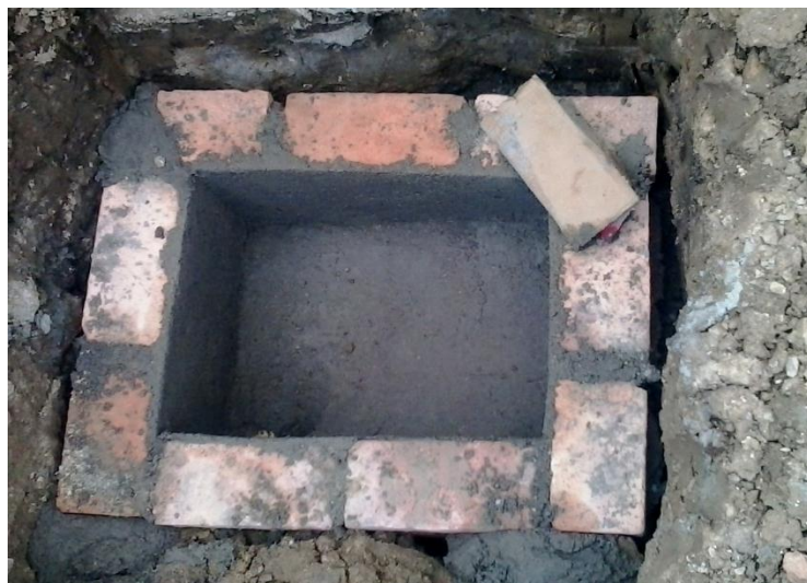
Figura 12. Construcción de cajas de inspección.
