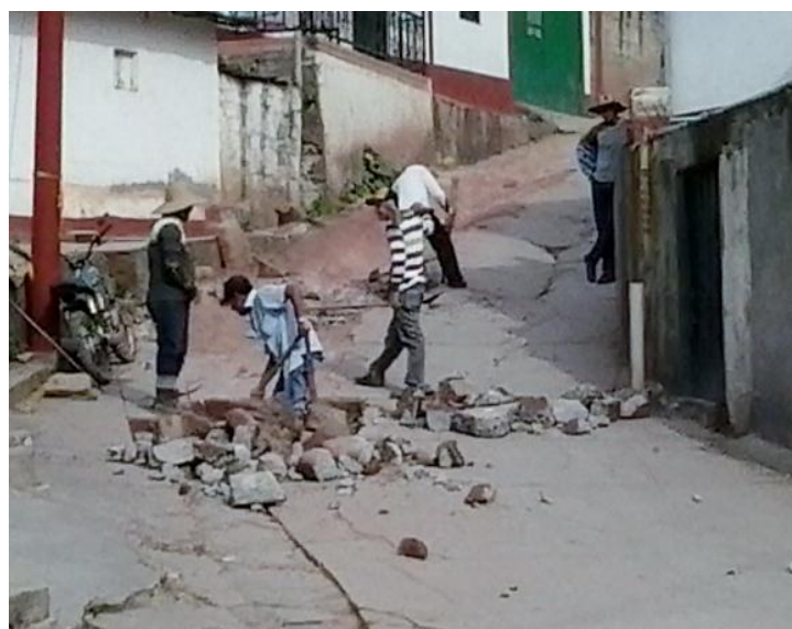
Figura 4. Demolición de pavimento rígido.
