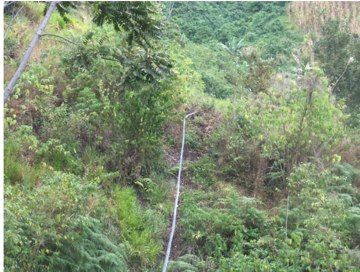
Figura 13. Tramo de la línea de aducción de la vereda la loma.
