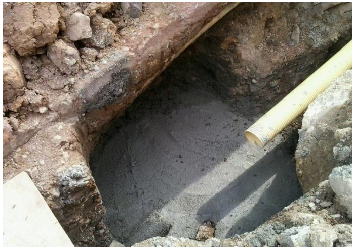
Figura 10. Base y cañuela para cámara de inspección.
