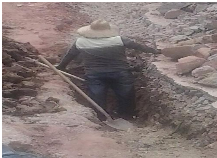
Figura 6. Excavación manual.
