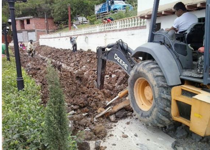
Figura 7. Excavación mecánica.
