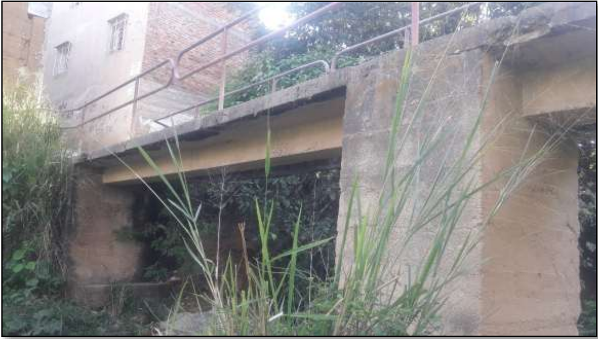
Figura 20. Subestructura del puente Maciegas. Fuente: Autor de la pasantía.
