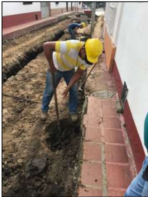
Figura 9. Excavación manual para cajas de inspección. Fuente: Autor de la pasantía.
