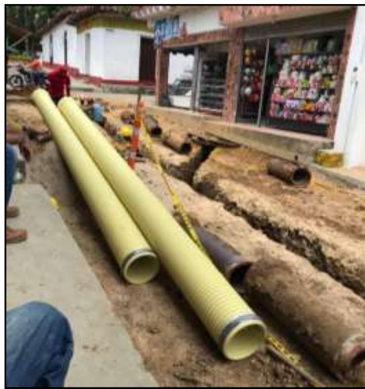
Figura 10. Instalación de tubería PVC para alcantarillado. Fuente: Autor de la pasantía.
