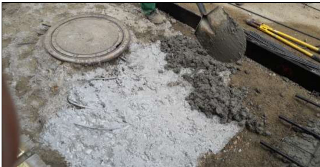
Figura 11. Aplicación de sikadur para adherir el concreto. Fuente: Autor de la pasantía.
