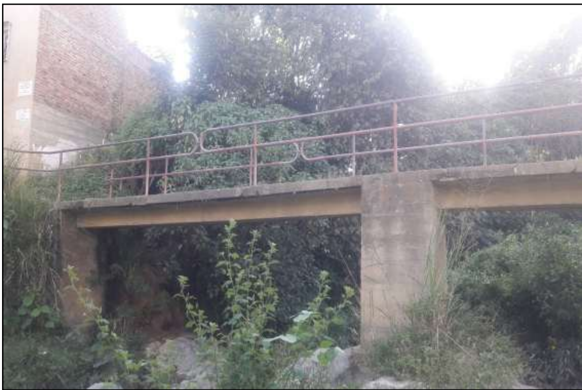
Figura 17. Vista general del puente Maciegas. Fuente: Autor de la pasantía.
