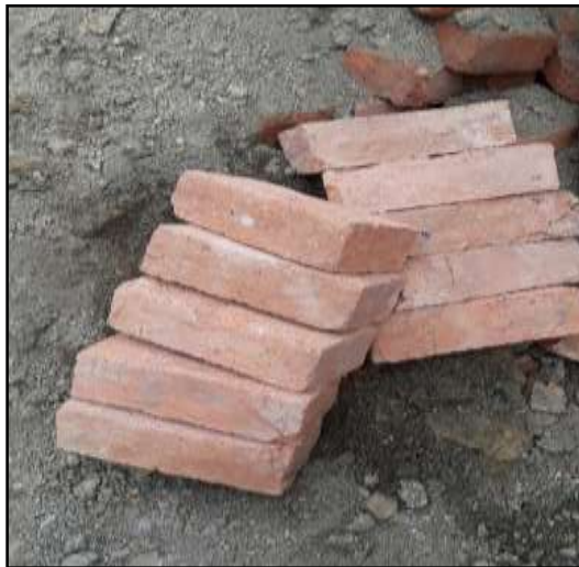
Figura 4. Mampostería en ladrillo empleado en obra. Fuente: Autor de la pasantía.
