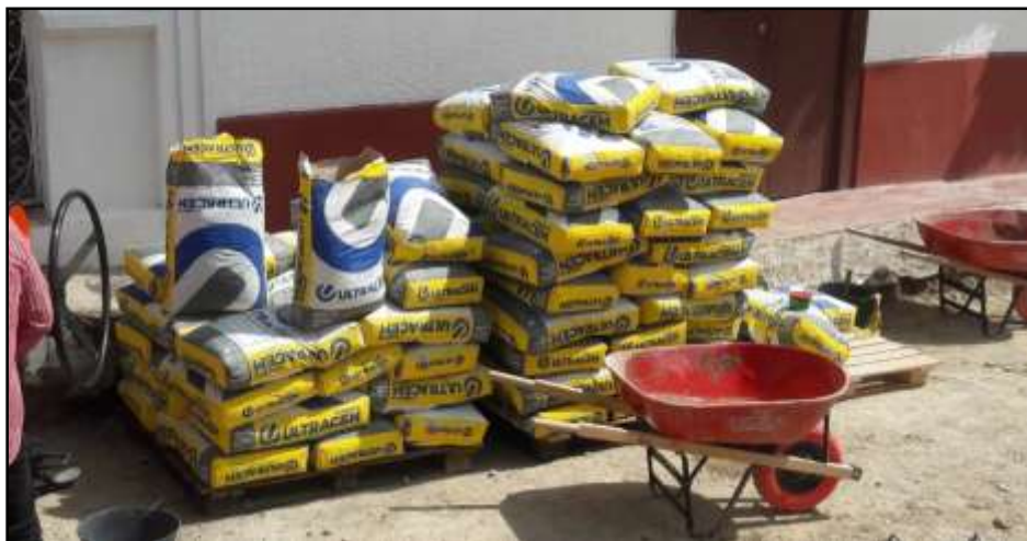
Figura 2. Almacenamiento de los bultos de cemento. Fuente: Autor de la pasantía.
