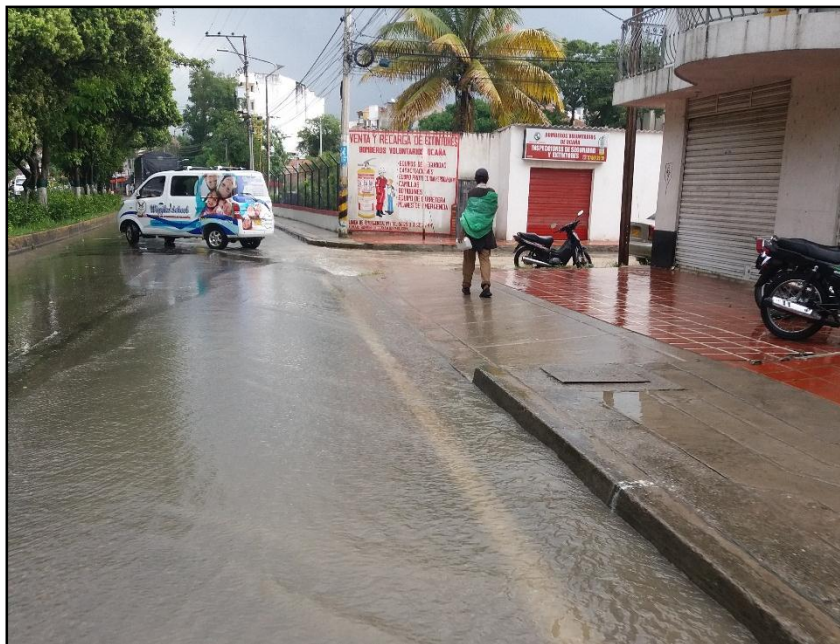
Figura 7. Estado del tramo de vía en estudio durante precipitaciones de poca magnitud. Fuente: Autores del proyecto.
