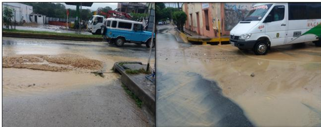
Figura 10. Rejilla taponada por sedimentos sólidos. Fuente: Autores del proyecto.
