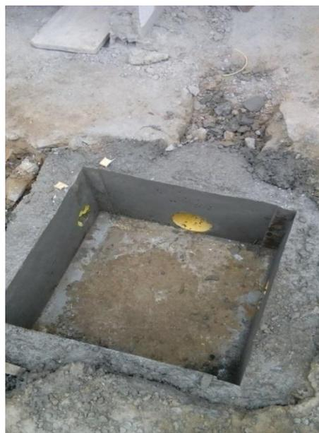
Figura 85. Caja de inspección
