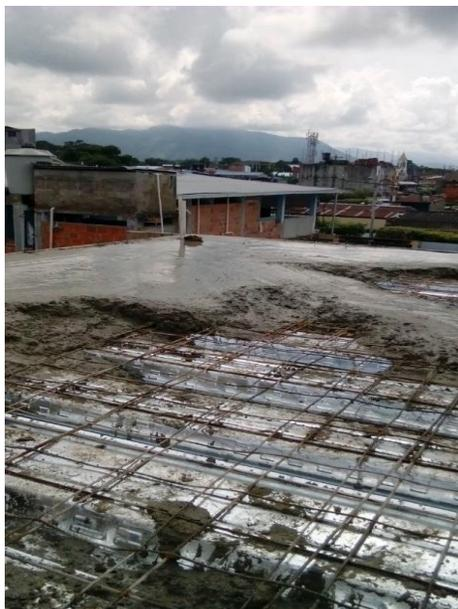
Figura 70. Concreto para placa
