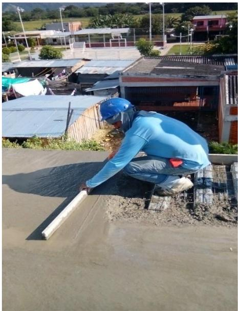
Figura 74. Concreto para placa
