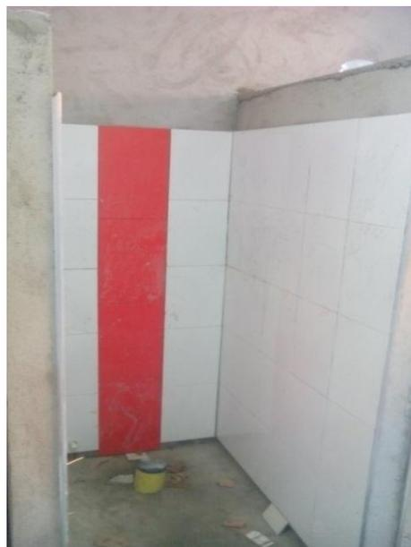
Figura 97. Enchape de muros
