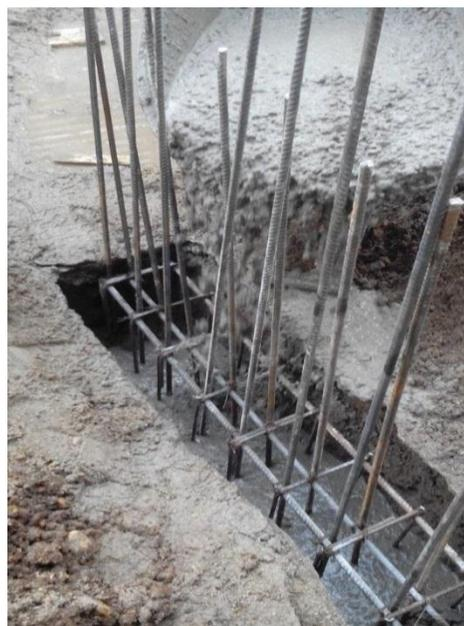
Figura 59. Vaciado de cemento para rampa
