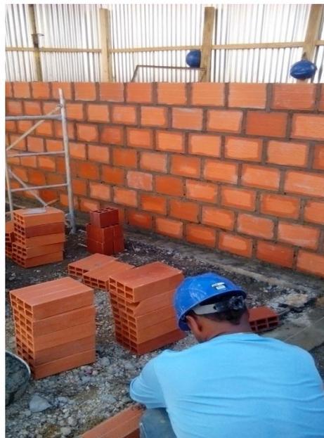
Figura 57. Levantamiento de muros
