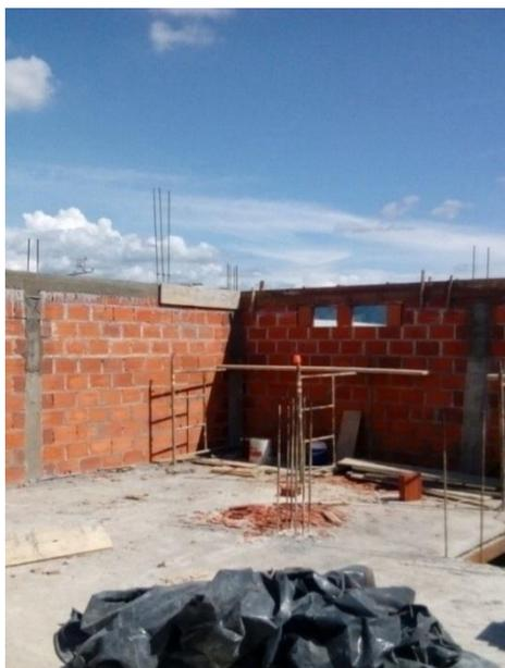
Figura 58. Viga sobre muro
