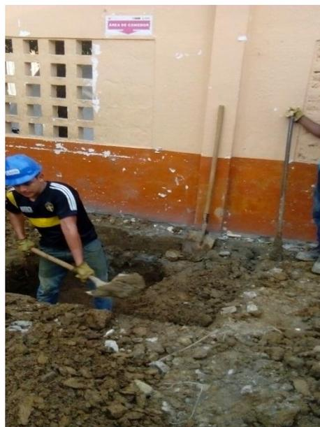
Figura 23. Excavacion de Zapatas
