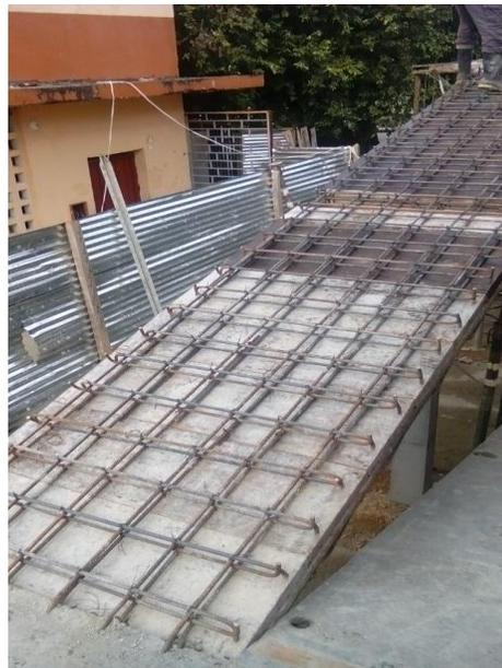
Figura 77. Vaciado de concreto de rampa
