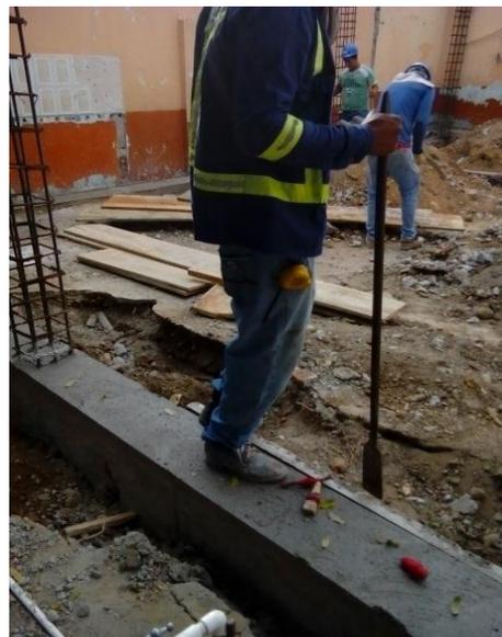
Figura 15. Vaciado de vigas (S. VillaFanny)
