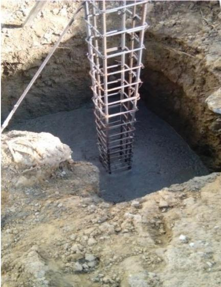
Figura 28. Vaciado de Zapatas
