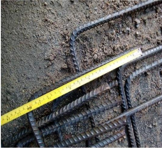
Figura 144. Verificación de longitud de gancho.
