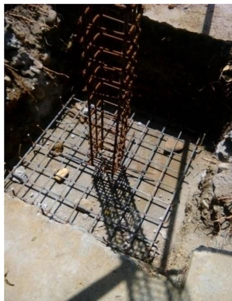
Figura 9. Armado de parrillas y estructuras de columnas (S. villa Fanny)
