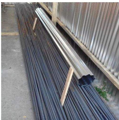
Figura 142. Almacenamiento de acero de refuerzo
