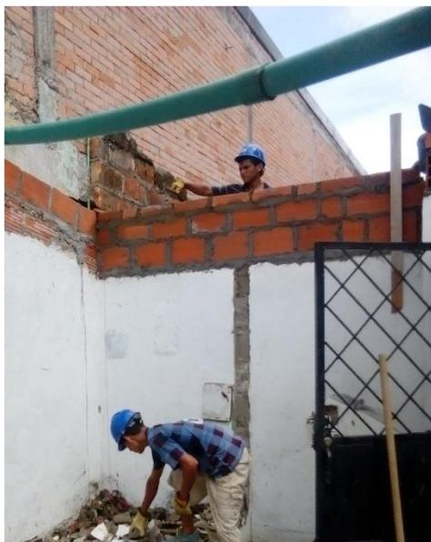
Figura 12. Levantamiento de muro
