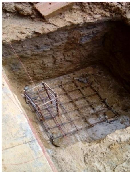
Figura 35. Cimiento estructura metálica
