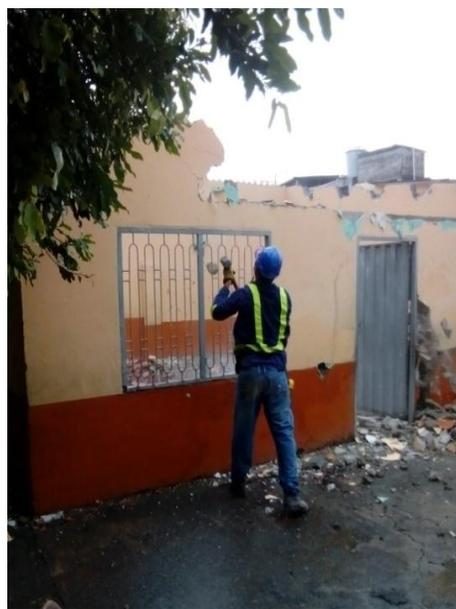
Figura 3. Demolicion manual de muros.
