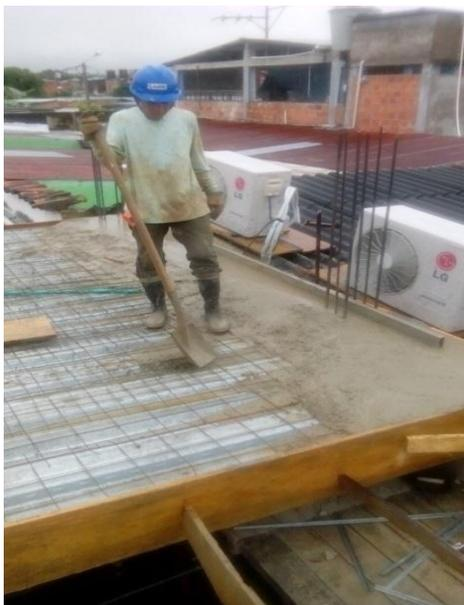
Figura 36. Concreto para placa aligerada
