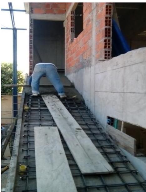
Figura 88. Concreto para rampa
