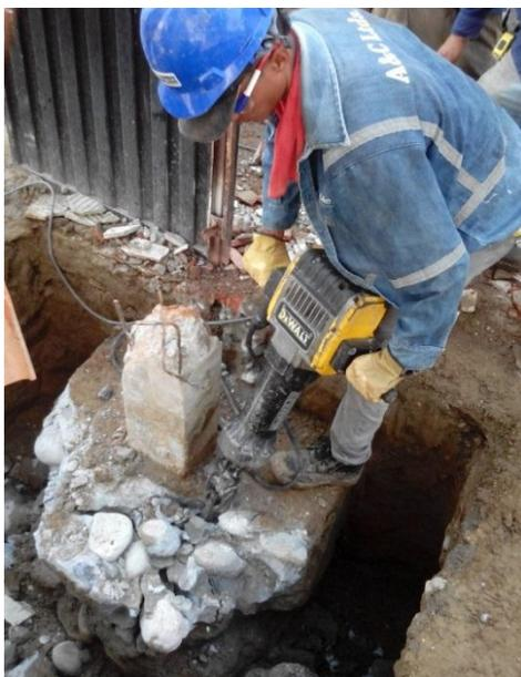
Figura 22. Demolición de Ciclópeo
