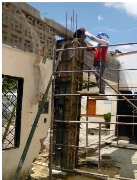
Figura 27. Vaciado de columnas
