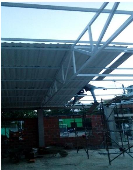
Figura 44. Cubierta metálica teja termoacustica
