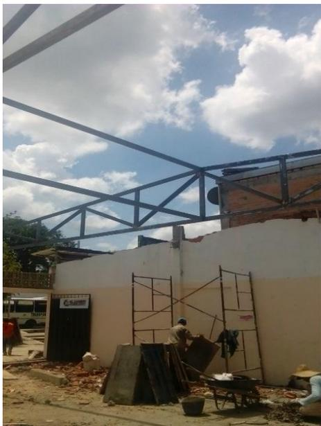
Figura 32. Cercha metálica para cubierta
