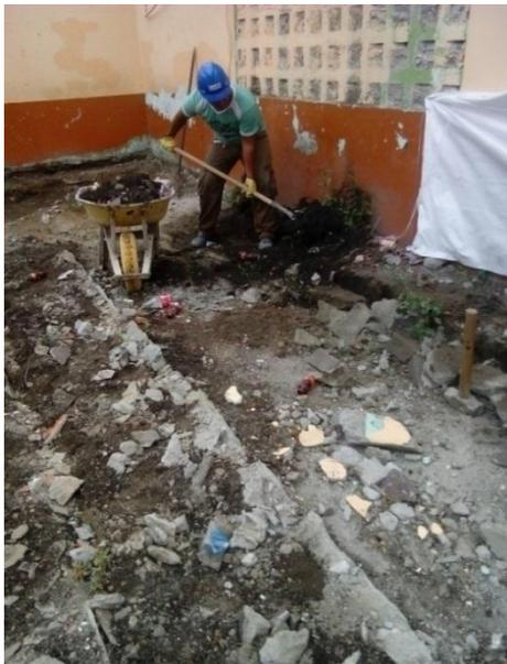
Figura 4. Demolición manual de piso
