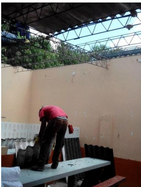
Figura 2. Desmonte manual de cubierta A.C.
