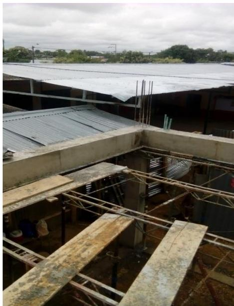
Figura 51. Vaciado en concreto de viga
