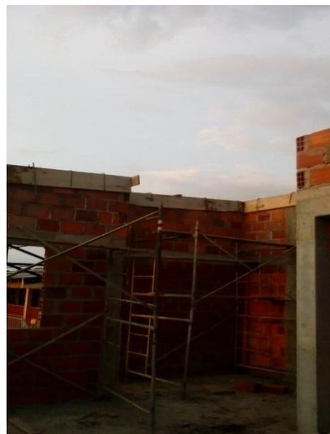
Figura 79. Viga sobre muro
