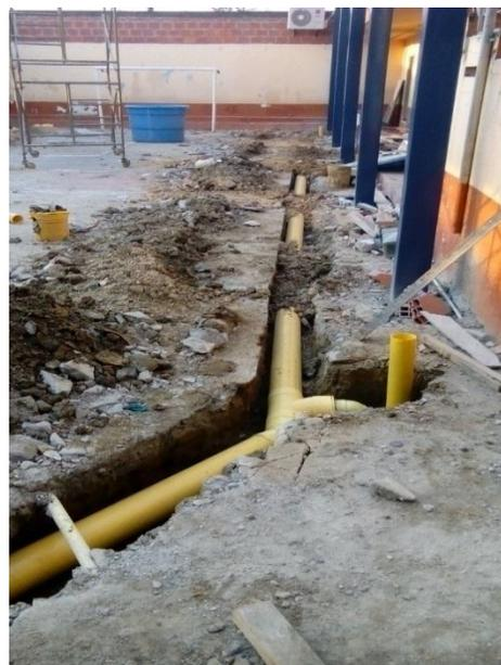
Figura 81. Inst. desague agua lluvias
