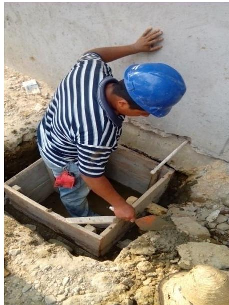
Figura 101. Caja de inspeccion
