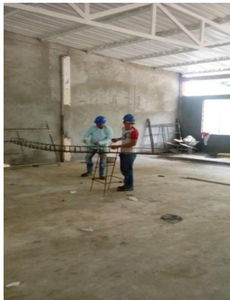
Figura 49. Figurado de vigas Aereas
