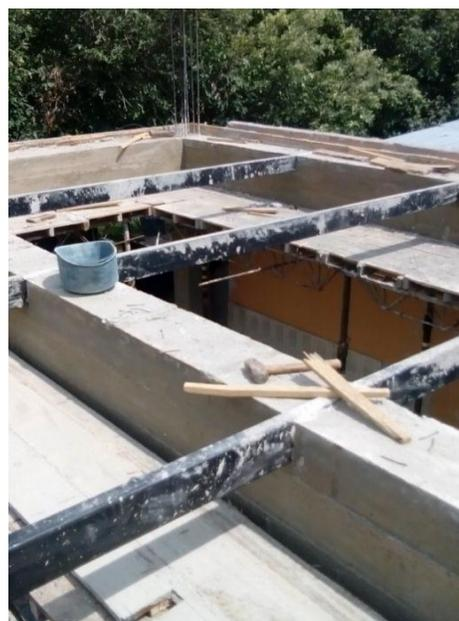
Figura 31. Vaciado de vigas aereas
