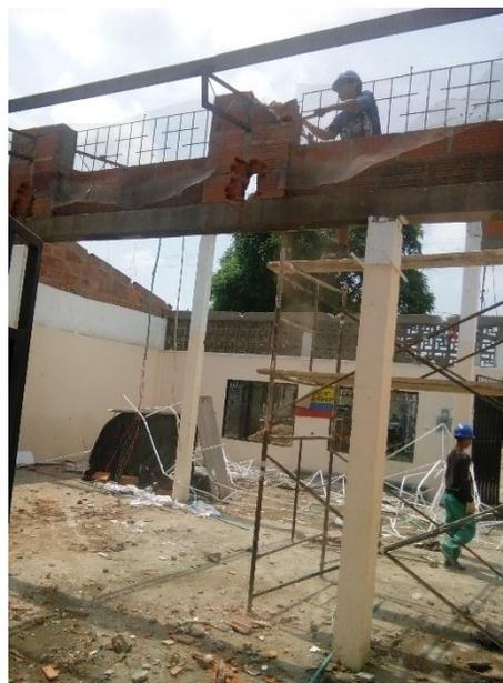
Figura 17. Demolicion de vigas y columnas
