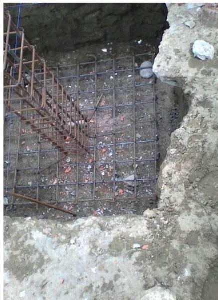
Figura 25. Figurado de parillas y columnas
