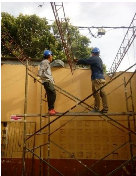
Figura 18. Desmonte de Cubierta A.C
