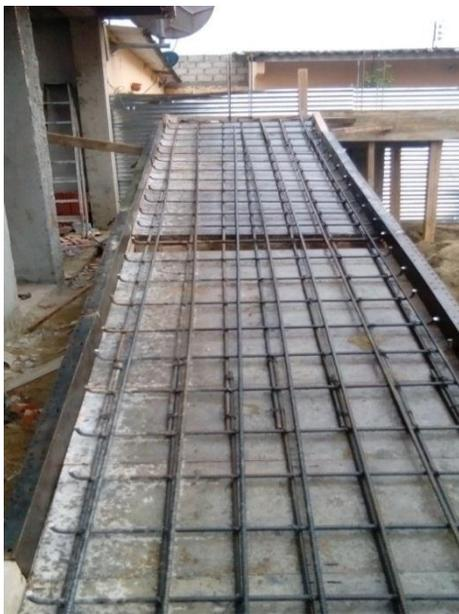
Figura 64. Figurado y armado de rampa
