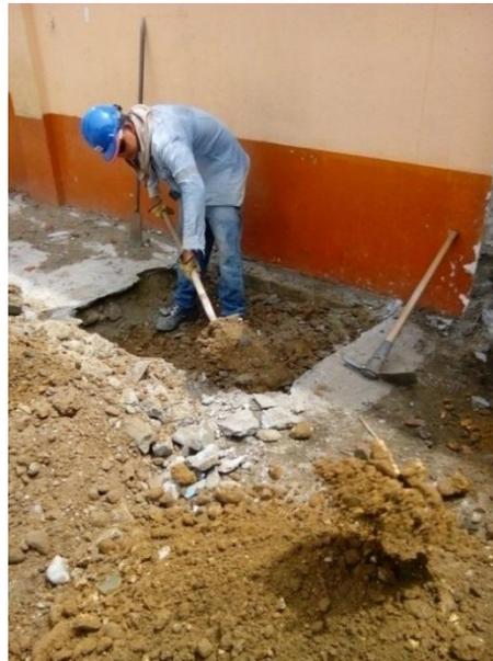
Figura 5. Excavación de manual zapatas
