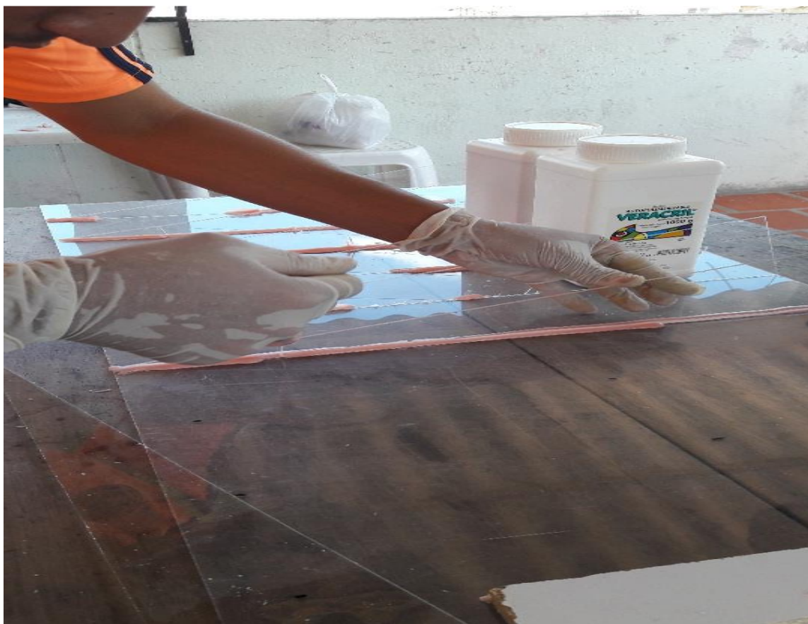
Figura 18. Montaje de secciones de canal Etapa Inicial Séptimo Paso Nota fuente: Autores del proyecto
