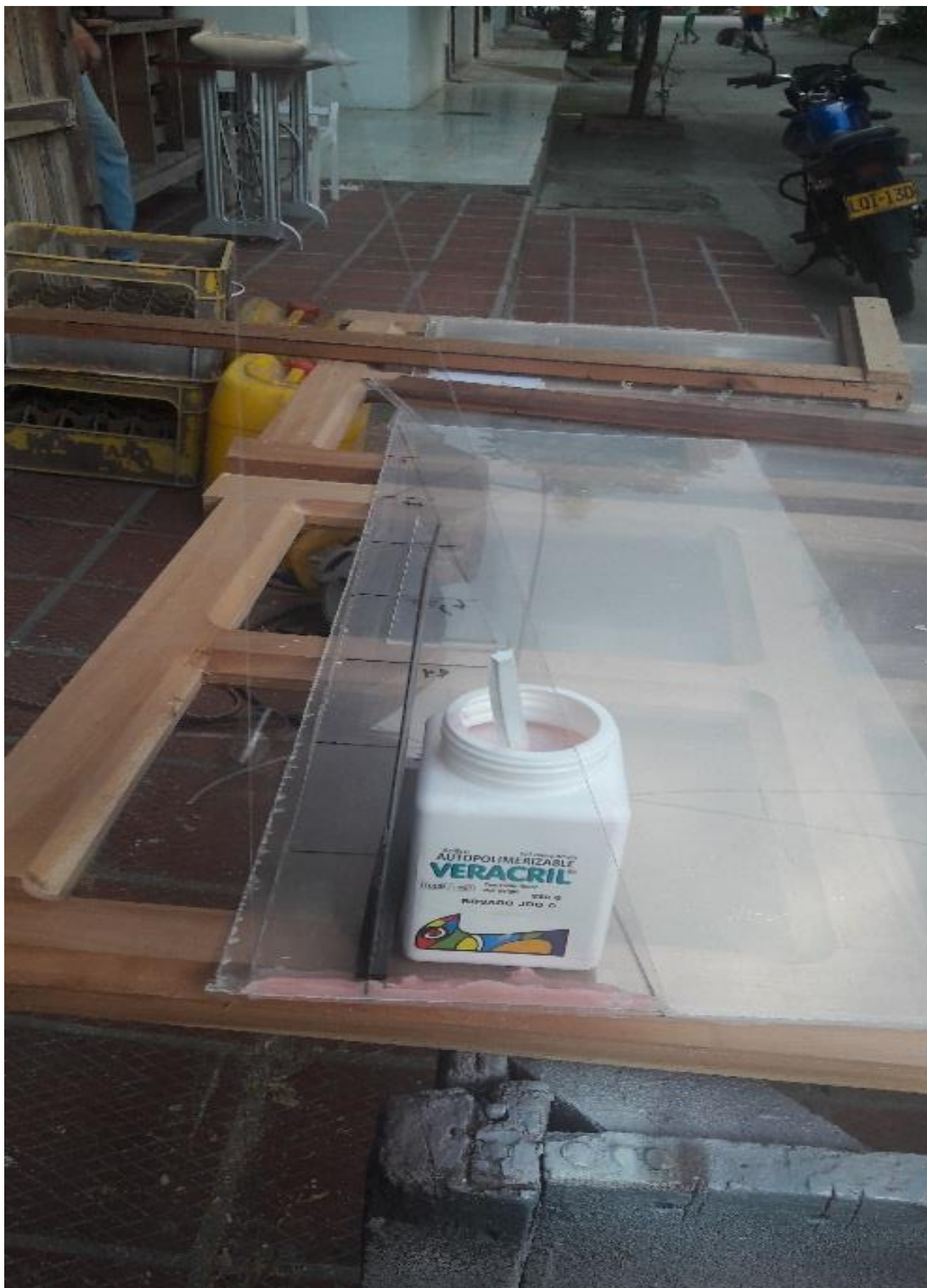
Figura 12. Montaje de secciones de canal Etapa Inicial Nota fuente: Autores del proyecto
