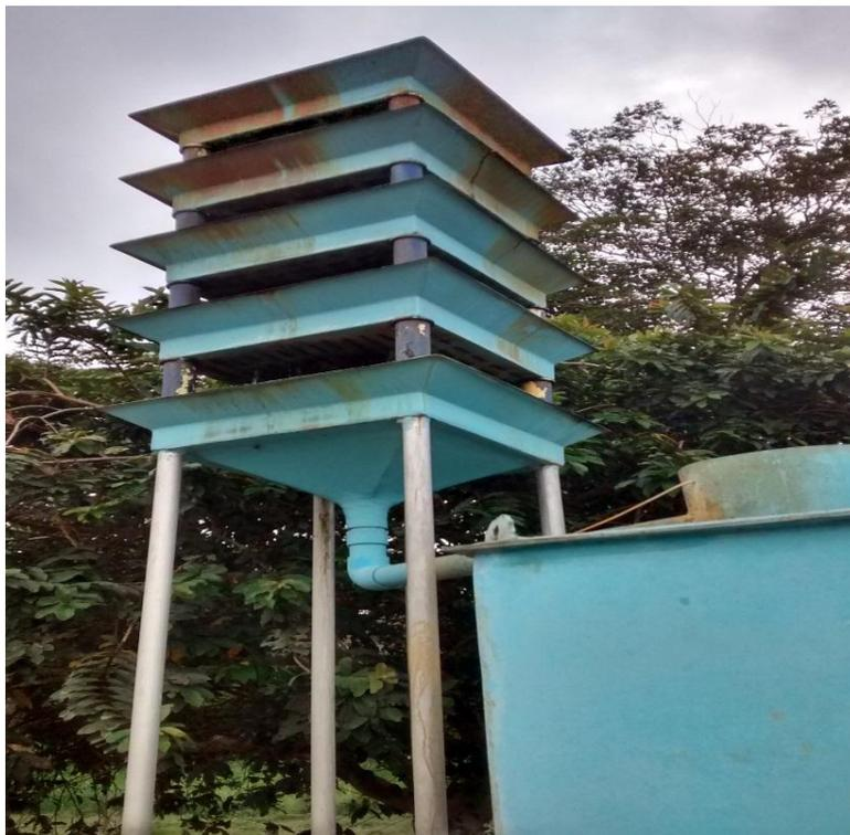
Figura 5. Torre de aireación.
