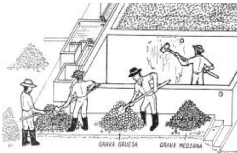
Figura 10. Retiro y lavado de gravas y paredes filtros.
