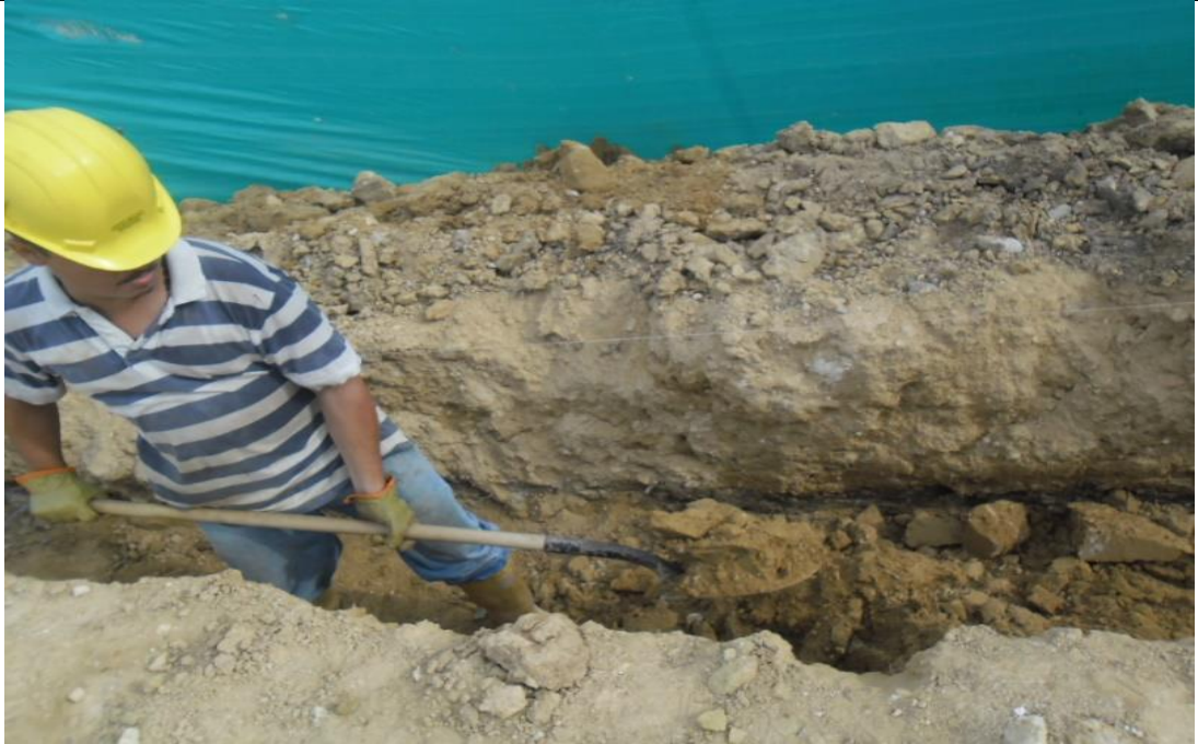
Foto 23. Excavación manual para cimientos.
