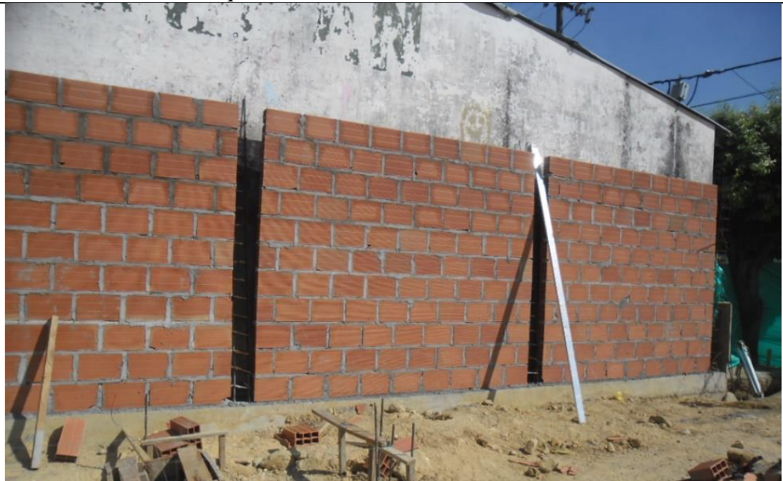
Foto 10. Levante en bloque de arcilla H-10.
