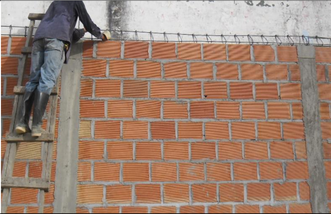
Foto 15 . Columnetas en concreto de 3000 psi de 0,12*0,20 mts Incluye acero.
