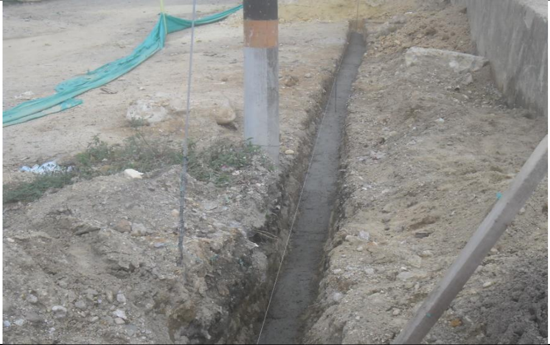
Foto 9 . Solado en concreto de 2000 PSI de 0.3x0.1m.
