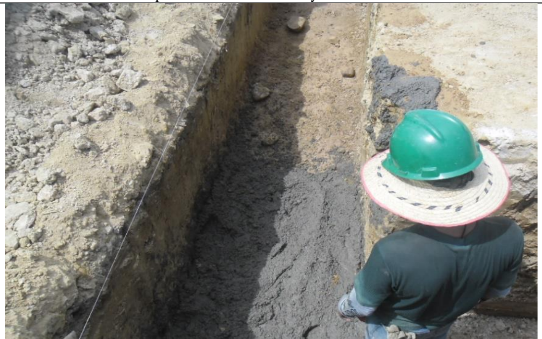
Foto 24. Cimiento ciclopeo 60% concreto 1:2:3 y 40% Piedra
