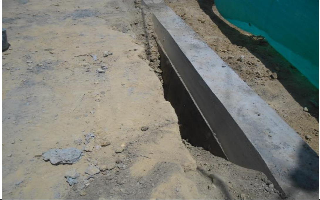
Foto 17. Muro en concreto ciclópeo 60% concreto, 40% piedra.
