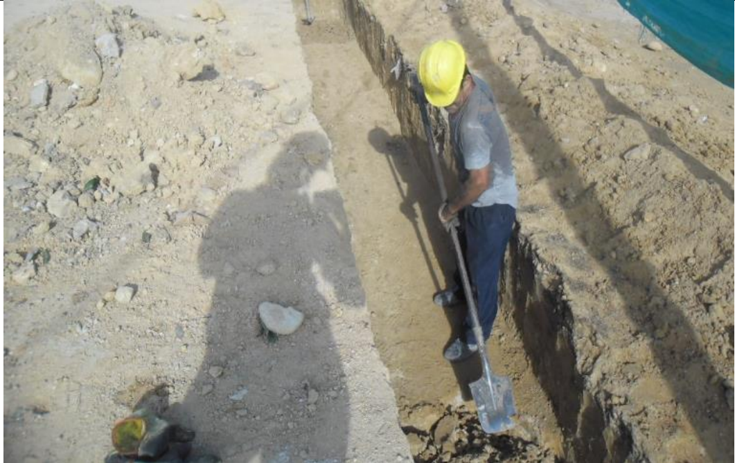
Foto 1. Excavación manual para cimientos de 0,40*0,50 m.
