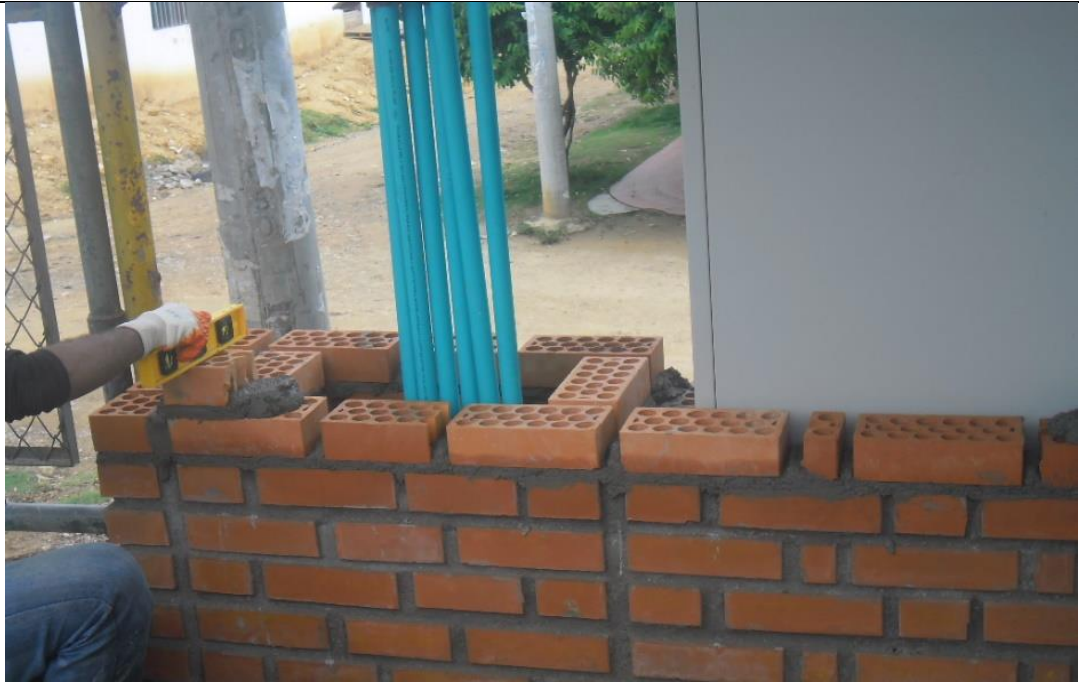
Foto 11. Levante en ladrillo a la vista
