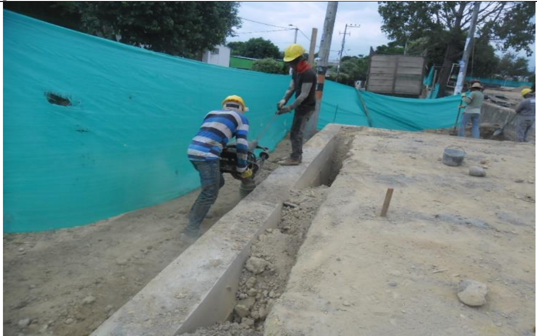
Foto 18. Relleno y compactación mat. seleccionado para exteriores y senderos peat.
