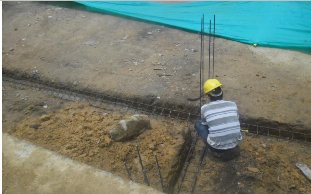
Foto 14 Columnas en concreto de 3000 psi de 0,20*0,20 mts Incluye acero
