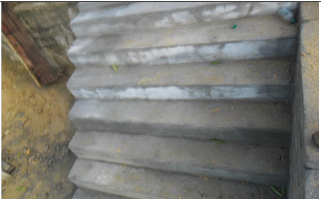
Foto 12. Escaleras de acceso inc. Acero
