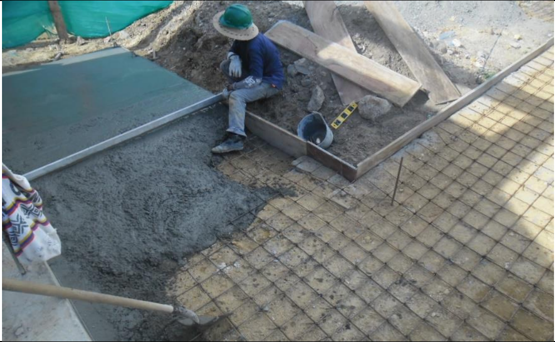
Foto 13. Rampa de concreto astriado - acceso para discapacitados inc. Acero
