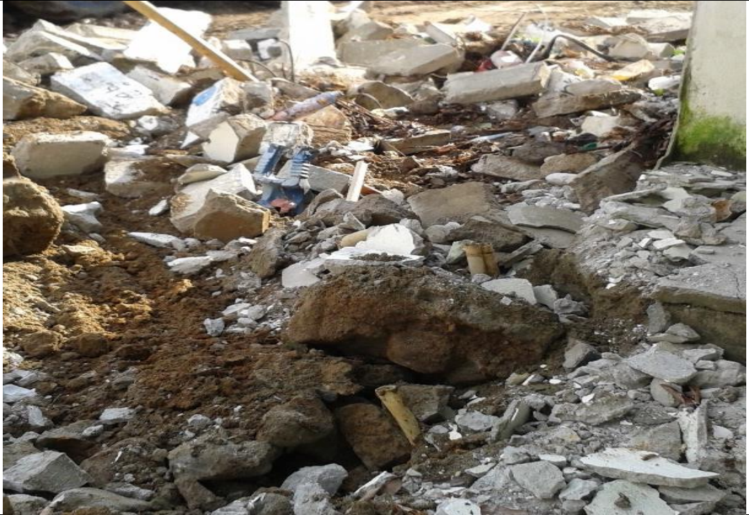
Foto 21. Retiro de escombros.
