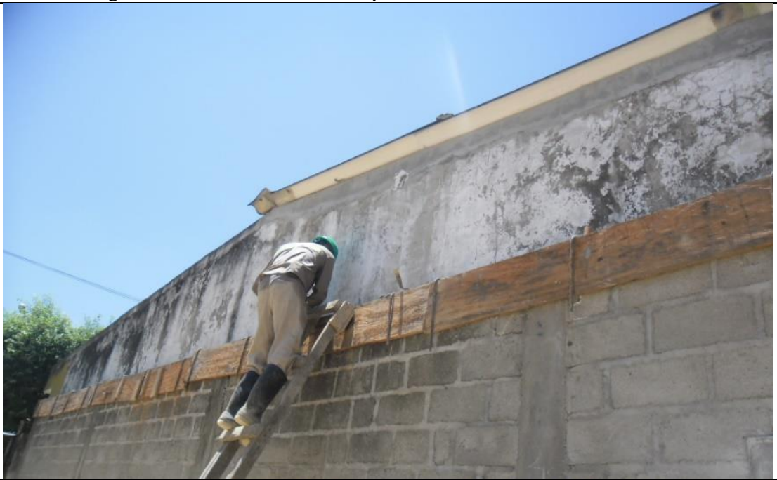
Foto 16. Viga cinta en concreto de 3000 psi de 0,12*0,20 mts Incl. Acero
