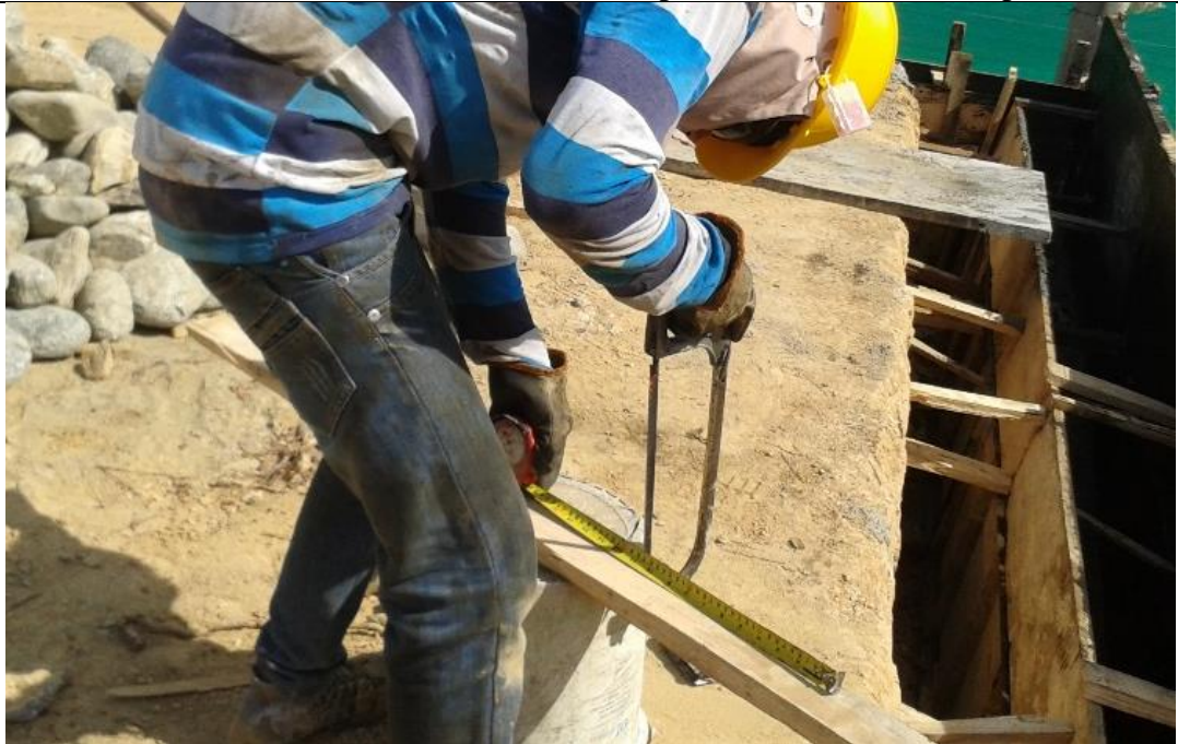
Foto 2. Cimiento (0,40*0,40) en concreto ciclopeo 60% concreto, 40% piedra
