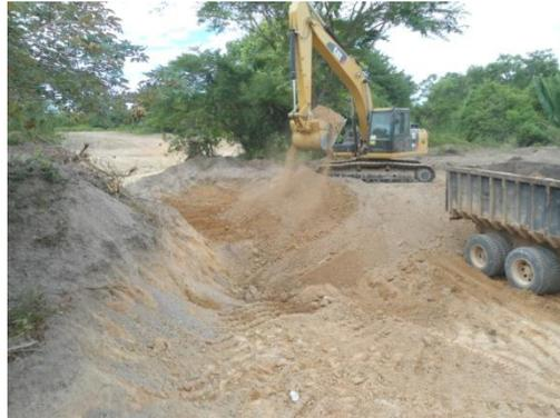
En el tajo 2 el material explotado es una grava mal gradada con limos, el espesor del estrato es bastante grande, así que se aprovecha en lo posible, este material es usado para la sub-base estabilizada con cemento.
