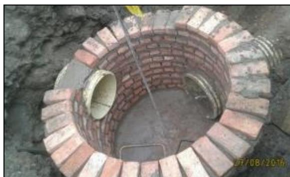
**5.3 Construcción de Cámara de Inspección TIPO IIB en concreto 28 MPa,  $h > 3.00\text{m}$ , diámetro interno de 1.20 m; incluye base y cañuela en cono de 0.80 m, cuello y tapa HD, incluye llave de seguridad**
