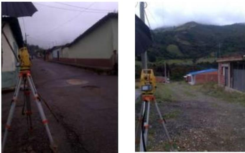
**Figura 8** Levantamiento topográfico sobre el trazado de diseño
