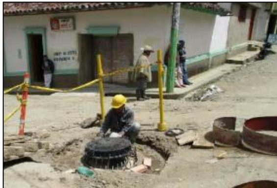
**5.4 Construcción de Cámara de Inspección TIPO IIB en concreto 28 MPa,  $2.00 < h < 3.00\text{m}$ , diámetro interno de 1.50 m; incluye base y cañuela en cono de 0.80 m, cuello y tapa HD, incluye llave de seguridad**
