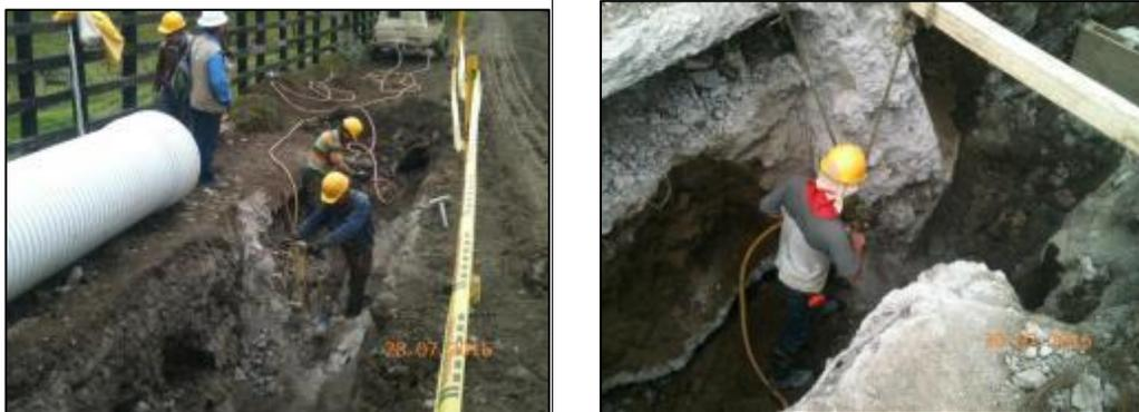
Figura 36 Demolición del box culver
