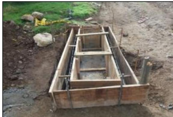
**6.2 CONSTRUCCIÓN DE SUMIDERO TIPO II-SR PARA AGUAS LLUVIAS (un),** Base y muros  $e= 0,15$  m., en Concreto 28.0 MPa; incluye rejilla en platina 2 1/2" x 3/8", marco y contra marco en ángulo de 2 1/2" x 2 1/2" x 3/8", bisagras y cámara de recolección,  $2m < longitud < 4$  m
