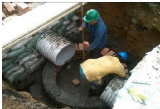
**5.2 Construcción de Cámara de Inspección TIPO IIA en ladrillo  $2.00 < h < 3.00\text{m}$ , diámetro interno de 1.20 m; incluye base y cañuela en cono de 0.80 m, mortero 1:2, cuello y tapa HD, incluye llave de seguridad**
