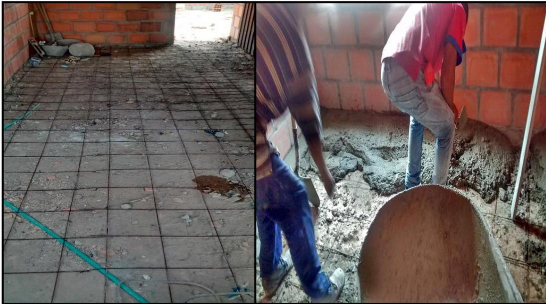
*Figura 10.* Colocación plantilla reforzada
