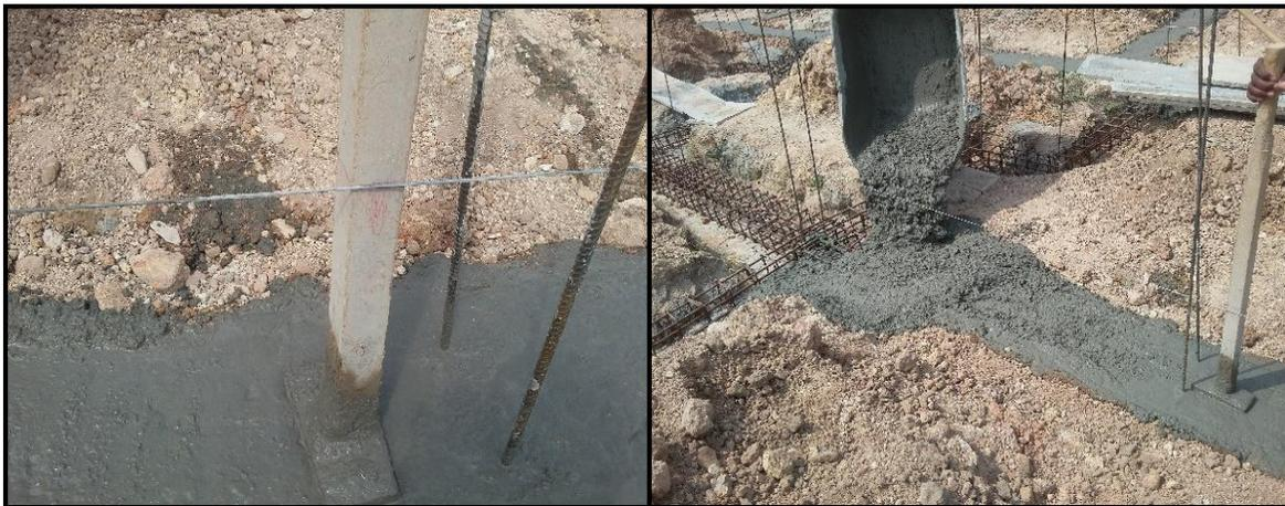
*Figura 8.* Nivel vigas de cimentación.
