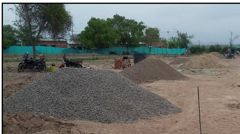
*Figura 24.* Acopio de material de río para pavimento.
