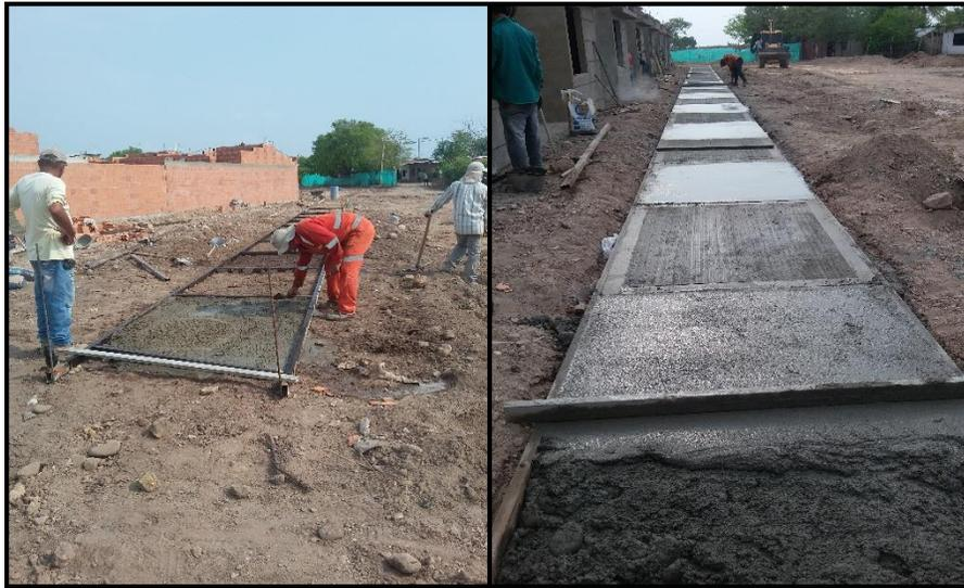
*Figura 14.* Colocación de formaletas y fundido de andenes
