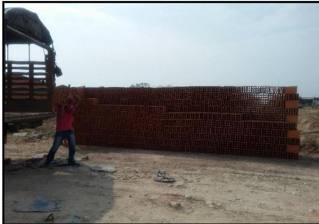
*Figura 22 Acopio de ladrillos H-10*
