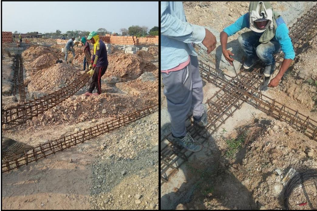
*Figura 7.* Acero de vigas de cimentación.
