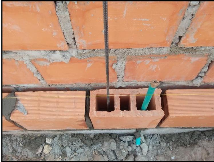
*Figura 9.* Colocación acero de refuerzo y tubos conduit mampostería reforzada.
