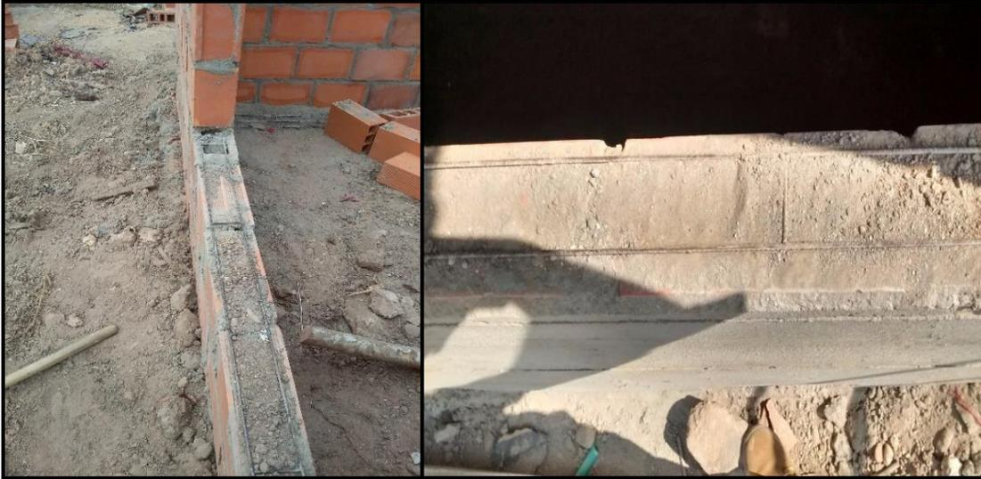
*Figura 11.* Acero de refuerzo horizontal.
