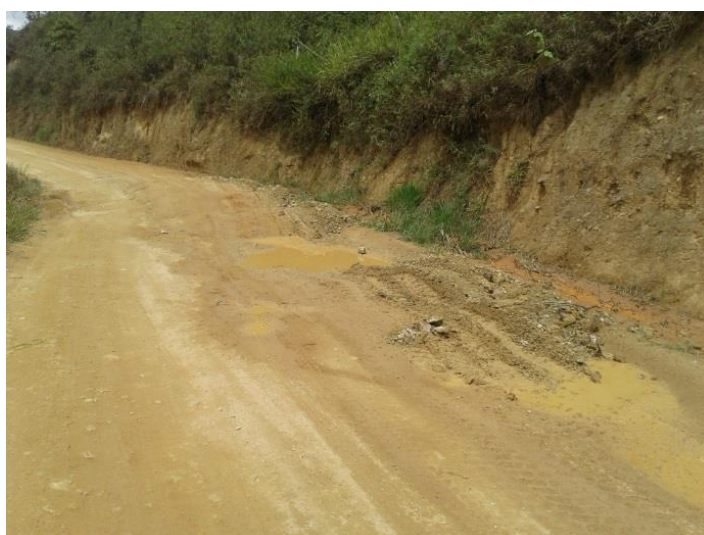
Figura 63. Presencia de fango en época de lluvias. Nota fuente: Autores del proyecto, 2017.
