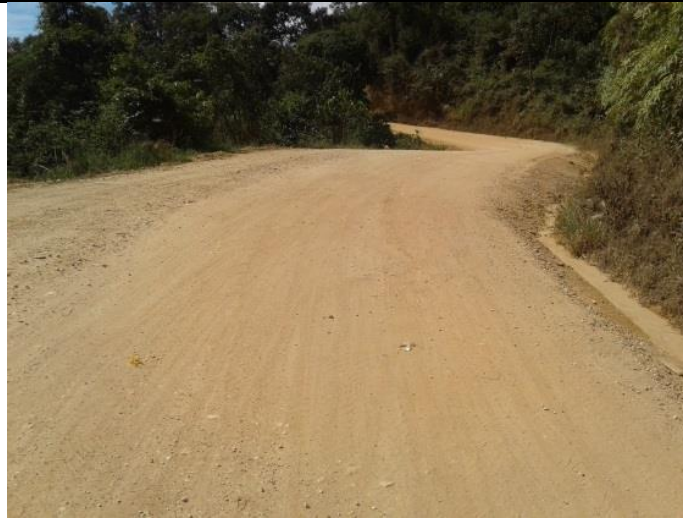
Figura 49. Ausencia señalización curva y contra-curva pronunciada primera a la derecha.
