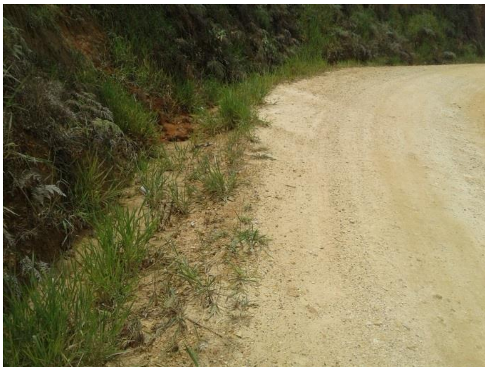
Figura 20. Cuneta con presencia de Vegetación (Tramo: PR22+200-PR22+250) Nota fuente: Autores del proyecto, 2017.
