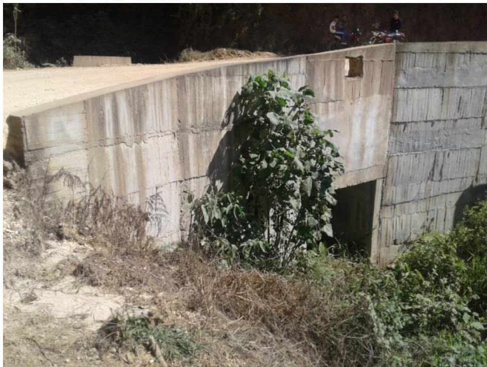
Figura 27. Box Culvert (salida lateral del agua). PR19+605 Nota fuente: Autores, 2017.
