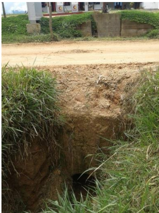
Figura 26. Alcantarilla en buen estado. PR21+780 Nota fuente: Autores, 2017.
