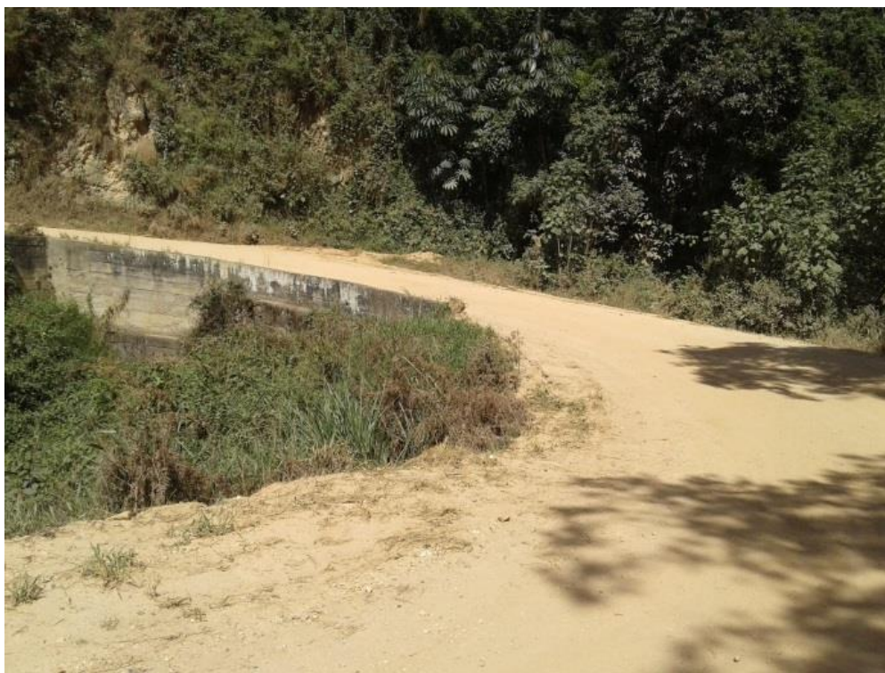
Figura 33. Muro de contención; Con alcantarilla (PR20+600). Nota fuente: Autores del proyecto, 2017.
