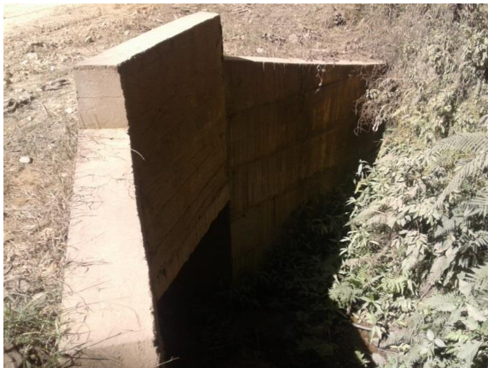
Figura 28. Box Culvert (entrada lateral del agua). PR19+605 Nota fuente: Autores, 2017.
