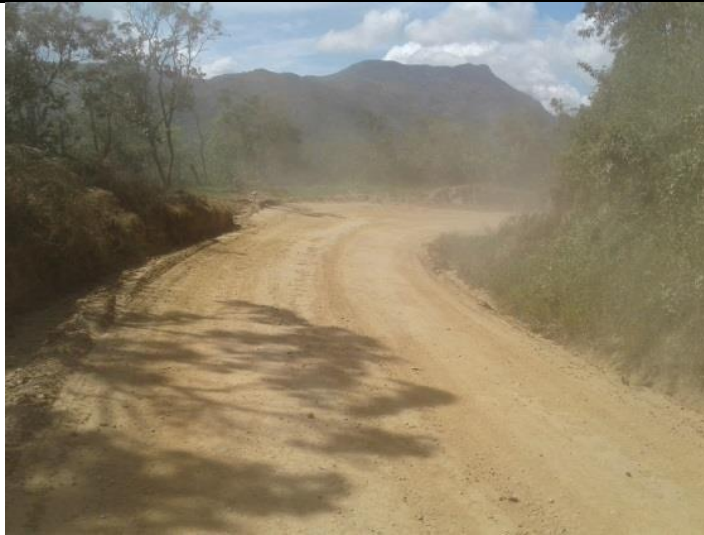
Figura 45. Ausencia de señalización, curva cerrada a la derecha. Nota fuente: Autores del proyecto, 2017.
