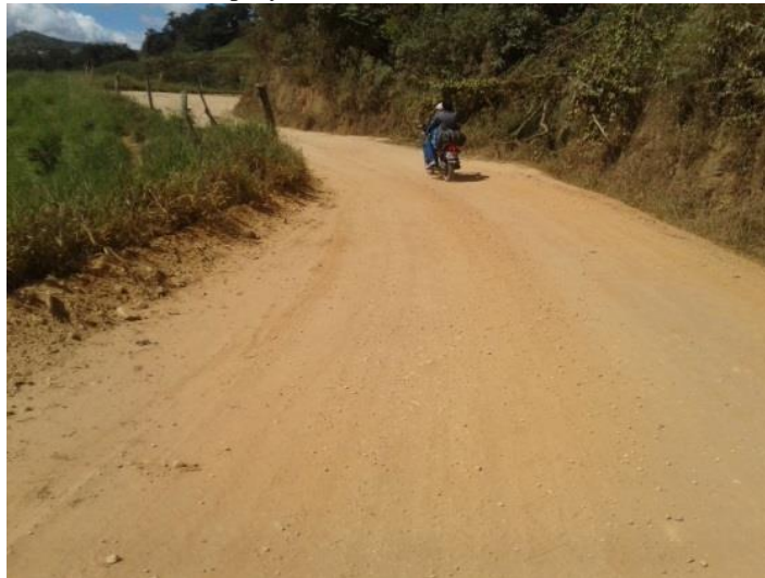
Figura 50. Ausencia señalización curva y contra-curva pronunciada primera a la izquierda.
