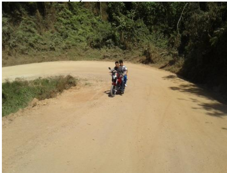
Figura 46. Ausencia señalización, curva cerrada a la izquierda PR20+350. Nota fuente: Autores del proyecto, 2017.
