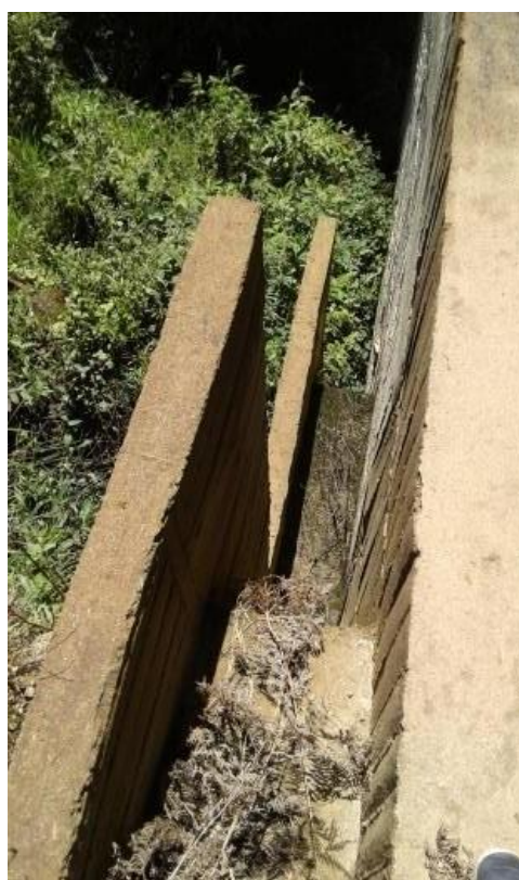
Figura 29. Box Culvert (Gradas disipadoras de energía). PR19+605 Nota fuente: Autores, 2017.
