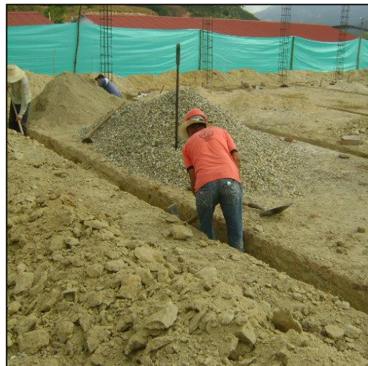
Fotografía 19. Excavación de vigas
