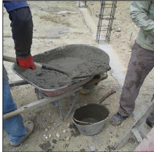
Fotografía 93. Transporte del concreto
