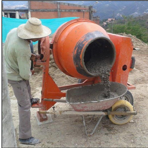
Fotografía 92. Mezcladora tipo trompo
