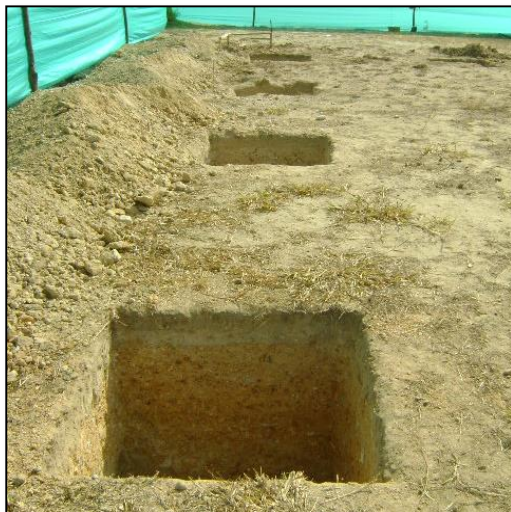
Fotografía 18. Excavación de zapatas
