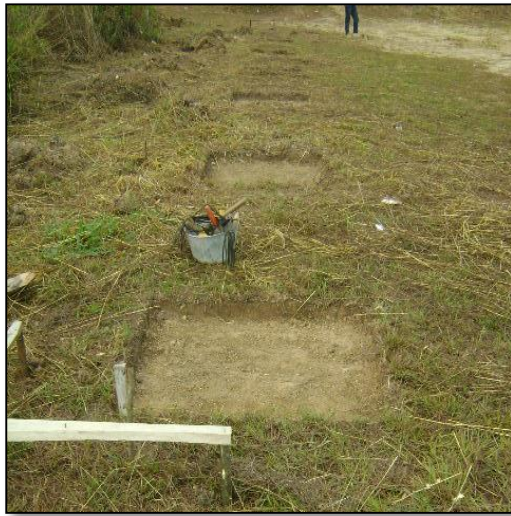
Fotografía 16. Localización y replanteo
