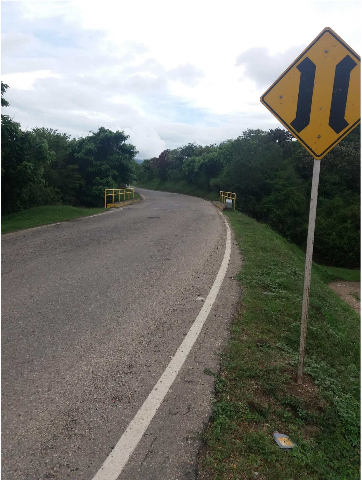
Puente guayabal PR 13+0800
