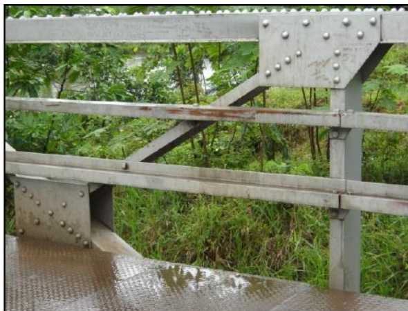
Figura 27 Conexión diagonal-montante con conectores (remaches)
