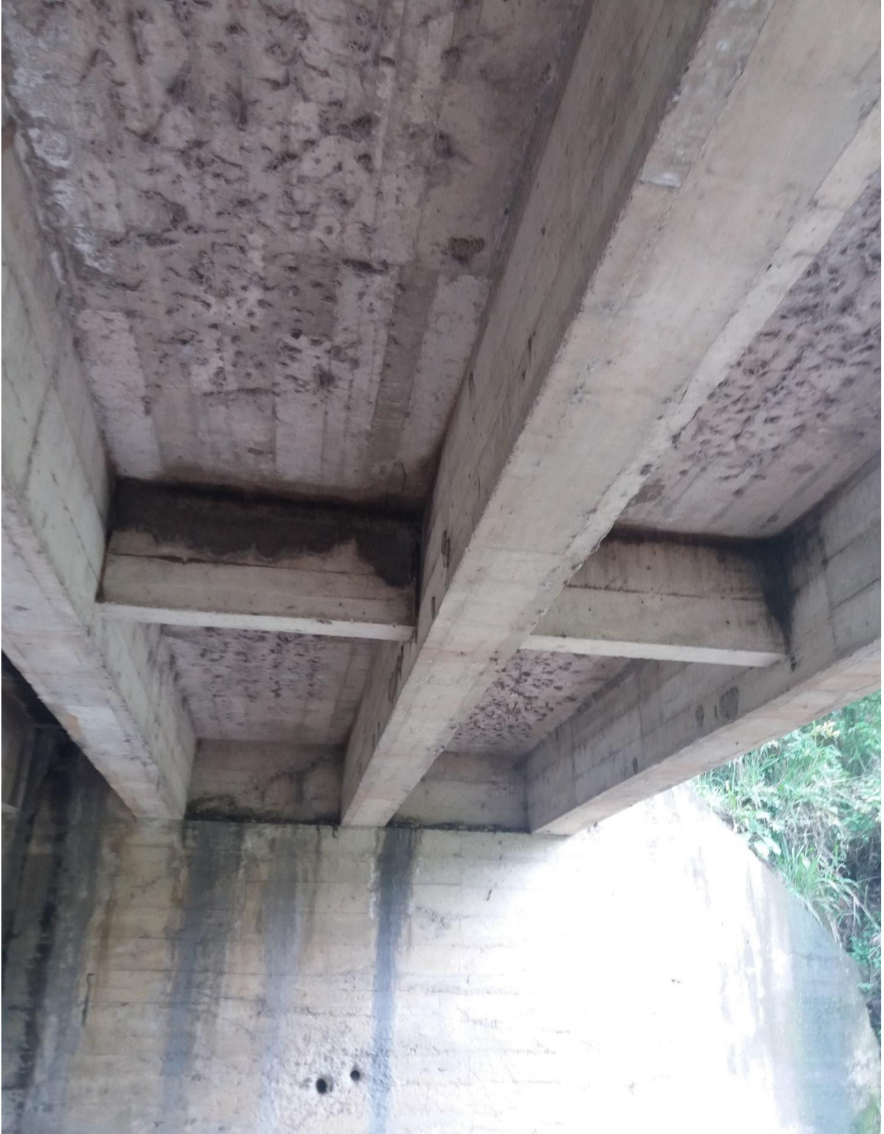
Puente guayabal PR 13+0800
