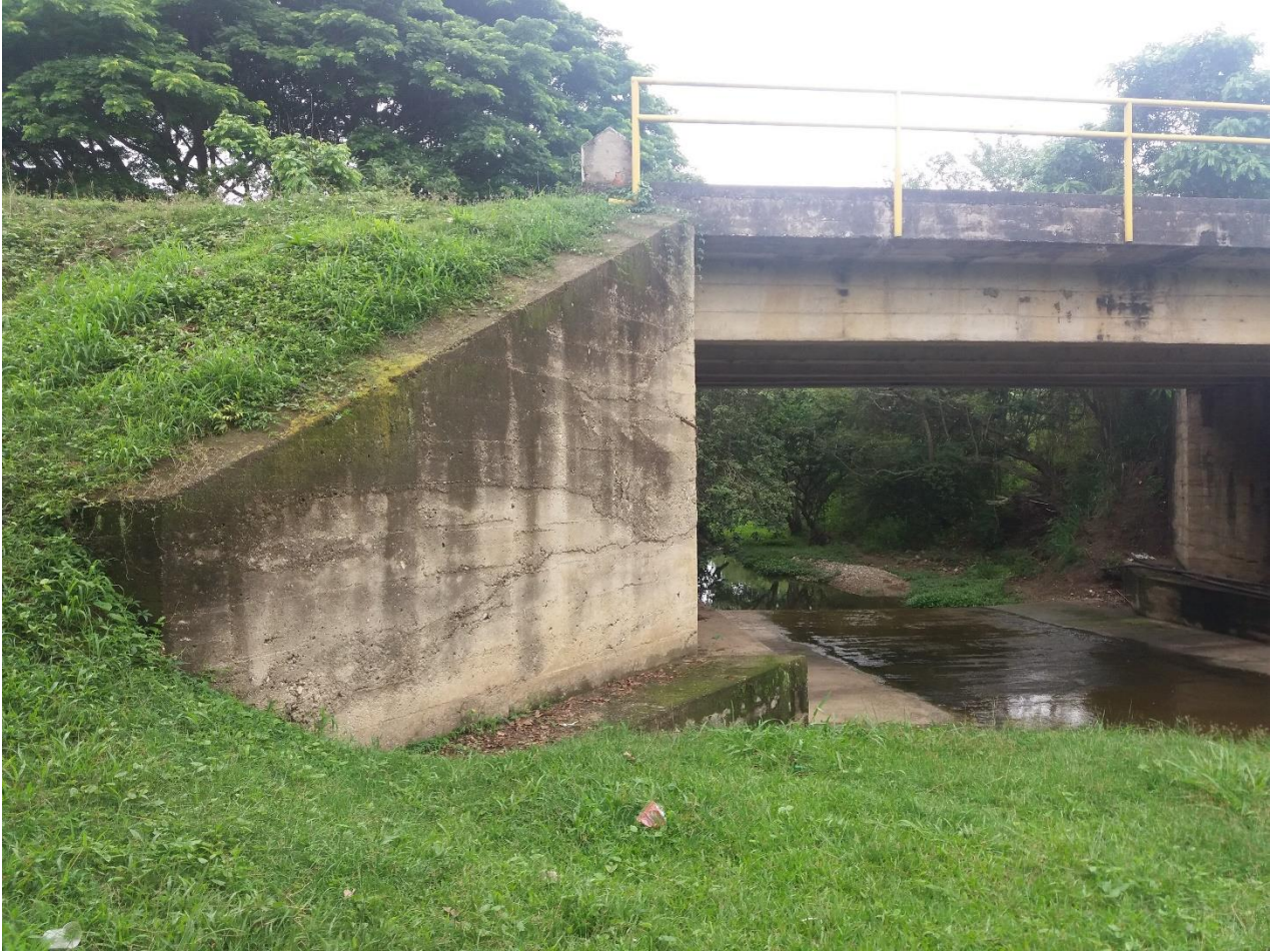
Puente guayabal PR 13+0800
