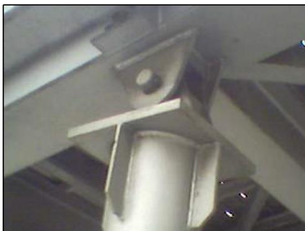
Figura 27 Conexión diagonal-montante con conectores (remaches)
