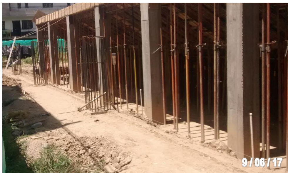
Figura 51. Enconfrado de la losa maciza de la gradería.
