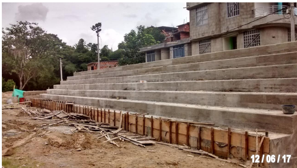
Figura 54. Desencofrado de la formaleta de los escalones de la gradería.
