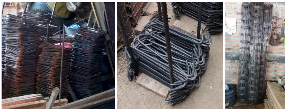
Figura 77. Condiciones de almacenamiento de estribos y malla electrosoldada.
