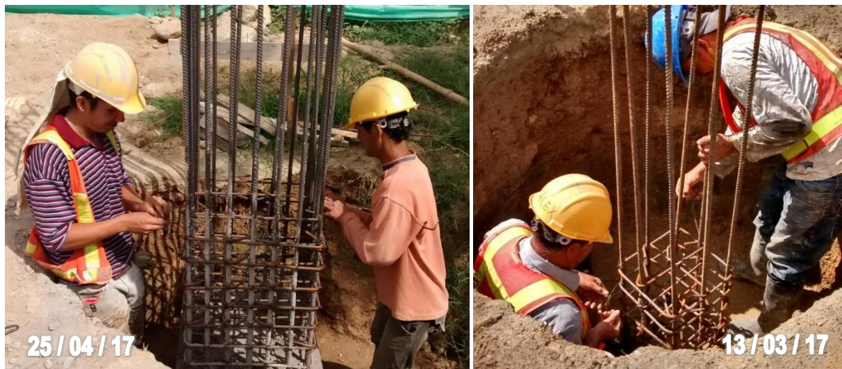
Figura 59. Colocación de estribos y grapas \frac{3}{8} '' a estructuras de refuerzo de columnas.
