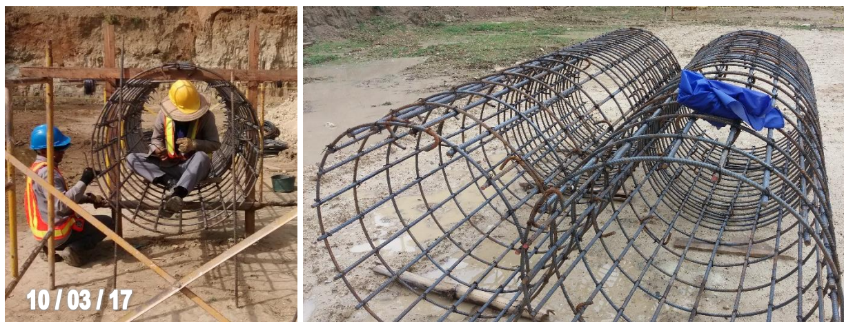
Figura 57. Armado de acero chipa 1/2'' para estructuras de refuerzo para pilas.
