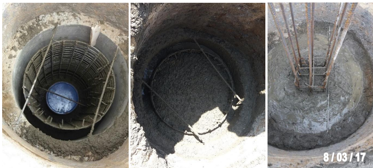
Figura 42. Etapas de la fundición de la pila en el sector de gradería.
