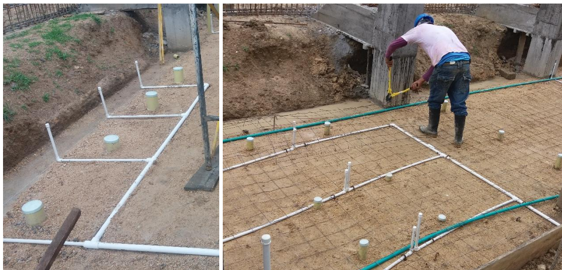
Figura 70. Colocación de tubería PVC hidráulica para el sector de duchas y camerinos.
