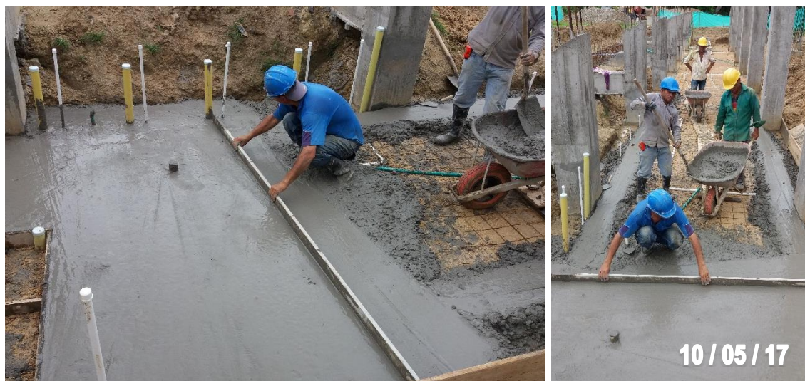
Figura 68. Fundición de placa de piso para el sector de baños.
