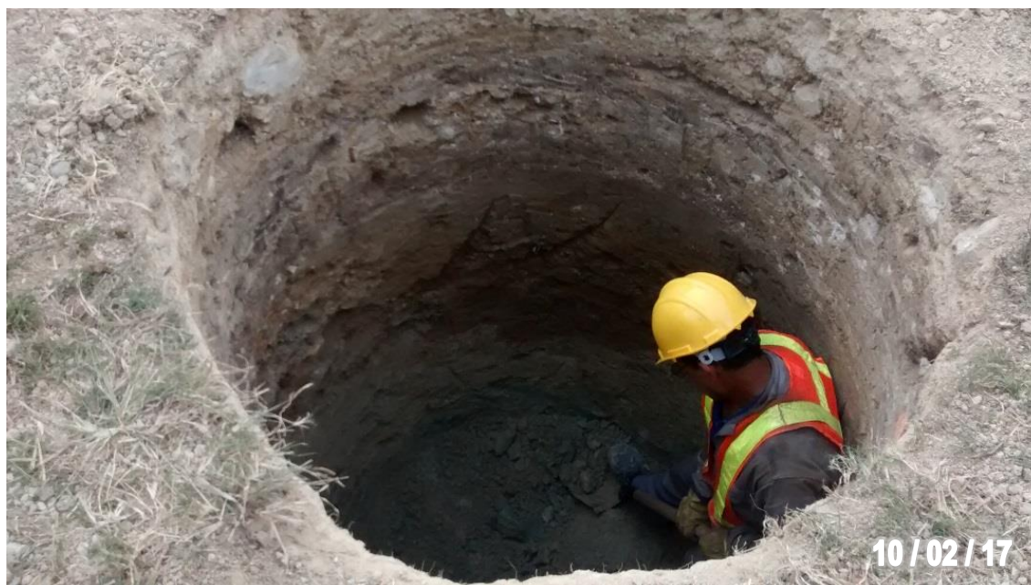
Figura 29. Excavación del primer anillo para pila del sector oriental.
