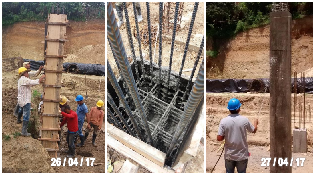
Figura 49. Fundición y curado de columna de 0.40 x 0.40 m del Eje I para gradería.
