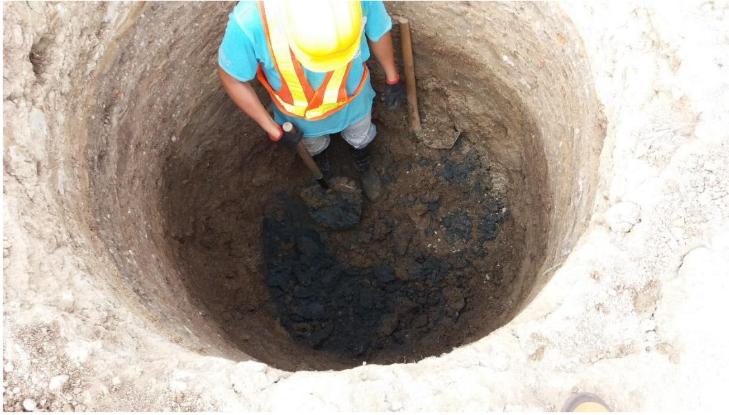
Figura 91. Dotación de mínima de seguridad para actividades de excavación.
