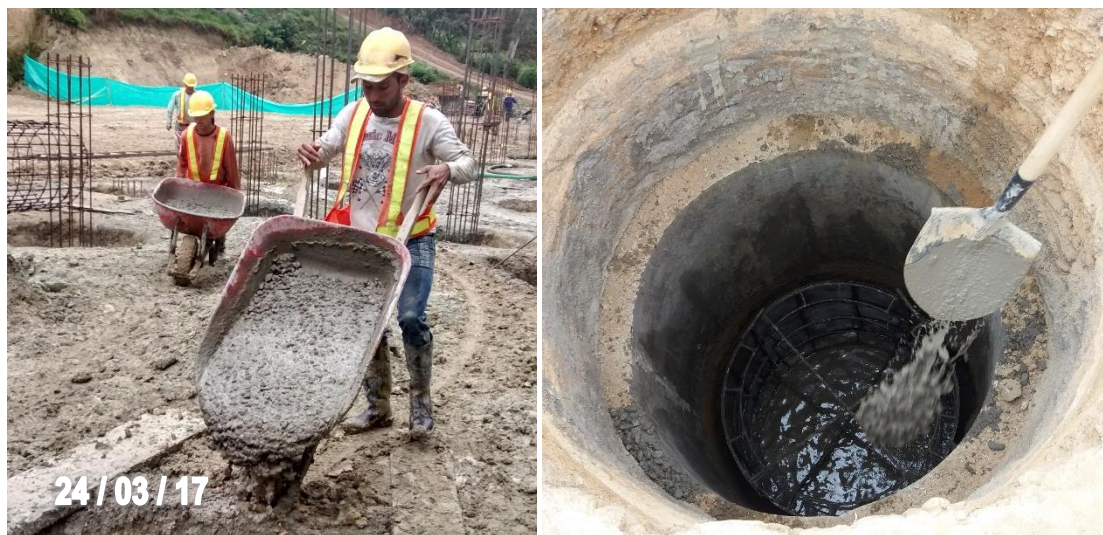
Figura 46. Procedimiento de vaciado del concreto para pilas.
