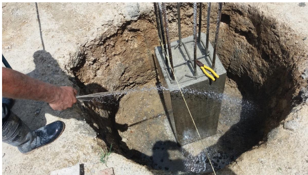
Figura 87. Curado de pedestal del Eje 4.
