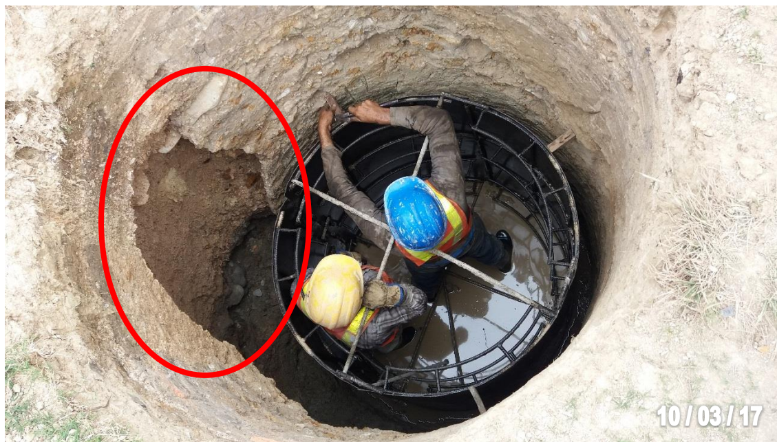
Figura 32. Colocación de formaleta metálica para fundición de anillo en H7.
