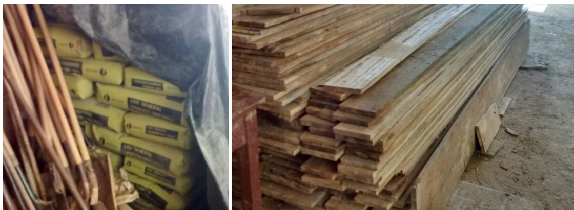
Figura 74. Condiciones de almacenamiento del cemento y madera en bodega.
