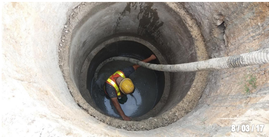
Figura 34. Bombeo del nivel freático después del desencofrado de los anillos.
