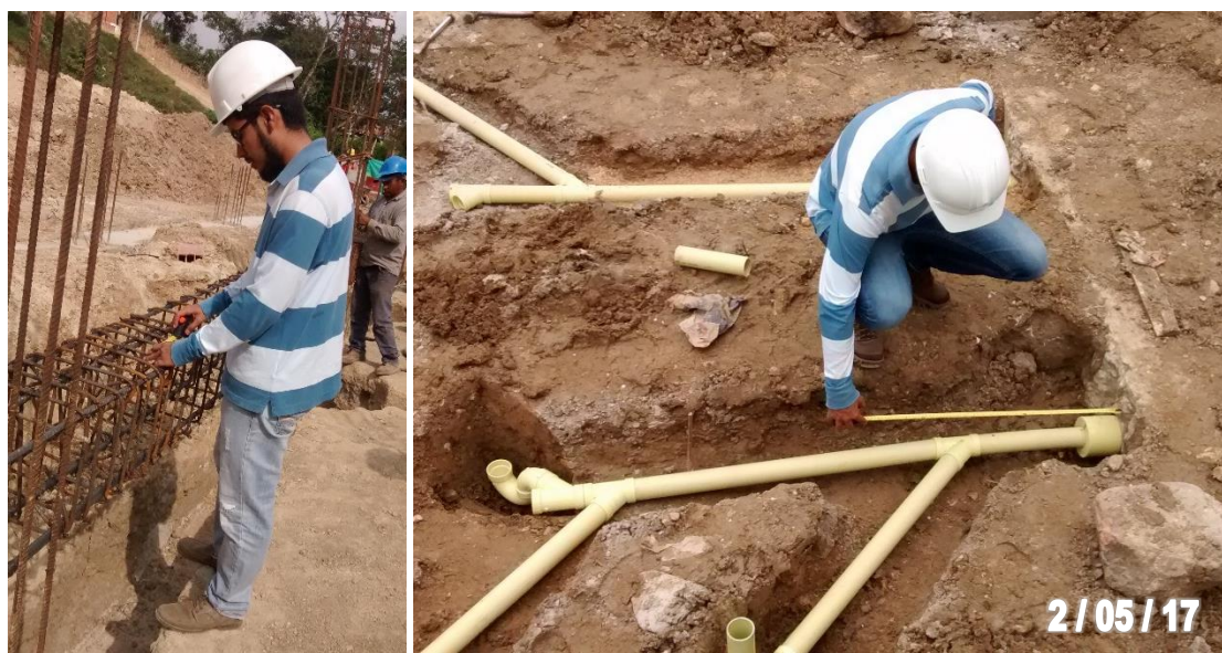
Figura 27 Verificación de distancias entre estribos de vigas y puntos hidráulicos.
