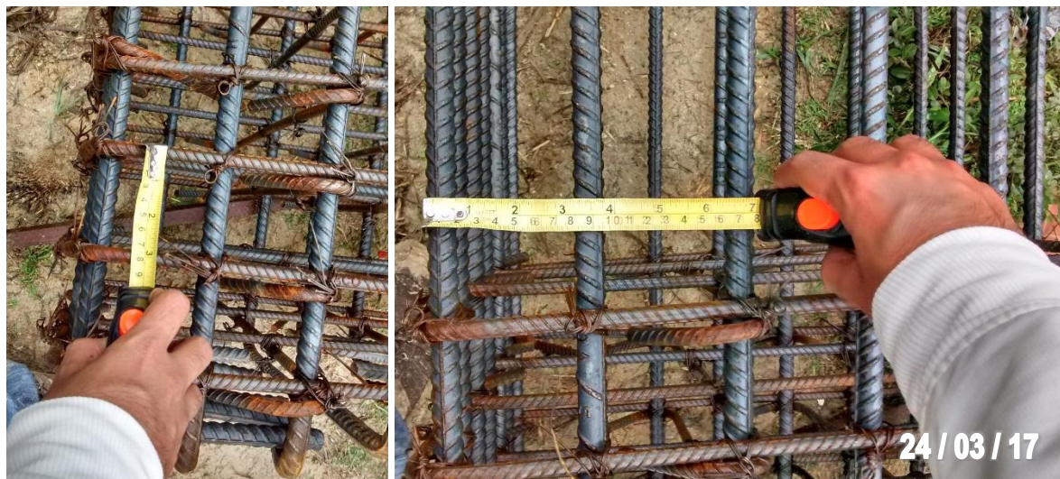
Figura 60. Verificación de separación de refuerzo de acero para columnas de cubierta.
