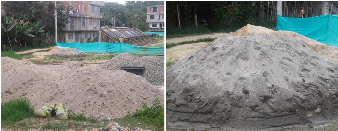
Figura 82. Condiciones de almacenamiento del agregado fino
