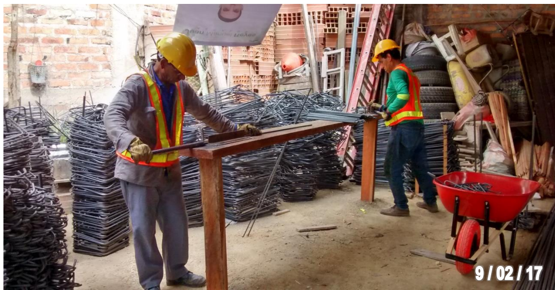
Figura 55. Figurado de estribos 3/8”.
