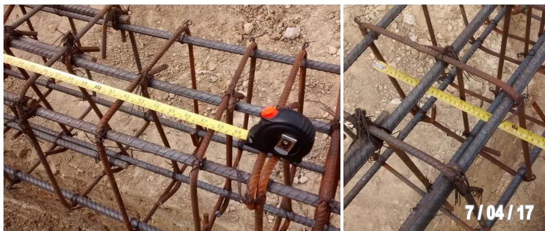
Figura 61. Verificación de separación de estribos en vigas de cimentación.
