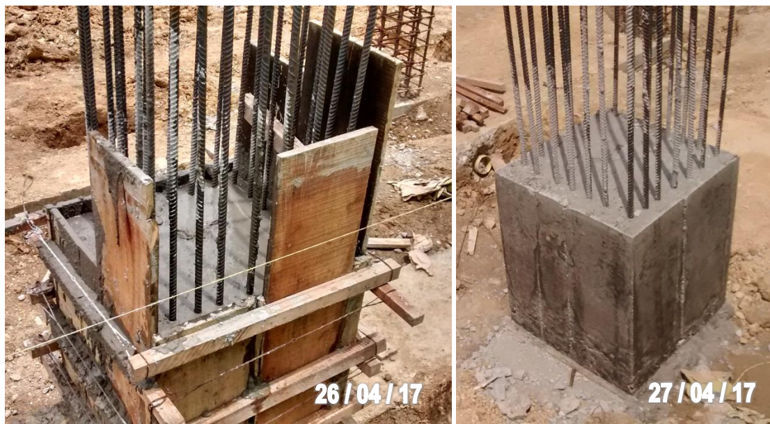
Figura 50. Fundición a nivel de viga, de columna 0.60 x 0.60 m del Eje 6.
