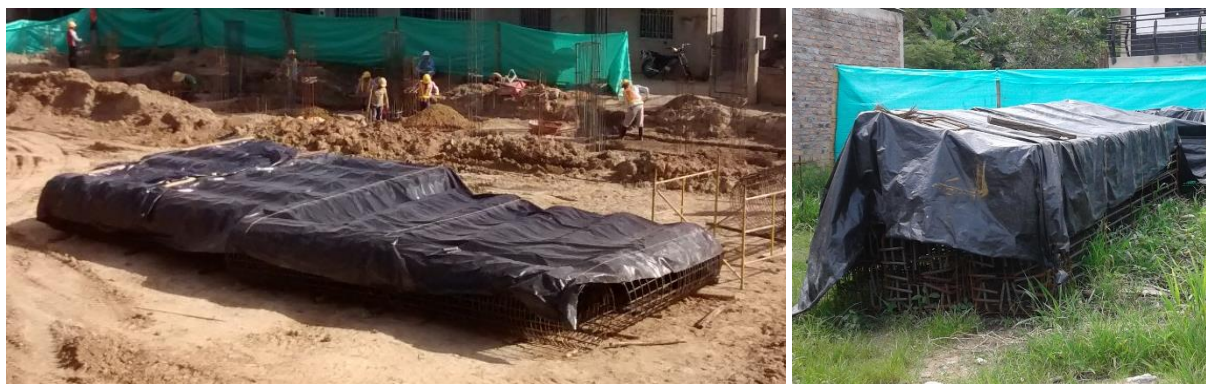
Figura 76. Condiciones de almacenamiento del acero figurado
