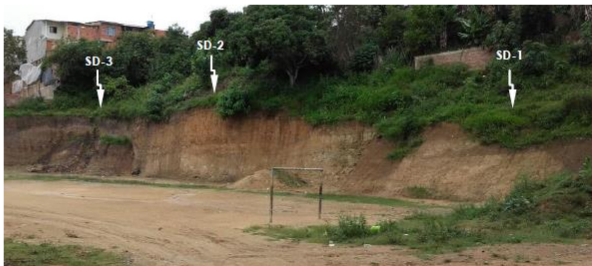
Figura 9. Ubicación de los sondeos sobre el talud.
