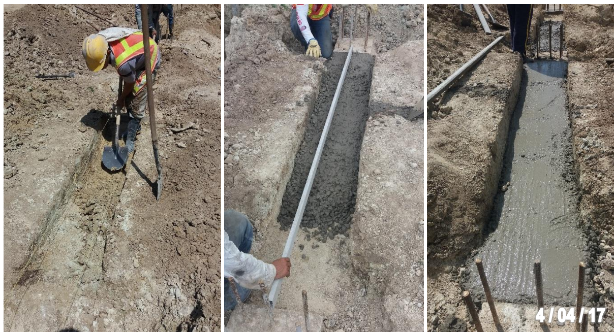
Figura 40. Fundición de solados de concreto para vigas de cimentación en el Eje 4.
