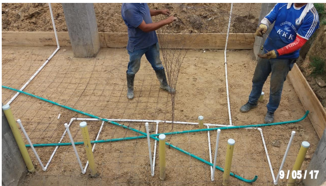
Figura 67. Instalación de la malla electrosoldada d84.
