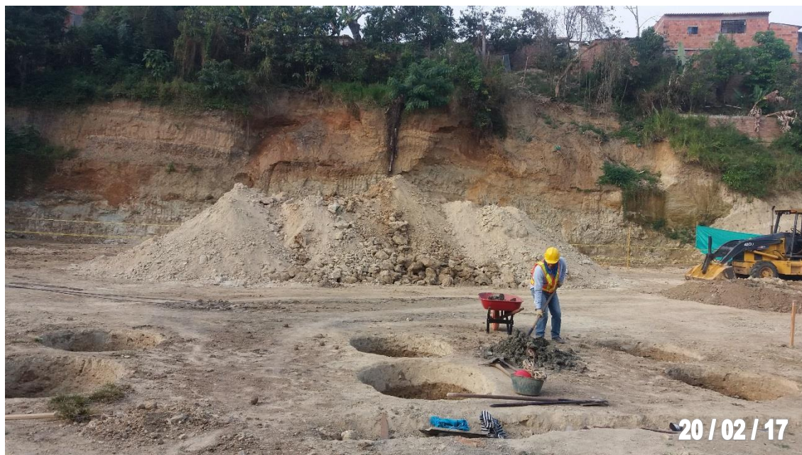
Figura 35. Excavación manual para pilas en el sector oriental.
