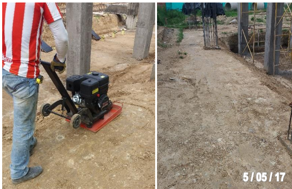
Figura 38. Compactación mecánica con vibrocompactador del área adyacente al Eje 7.
