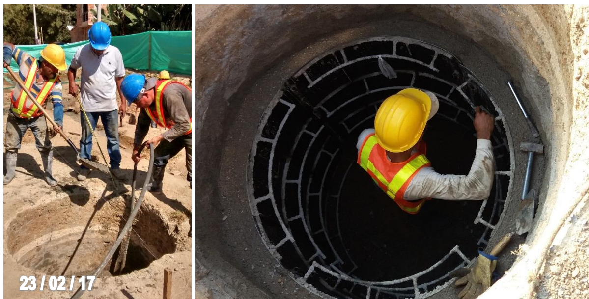
Figura 31. Fundición y vibrado de anillo de revestimiento para pila.
