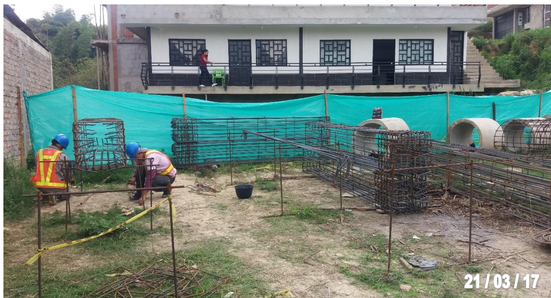
Figura 56. Armado de la estructuras de refuerzo 5/8” para columnas de cubierta.
