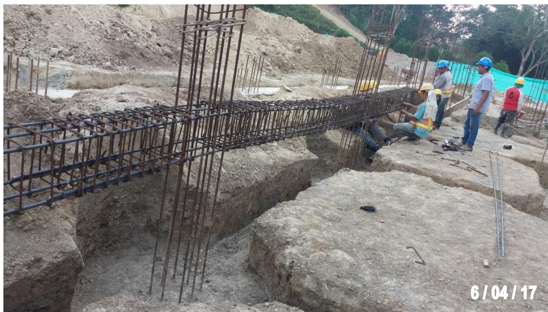
Figura 63. Colocación de estribos 3/8'' a estructuras de refuerzo para vigas en el Eje 5.
