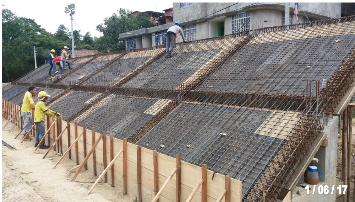
Figura 65. Armado de doble parrilla 5/8” para losa maciza de gradería.
