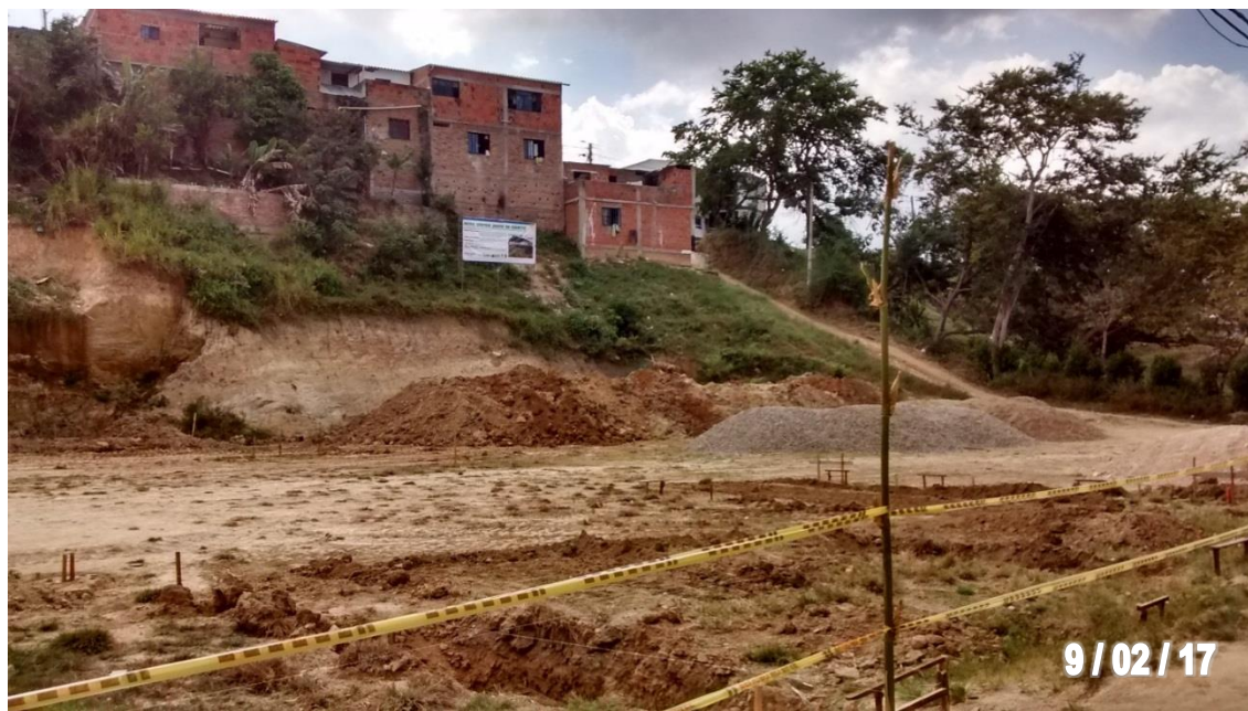
Figura 28. Localización y replanteo del terreno.
