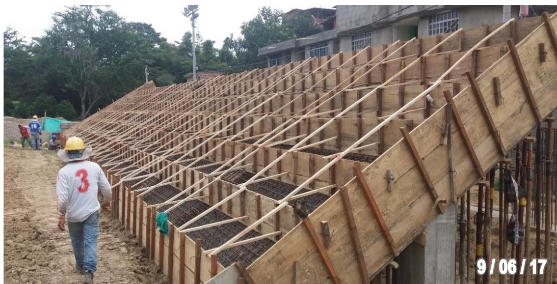
Figura 52. Encofrado de los escalones y la losa maciza de la gradería.
