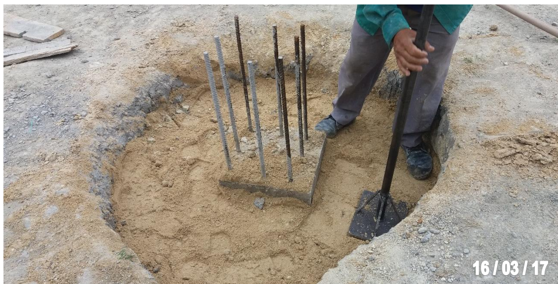
Figura 39. Relleno y compactación manual de pila del Eje 4.
