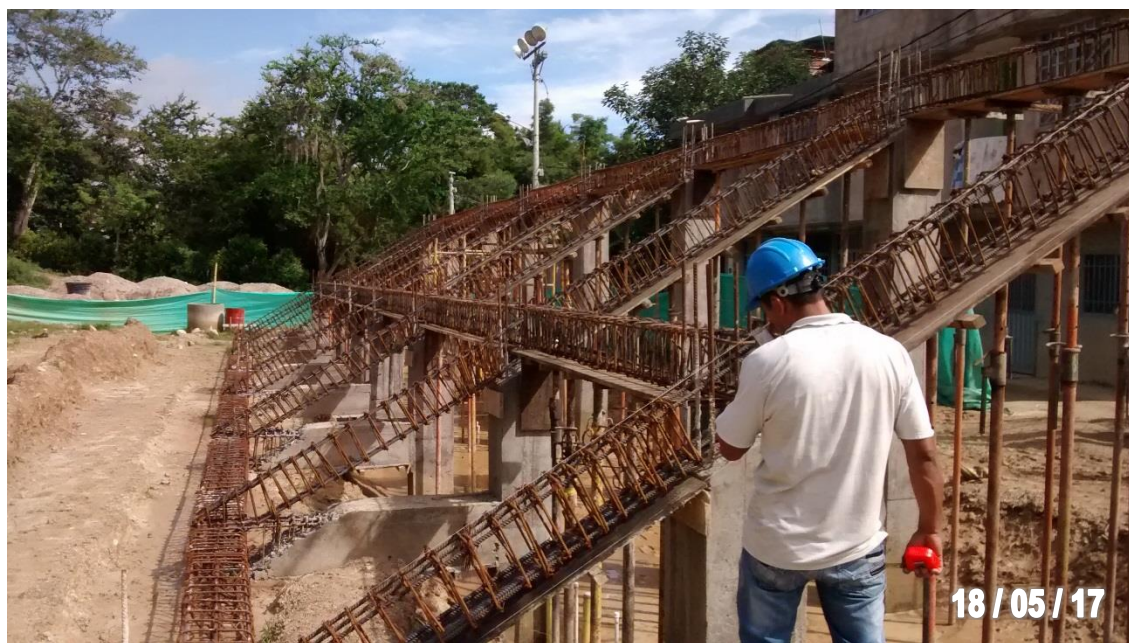
Figura 64. Verificación de distancia entre estribos para vigas de gradería.
