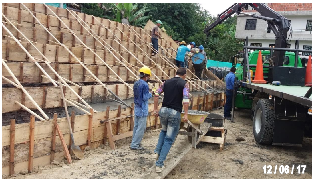
Figura 53. Fundición de los escalones de la gradería.
