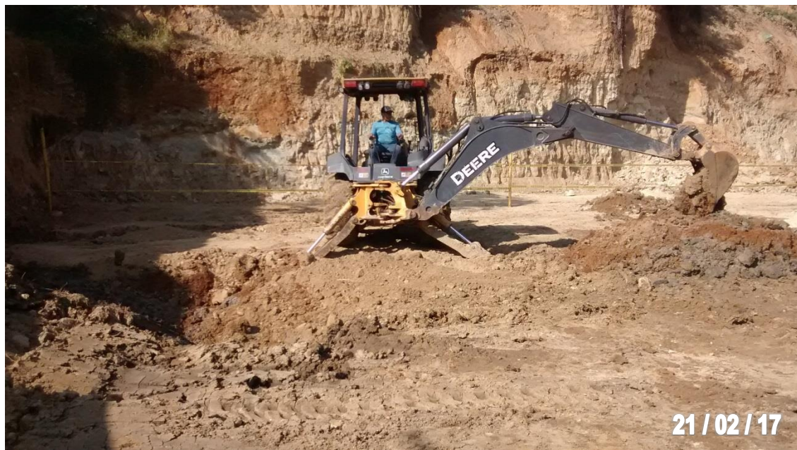
Figura 36. Remoción mecánica del suelo orgánico del sector sur del proyecto.
