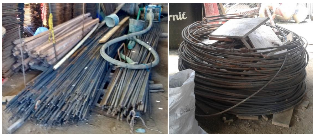
Figura 75. Condiciones de almacenamiento del acero de refuerzo sin figurar.
