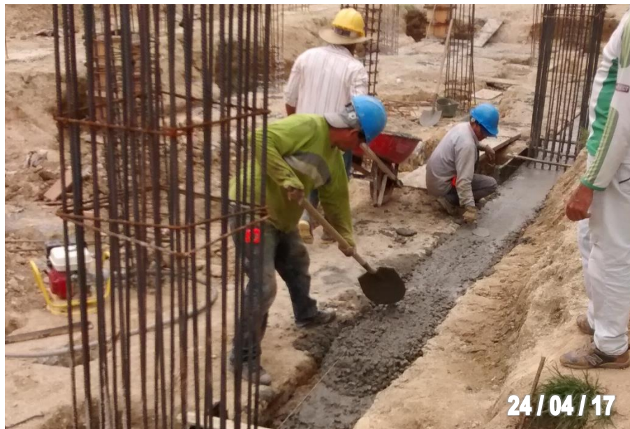
Figura 48. Viga de cimentación de 0.45 x 0.50 m del Eje 7 para gradería.
