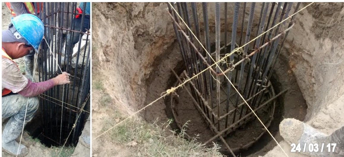
Figura 44. Verificación de verticalidad y ubicación respecto a los ejes en Eje 7.
