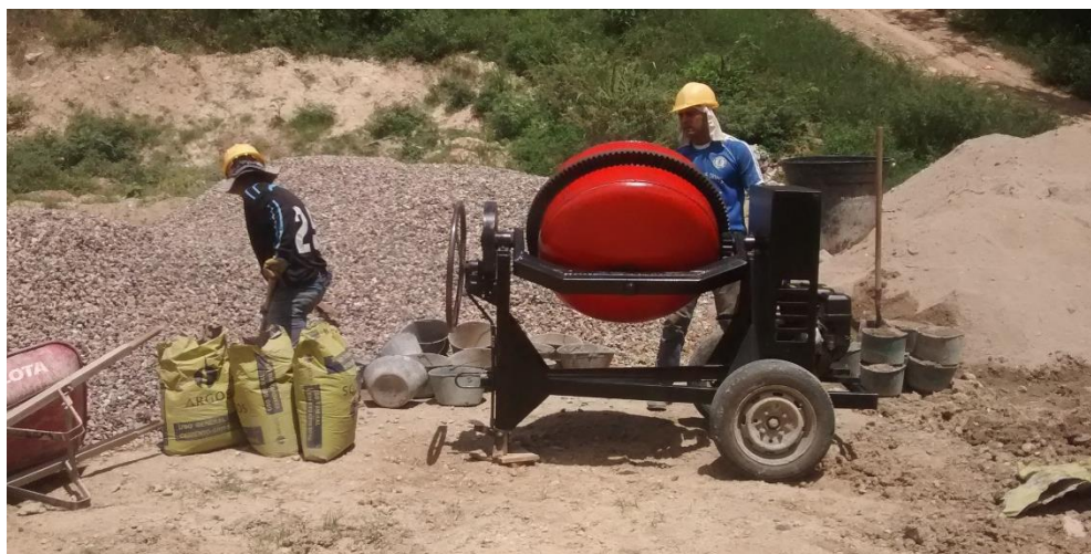
Figura 45. Elaboración de concreto en obra con mezcladora de 1 bulto.
