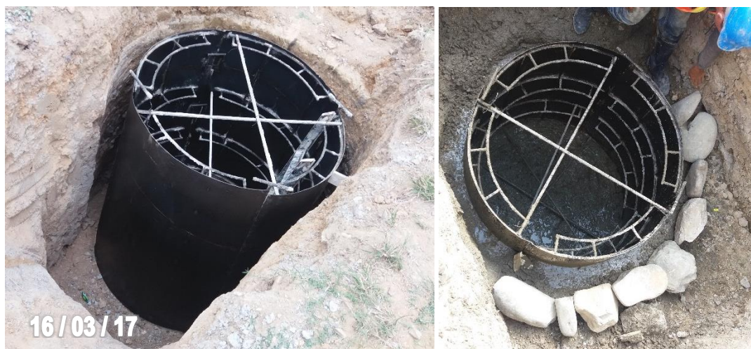
Figura 33. Relleno con piedra y material granular en E7 ante de la fundición
