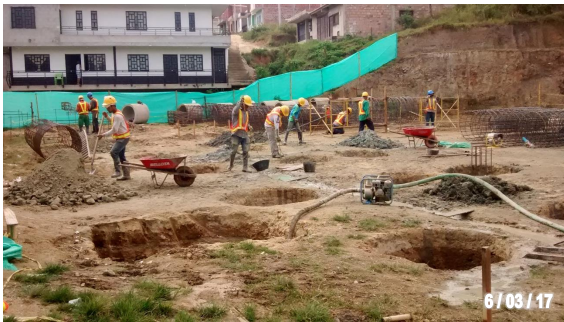
Figura 30. Cuadrillas de excavación 0:2 con bombeo para pilas del sector oriental.
