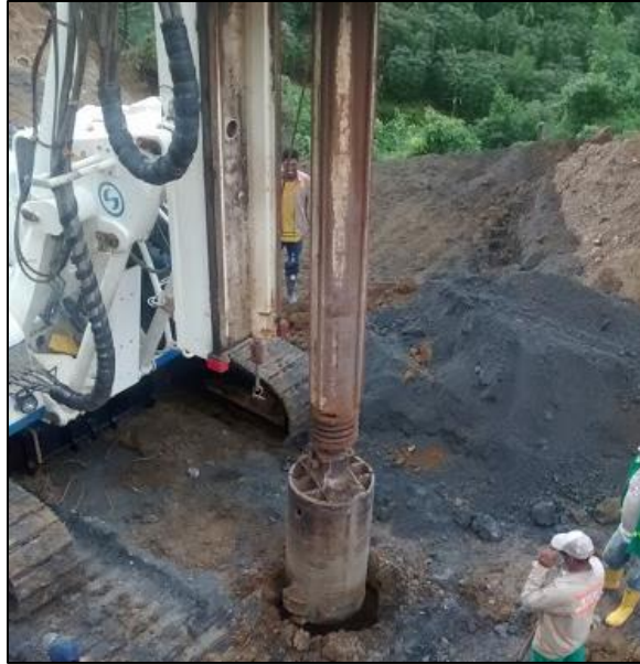
Fotografía. 52. Inicio de la perforación para los pilotes
