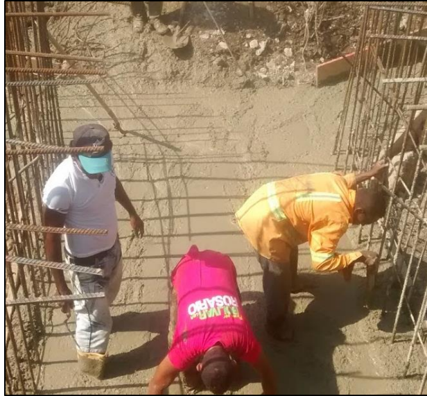
Fotografía. 67. Inicio de fundida de box en concreto de 4000 psi
