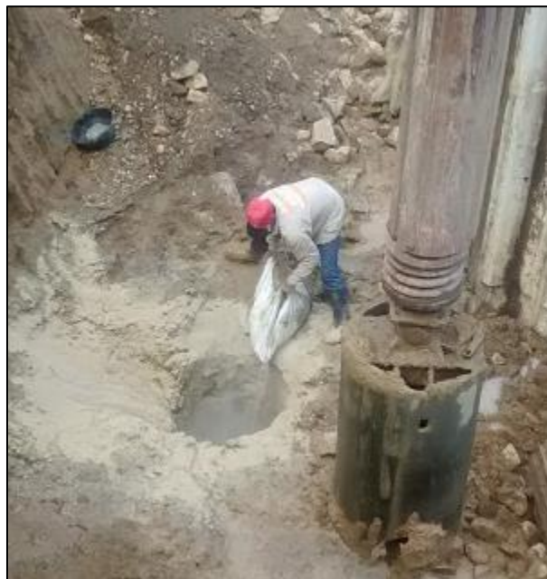
Fotografía. 55. Aplicación de bentonita
