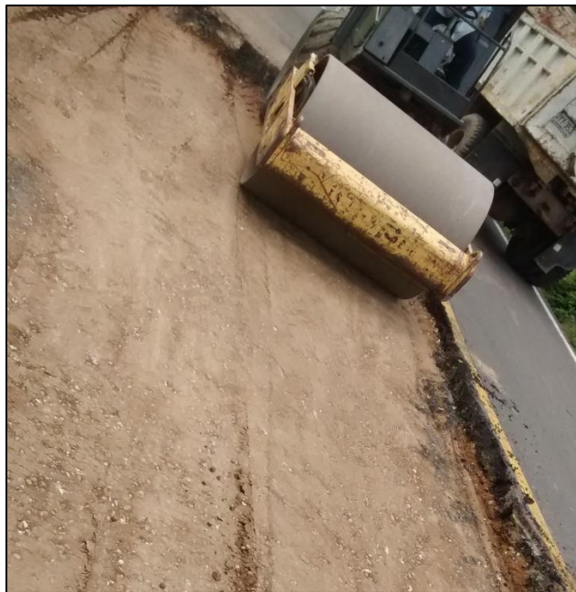
Fotografía. 38. Compactación de la superficie con suelo cemento
