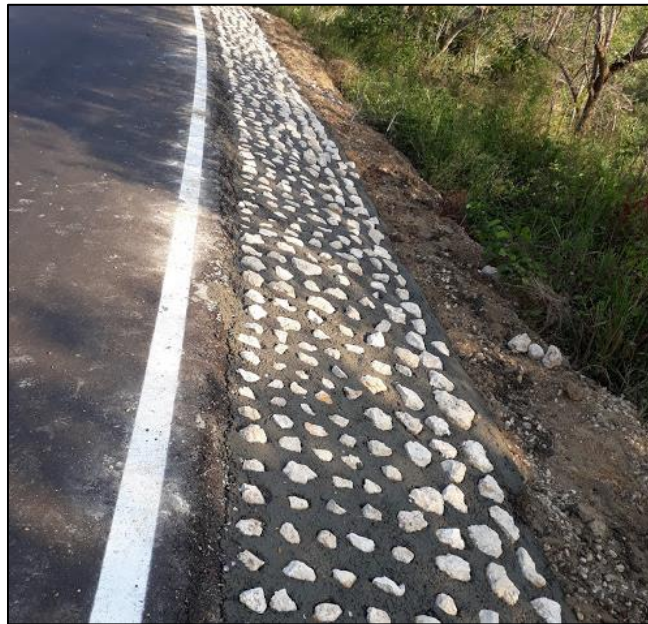
Fotografía. 78. Enrocado de protección fundido en concreto de 3000 psi
