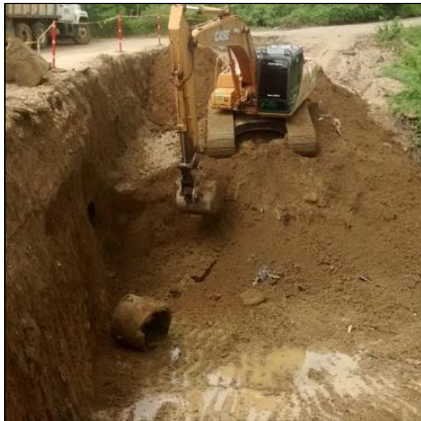
Fotografía. 50. Excavación y arreglo de terreno para el muro de contención
