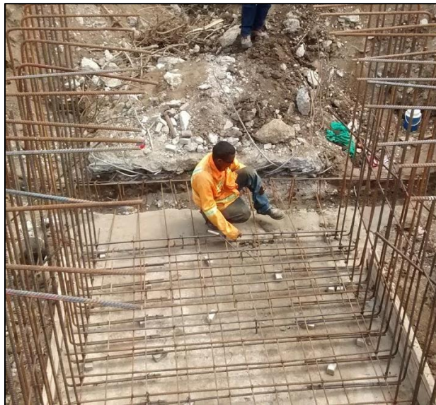
Fotografía. 66. Armado de losa inferior, muros laterales y solera
