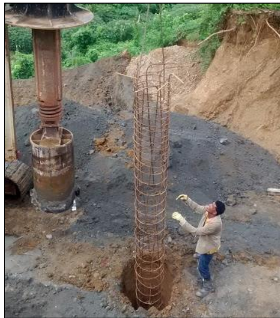
Fotografía. 53. Colocación de armadura del pilote
