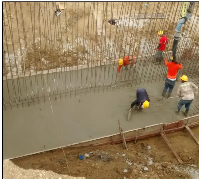
Fotografía. 62. fundida de zapata
