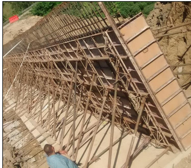
Fotografía. 64. Colocación de gatos hidráulicos para asegurar formaletas
