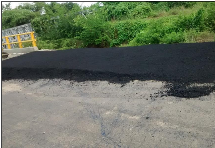
Fotografía. 48. renivelación de un carril de la losa de aproximación
