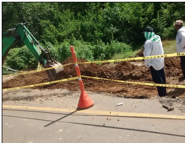
Fotografía. 21. Demolición de carpeta y excavación de material contaminado Fuente: autor del proyecto
