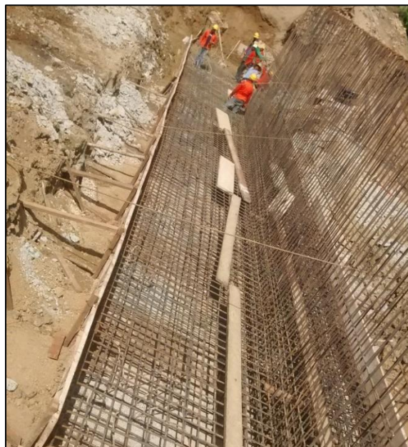
Fotografía. 60. Armado de muro
