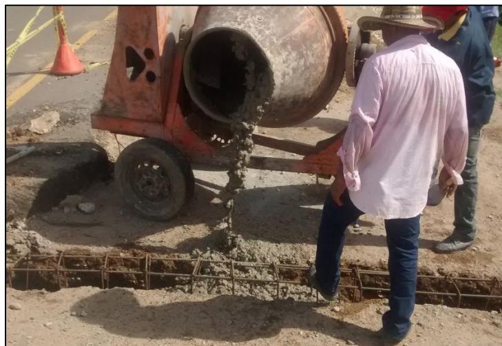
Fotografía. 29. Fundida de losa de aproximación
