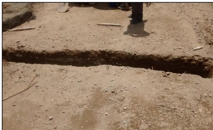
Fotografía. 26. Excavación para la viga de la losa de aproximación
