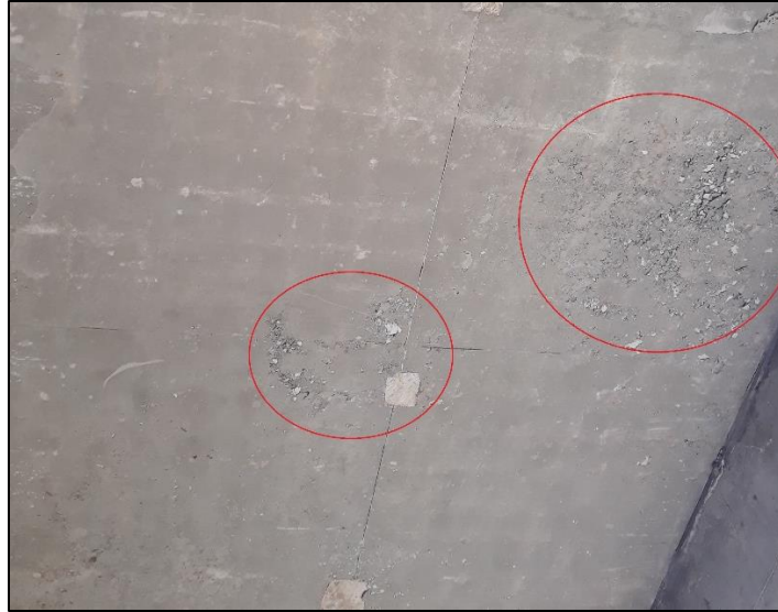
Fotografía. 15. Segregación en uno de los paneles de la losa
