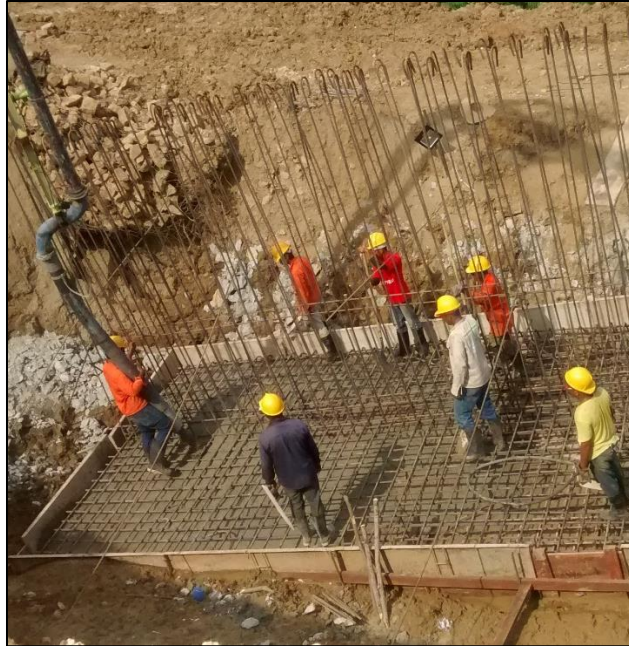
Fotografía. 61. Inicio de fundida de zapata
