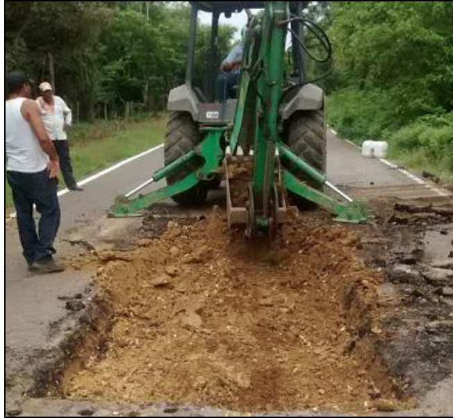
Fotografía. 34. Demolición de carpeta en uno de los puntos que presenta piel de cocodrilo
