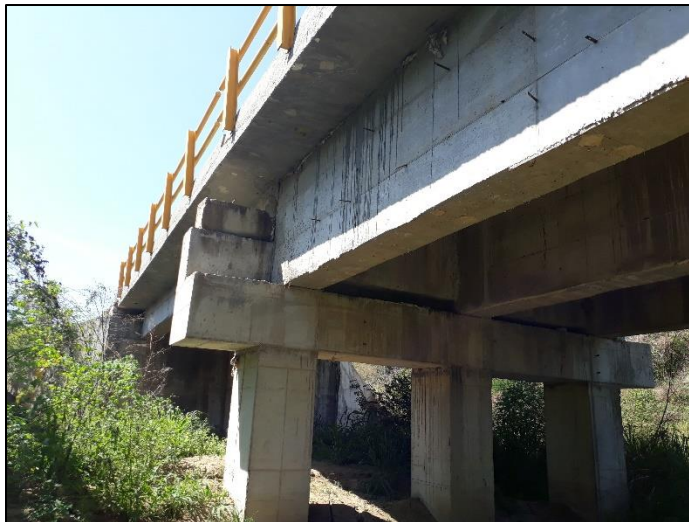
Fotografía. 19. Pilas en buen estado
