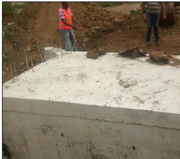
Fotografía. 68. Box coulvert fundido con concreto de 4000 psi
