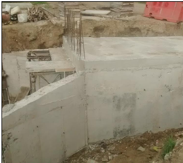
Fotografía. 73. Box coulvert fundido lado derecho en concreto de 4000 psi
