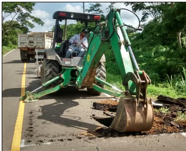
Fotografía. 31. Demolición de carpeta en punto que presenta hundimiento
