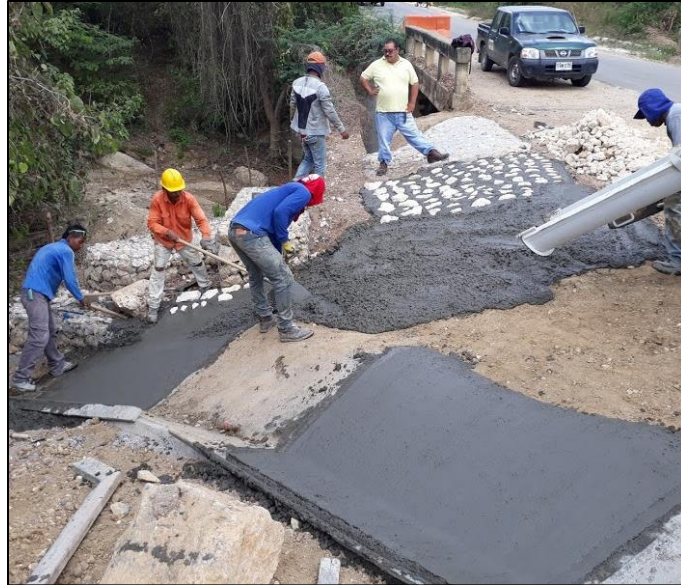
Fotografía. 75. Fundida de enrocado y fundida de cunetas – lado izquierdo (PR18+580)
