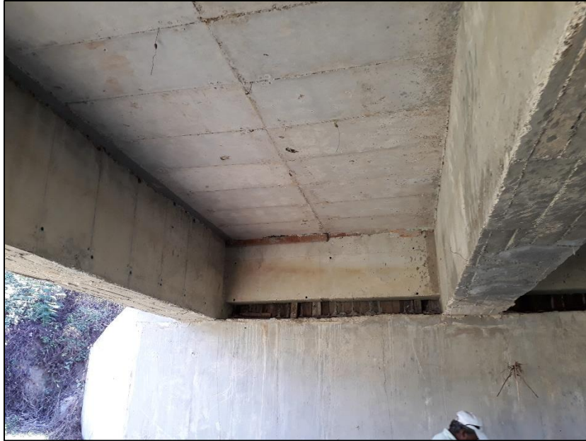
Fotografía. 12 vigas, losa y estribo
