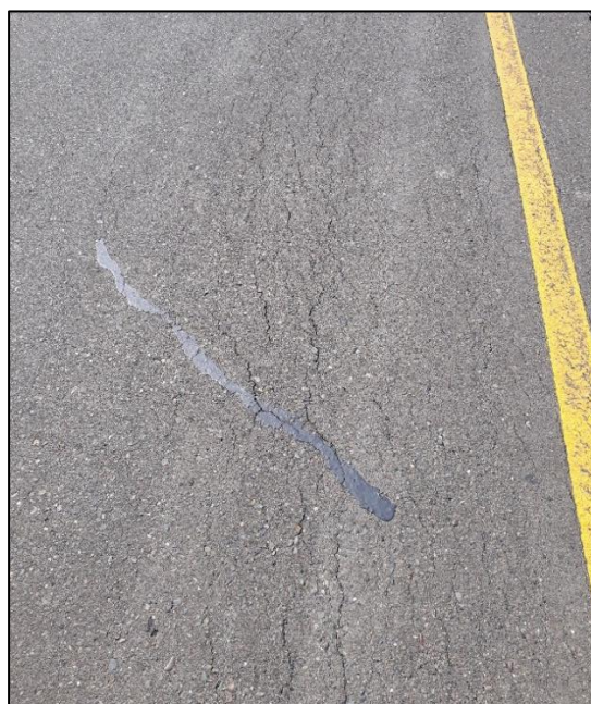
Fotografía. 1. Fisuración incipiente.
