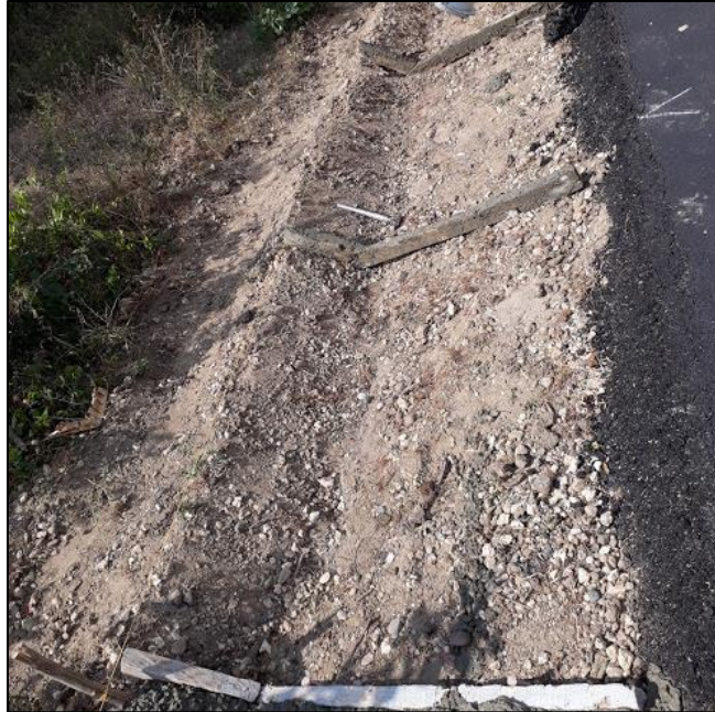
Fotografía. 79. Arreglo de terreno para cunetas de 1,50 mts *2,10 mts
