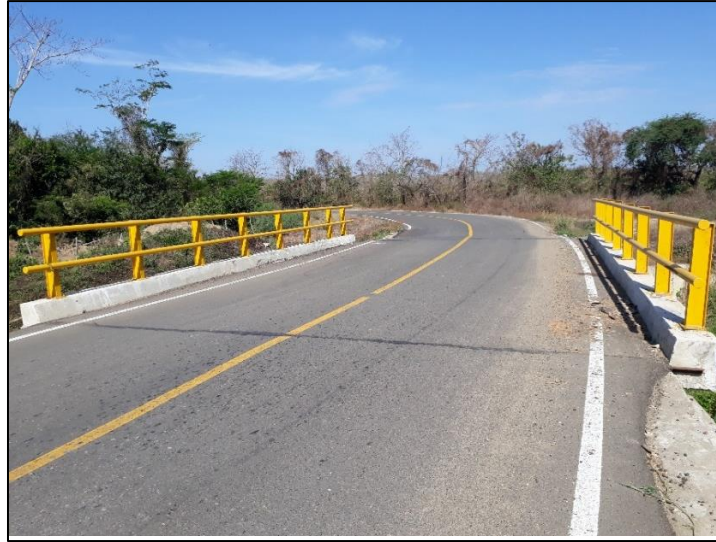
Fotografía. 10 Superficie del puente “puente del siete”
