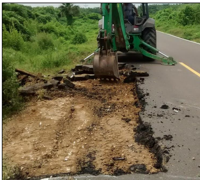
Fotografía. 33. Demolición de carpeta en uno de los puntos que presenta fisura de borde Fuente: autor del proyecto
