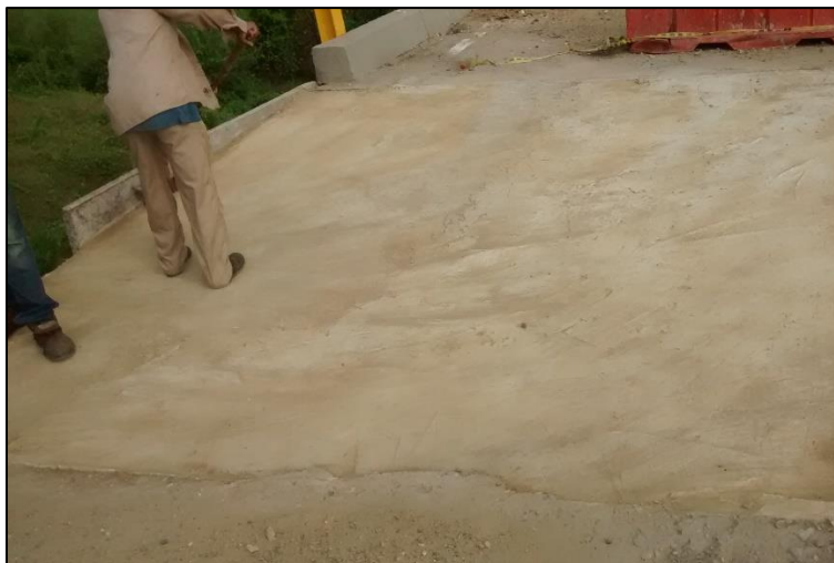
Fotografía. 45. Limpieza de losa de aproximación para el asfalto
