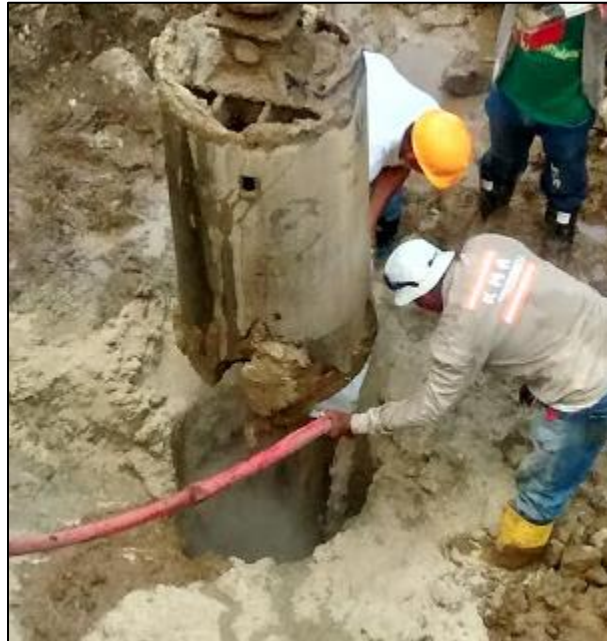
Fotografía. 56. Aplicación de agua para formar el lodo bentonítico
