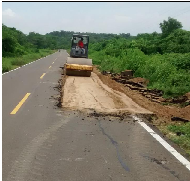
Fotografía. 39. Compactación de la superficie con suelo cemento
