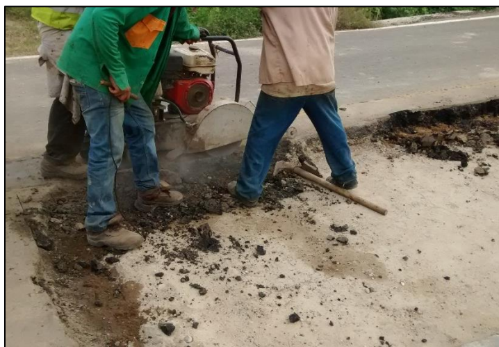
Fotografía. 40. Perfilada de bordes para echar asfalto (parqueo)
