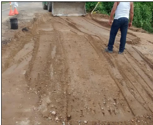
Fotografía. 36. Extendida de suelo cemento con ayuda de un retro cargador
