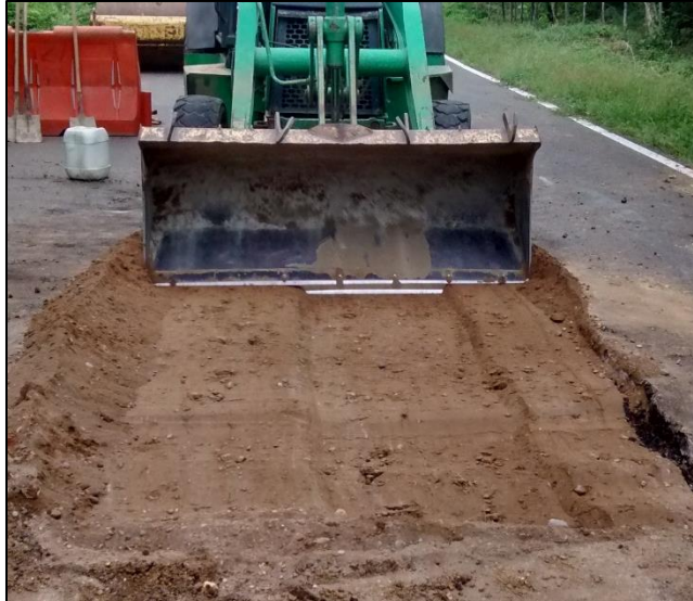
Fotografía. 37. Extendida de suelo cemento con retro cargador
