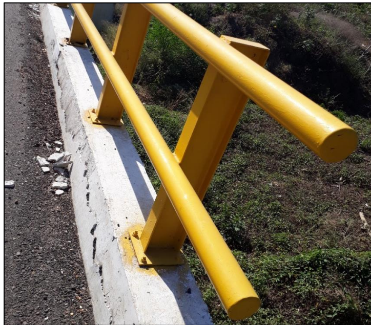
Fotografía. 11 Barandas y Bordillos
