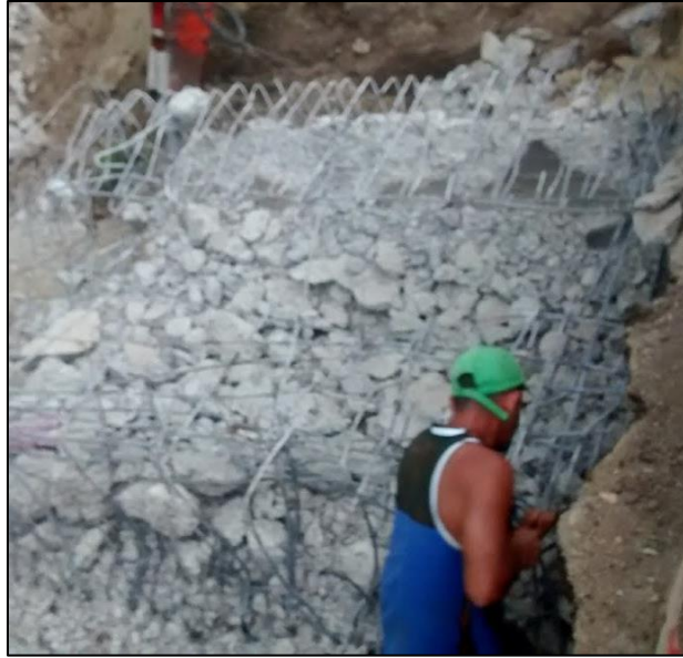
Fotografía. 65. Demolición y limpieza de box couvert-carril izquierdo
