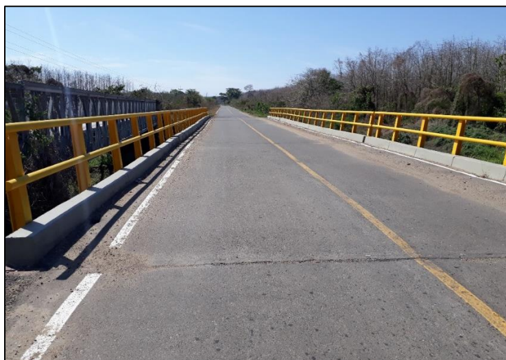
Fotografía. 14 calzada en asfalto, bordes y barandas
