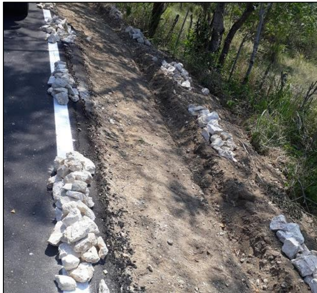
Fotografía. 76. Arreglo de terreno para enrocado
