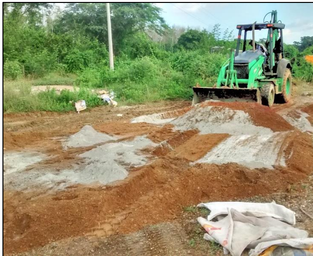
Fotografía. 35. Mezcla de material para suelo cemento
