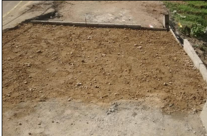
Fotografía. 30. Losa fundida con arena húmeda para el curado
