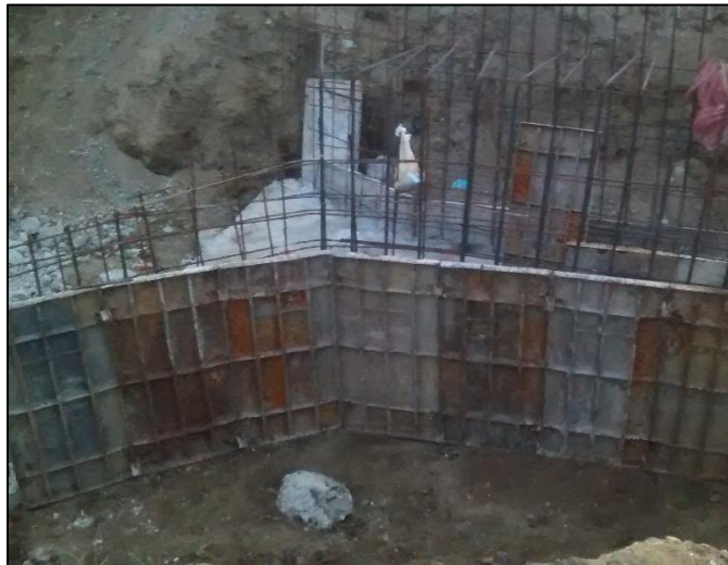
Fotografía. 72. Encofrada para fundir box culvert
