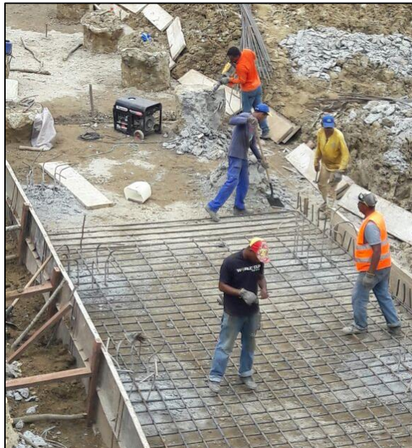
Fotografía. 59. Descabezado de pilotes, encofrado y armada de zapata
