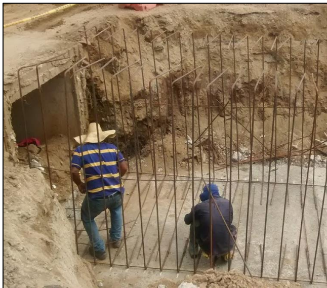
Fotografía. 70. Inicio Armado de acero
