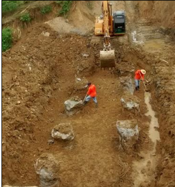
Fotografía. 57. Excavación para descubrir los pilotes a nivel de la zapata
