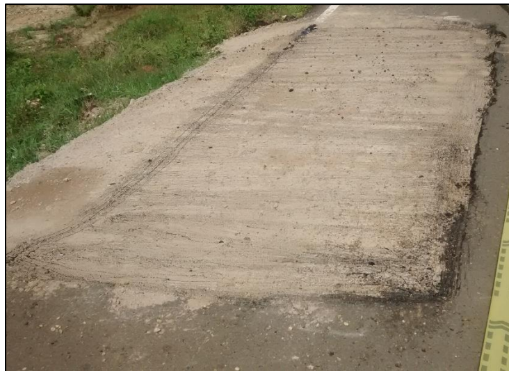
Fotografía. 42. Parche con liga listo para echar asfalto
