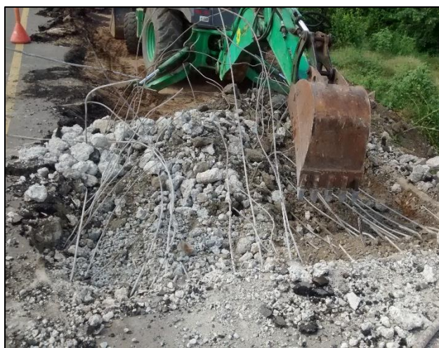
Fotografía. 20. Demolición de losa de aproximación del puente Santa Teresa Fuente: autor del proyecto
