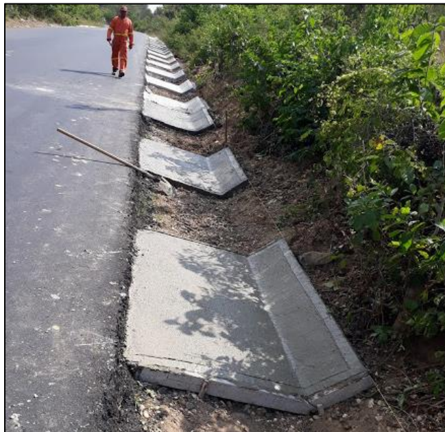
Fotografía. 80. Fundida de cunetas revestidas en concreto de 3000 psi
