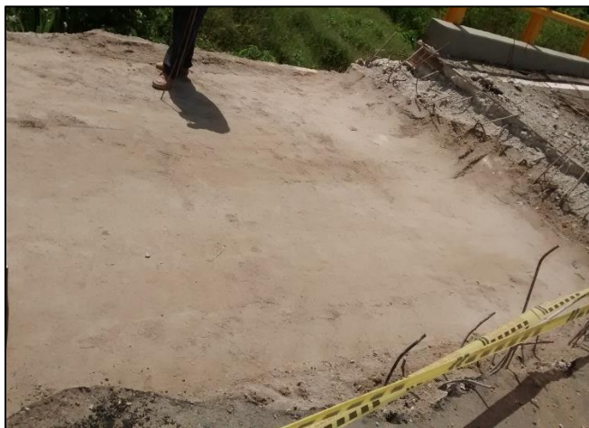
Fotografía. 25. superficie mejorada con suelo cemento
