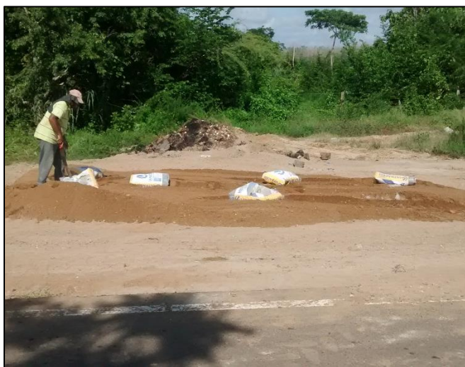
Fotografía. 23. Material húmedo extendido para mezclar con cemento
