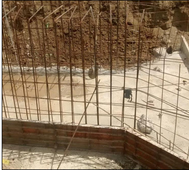
Fotografía. 71. Fundida de losa inferior
