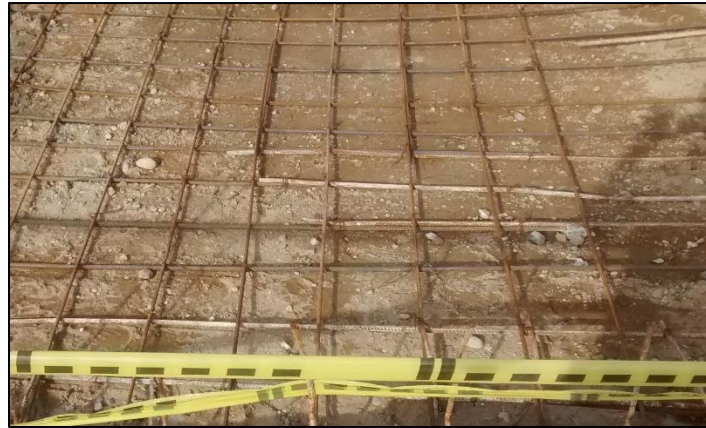
Fotografía. 28. Armado de losa de aproximación
