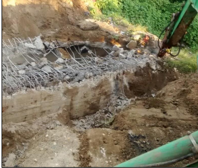
Fotografía. 69. Demolición de box culvert – carril derecho
