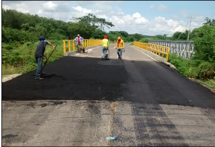
Fotografía. 49. renivelación de los dos carriles de la losa de aproximación
