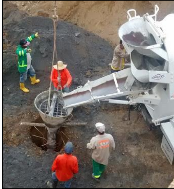
Fotografía. 54. Inicio de fundida de los pilotes con concreto tremie 4000 psi
