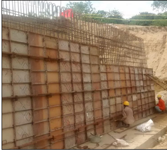
Fotografía. 63. Encofrado de muro
