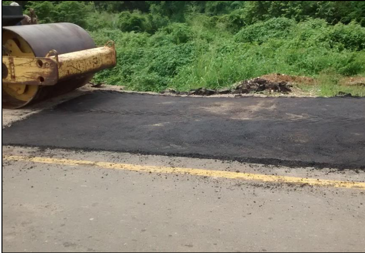
Fotografía. 47. Compactación de asfalto sobre el hundimiento
