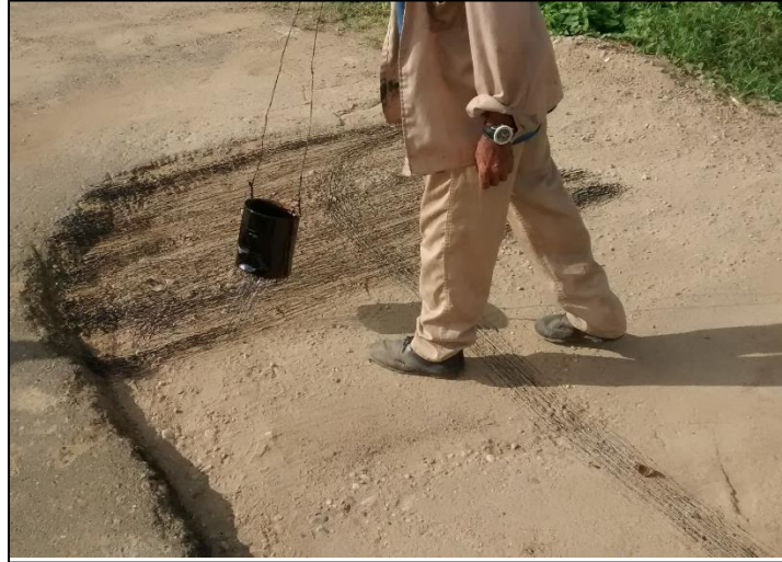
Fotografía. 41. Riego de liga para asfalto
