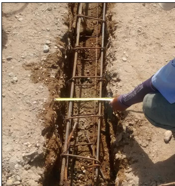
Fotografía. 27. Medida de viga lista para fundir
