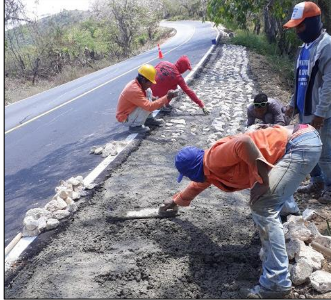
Fotografía. 77. Fundida de enrocado de 170 mts * 1,50 mts- lado derecho (PR17+000)
