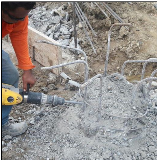
Fotografía. 58. Descabezado de los pilotes
