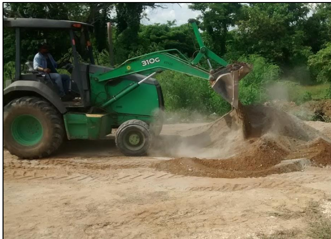
Fotografía. 24. Mezcla de material húmedo con cemento (suelo cemento)
