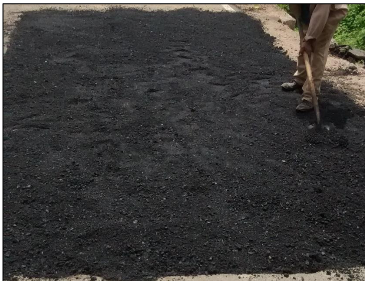
Fotografía. 43. Regando el asfalto en uno de los parches
